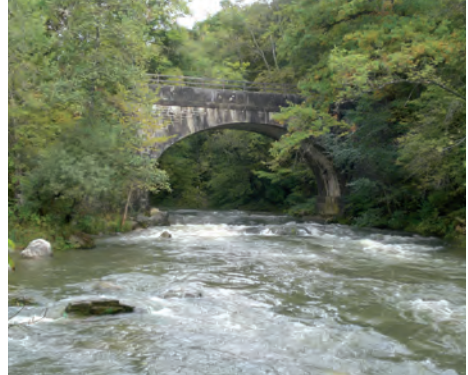
Le pont des Granges sur l'Allondon (GE)
