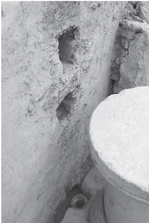
Abb. 110: 38b, N-Umgang, Öffnungen für die Zuleitungen zum Badebecken in 38e
