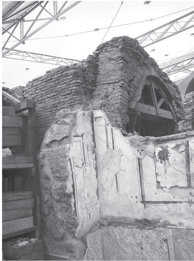
Abb. 131: 38d, Blick auf die südliche Zungenmauer mit Bogenansatz
