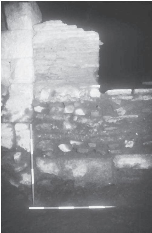
Abb. 43a: Tür zwischen den Räumen 45 und 45c, Detail des östlichen Bereichs mit älterer, tiefer liegender Schwelle
