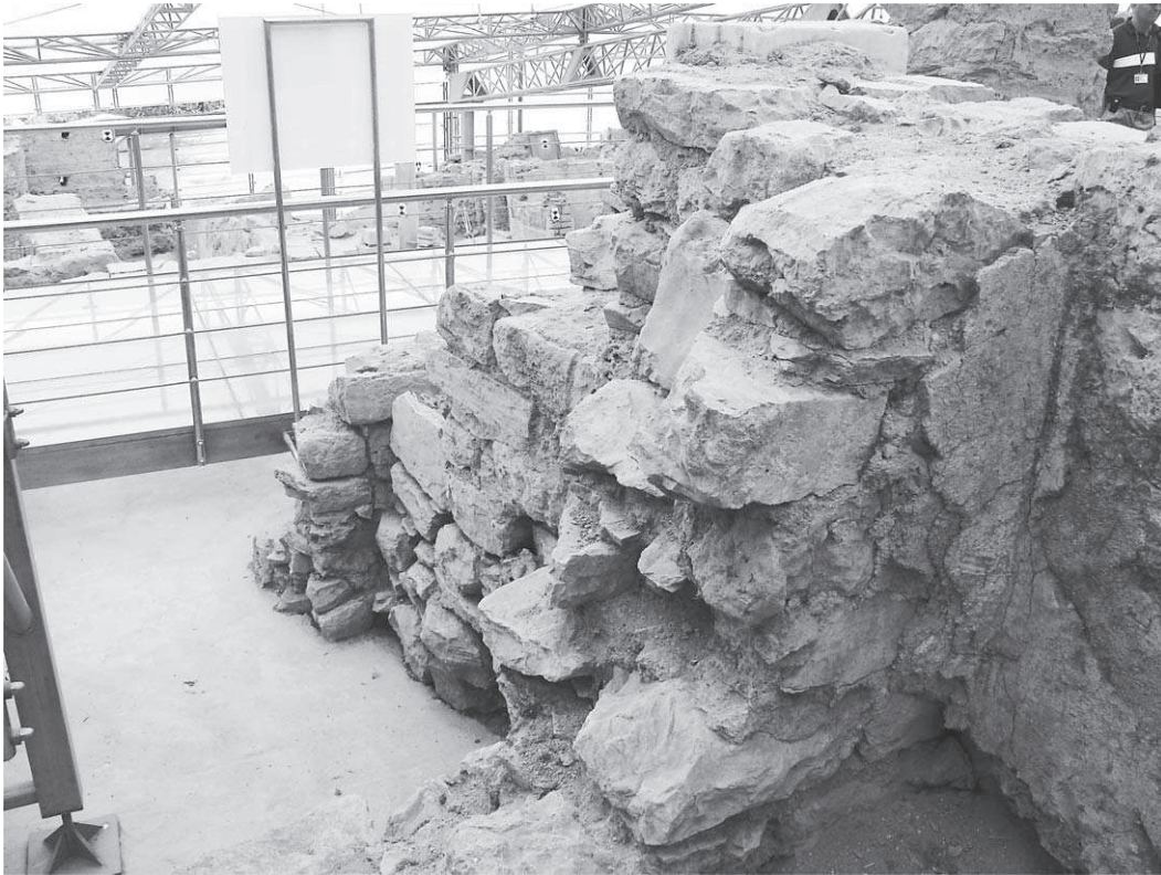
Abb. 43: 34b, NO-Ecke mit Putzschicht
