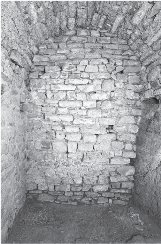
Abb. 54: T IV.UG, südlicher Raum, O-Mauer
