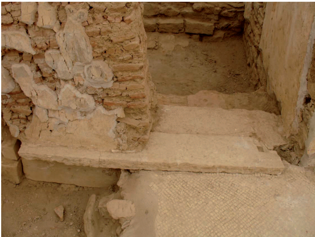
Abb. 2: Schwelle zwischen 38b und 38f mit dem angesetzten Mosaikboden
