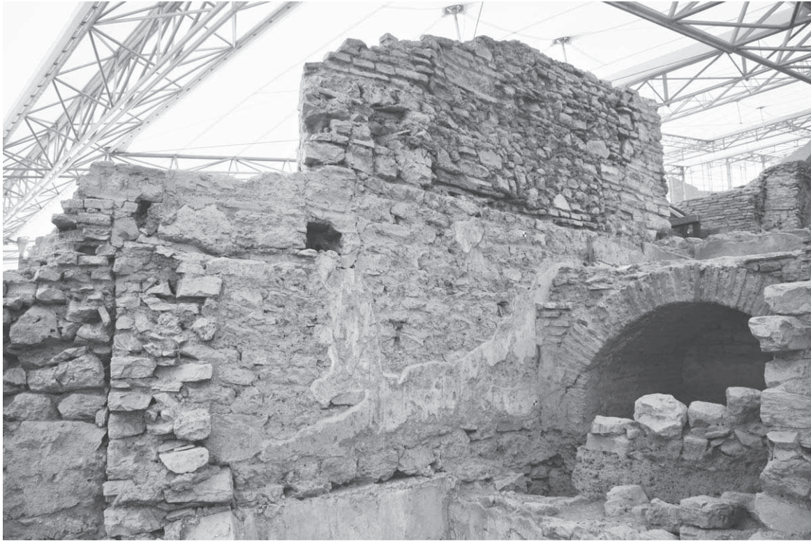
Abb. 1: Blick auf die O-Mauern von 38i und 38g sowie das Gewölbe in 38g
