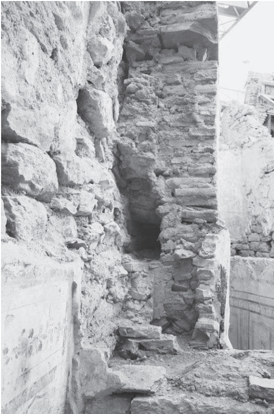
Abb. 28: 45b, O-Mauer, Abschnitt 2, Hohlformen von horizontalen und vertikalen Mauerwerks-Stabilisierungs-Anker
