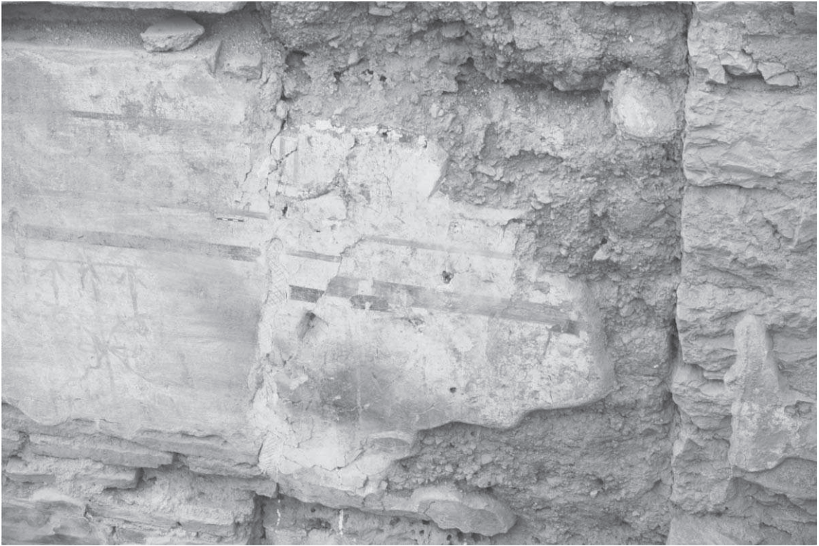
Abb. 32: 45b, O-Mauer, Abschnitt 2, Streifen von Trockenlehmziegeln
