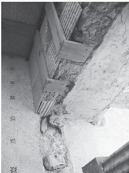
Abb. 122: Türöffnung zwischen 38c und 32e
