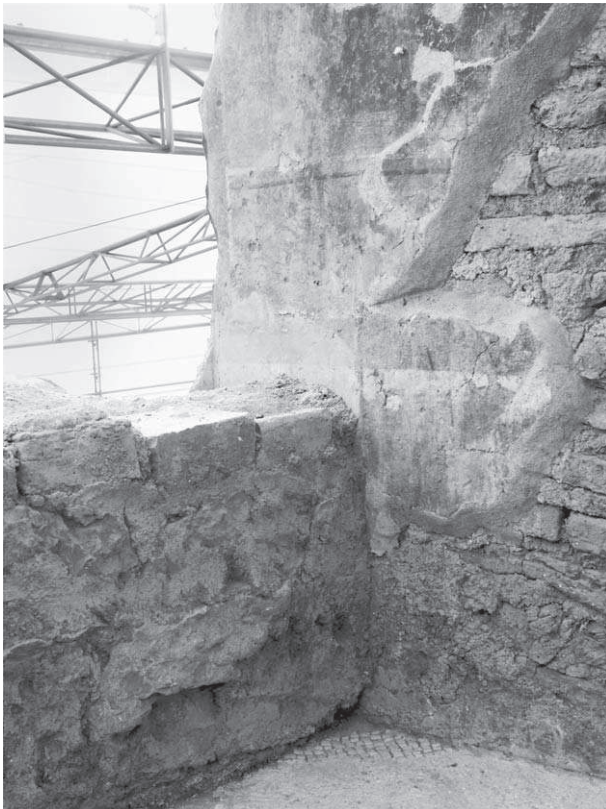
Abb. 2: 32c, Ansatz der N-Mauer an die O-Mauer (Detail)
