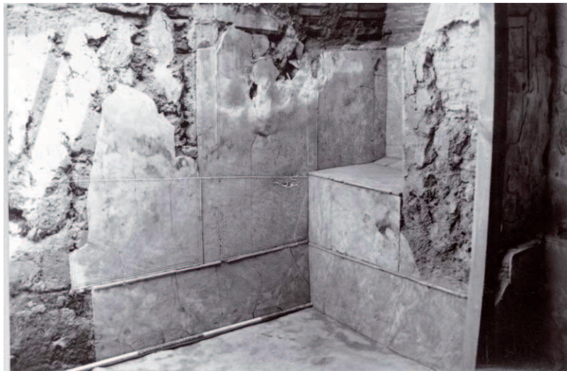
Abb. 10: Raum 38d, Marmorwandverkleidung im östlichen Raumteil
