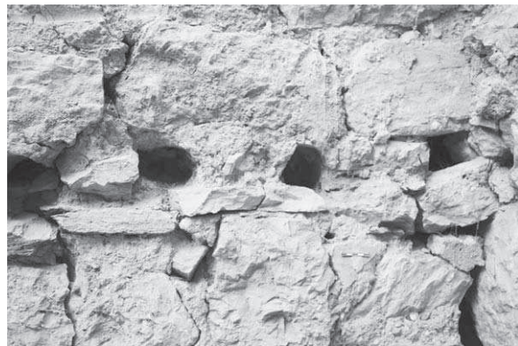
Abb. 22: 45a, O-Mauer, Balkenlöcher und Baufuge
