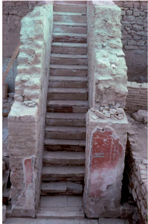
Abb. 23: Stiegenhaus 39, Ansicht von Norden
