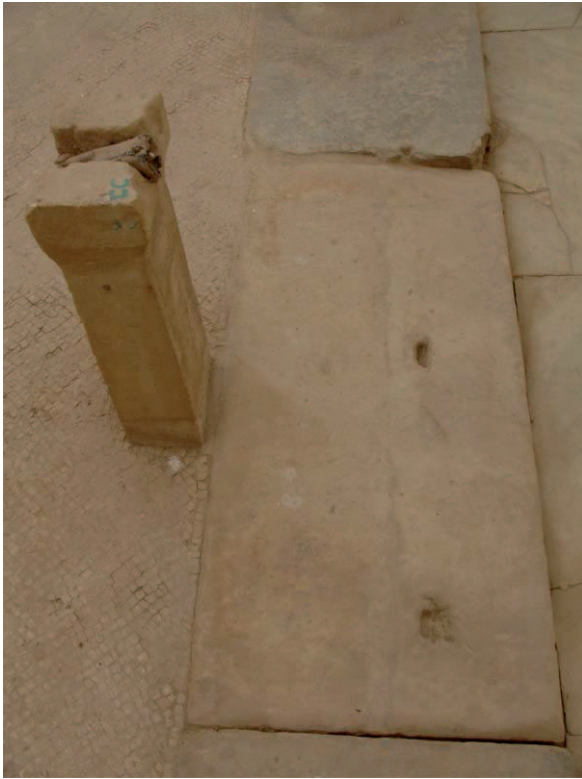
Abb. 3: 38b, N-Umgang, an Pfeiler angesetzter Mosaikboden
