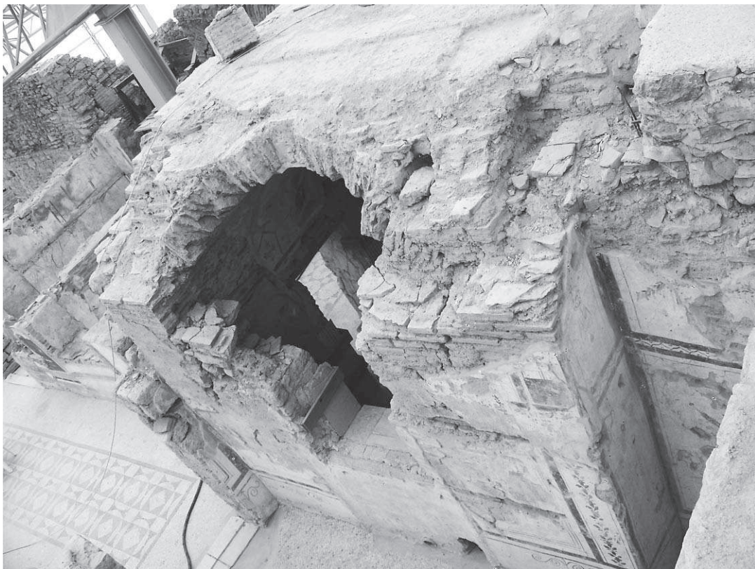
Abb. 120: Das Gewölbe von 38c, Ansicht von Westen
