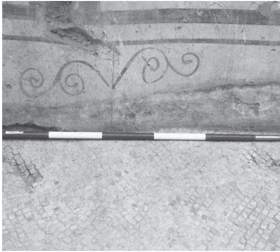
Abb. 79: Raum 38a, Schadenspuren im Mosaikboden
