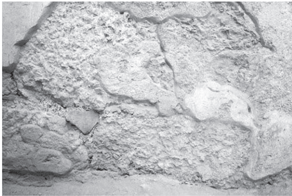
Abb. 23a: 45a, S-Mauer, Kalksteinbrekzie
