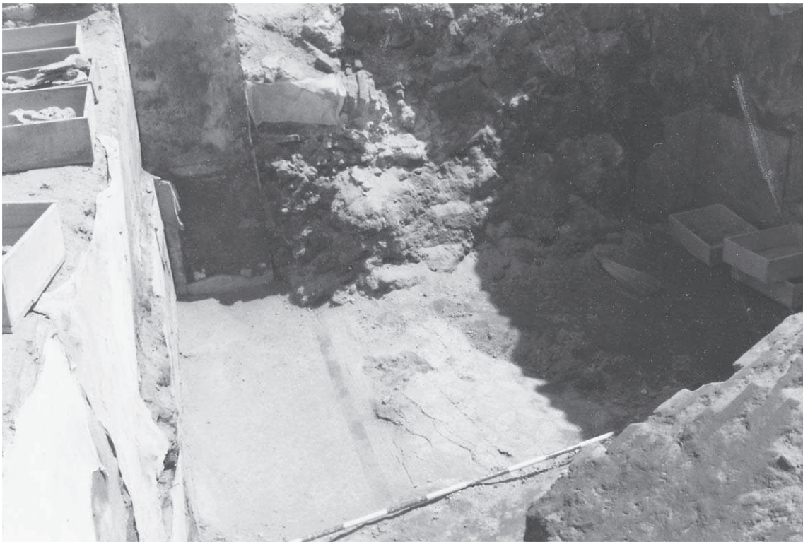
Abb. 128: 38d, Freilegung des östlichen Bereichs
