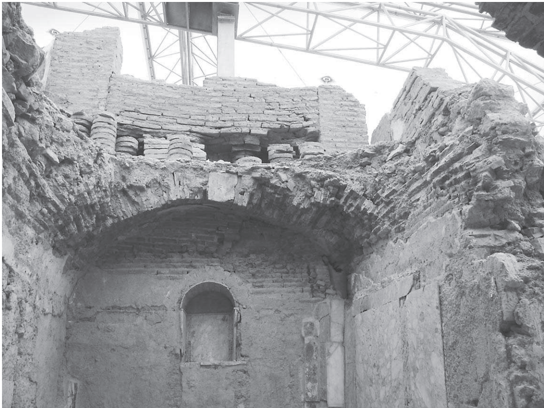
Abb. 4: 36c mit dem Abflussrohr in der NW-Ecke
