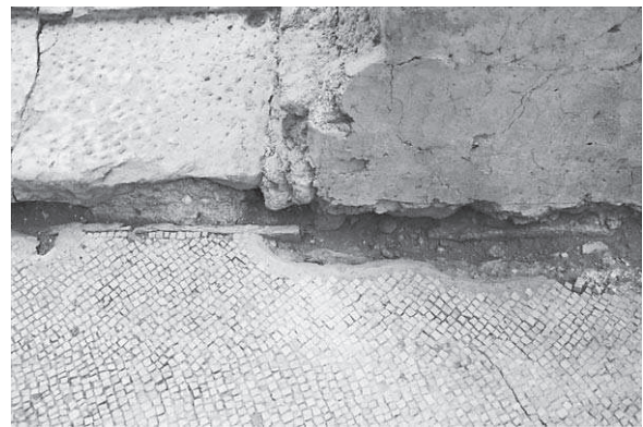
Abb. 16: 32e, an Marmorplatte vor W-Mauer angesetzter Mosaikboden
