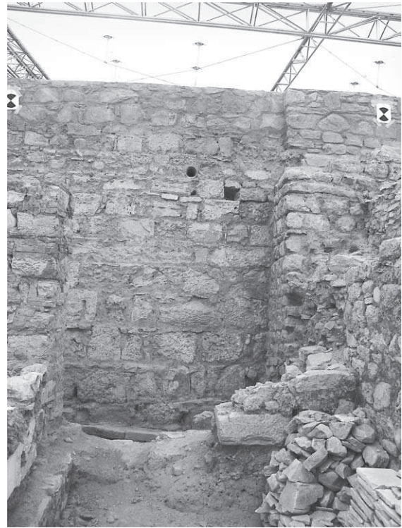
Abb. 28: 33, westlicher Teil der S-Mauer mit Mauer C
