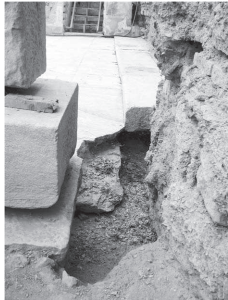
Abb. 8: Peristyl 38b, ausgerissene NW-Ecke des Stylobats
