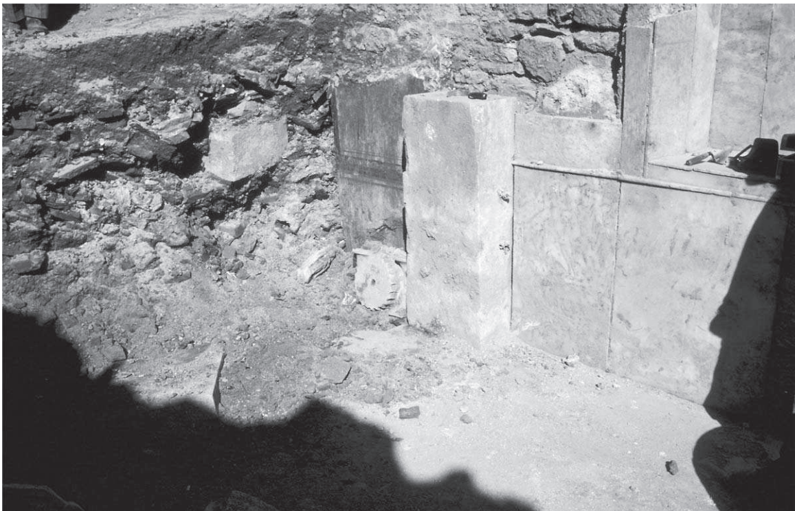
Abb. 60: 38, Freilegung des NO-Bereichs mit dem Fund des Hekateion S 15
