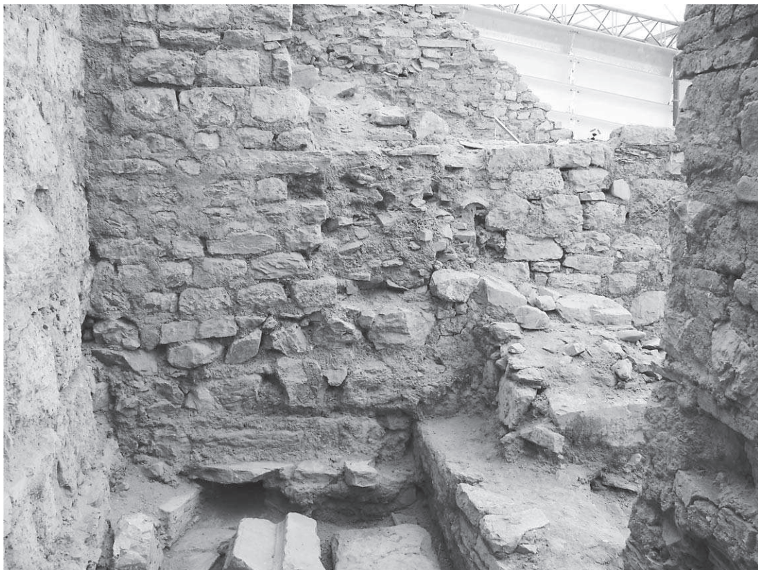
Abb. 29: 33, südlicher Teil der W-Mauer
