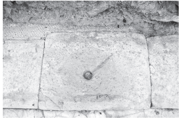
Abb. 2: Peristyl 38b, W-Stylobat, Standfläche der südlichen Säule
