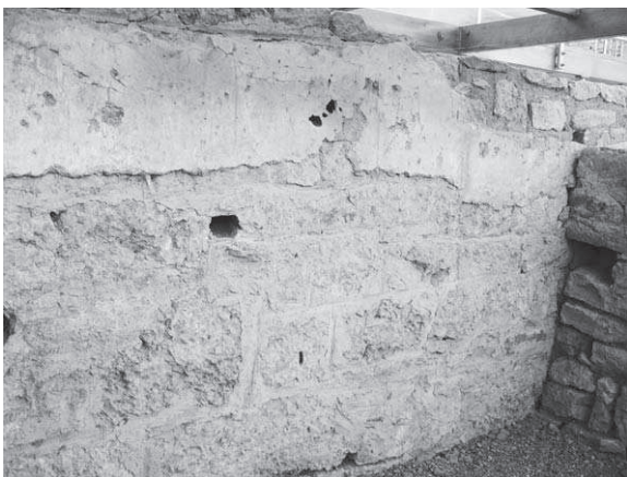
Abb. 80: 38aS, westlicher Teil der S-Mauer
