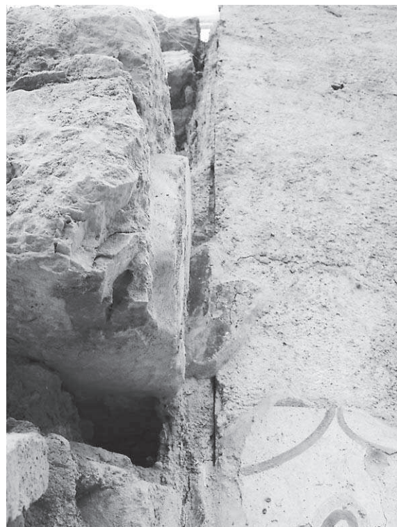
Abb. 78: 38a, Ansatz der jüngeren O-Mauer an die ältere N-Mauer mit Wandmalereischichten
