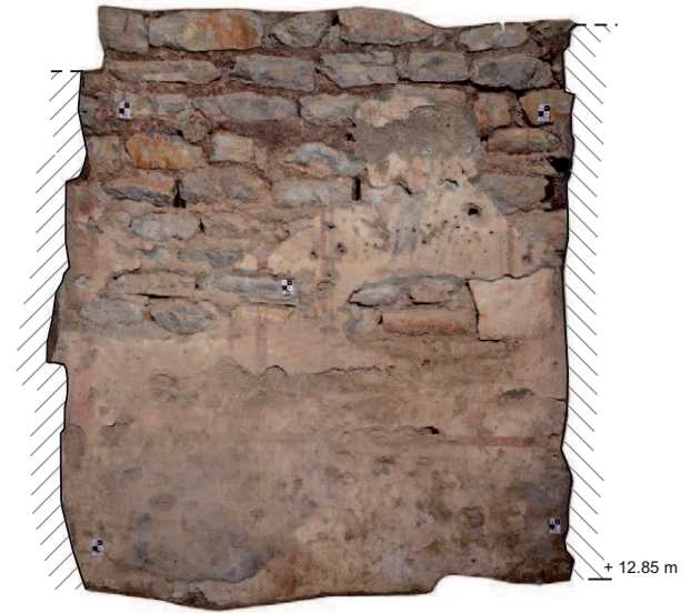
nördl. Raumteil Westmauer
