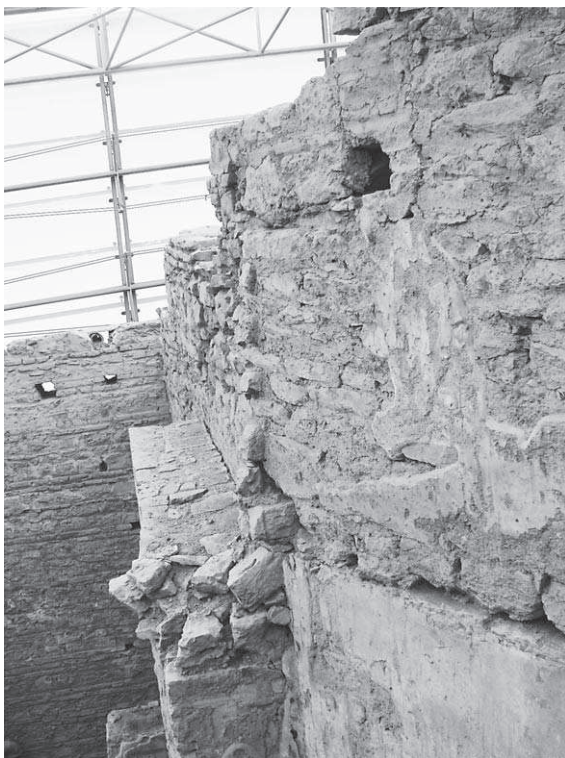
Abb. 165: 38i, O-Mauer mit Ansatz der N-Mauer und Öffnungen für Dielenbretter an der O-Mauer
