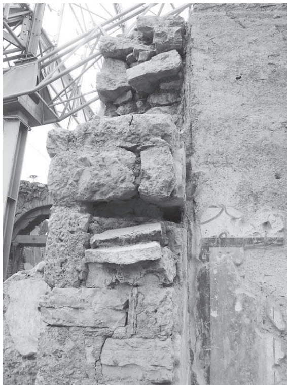
Abb. 77: 38a, Ansatz der jüngeren O-Mauer an die ältere N-Mauer mit Wandmalereischichten
