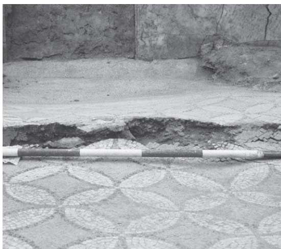
Abb. 91: Raum 38d, Mosaikboden mit Erdbebenriss
