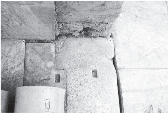
Abb. 9: Raum 38, westliches Ende der Schwelle mit Standfläche des Pfeilers
