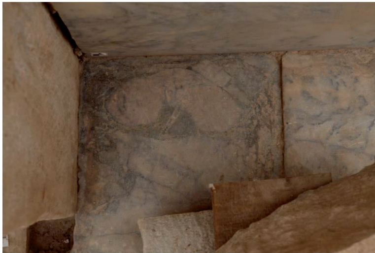
Abb. 6: Raum 38, Bodendetail Africano im Bereich der Schwelle (O) zum Peristyl 38b
