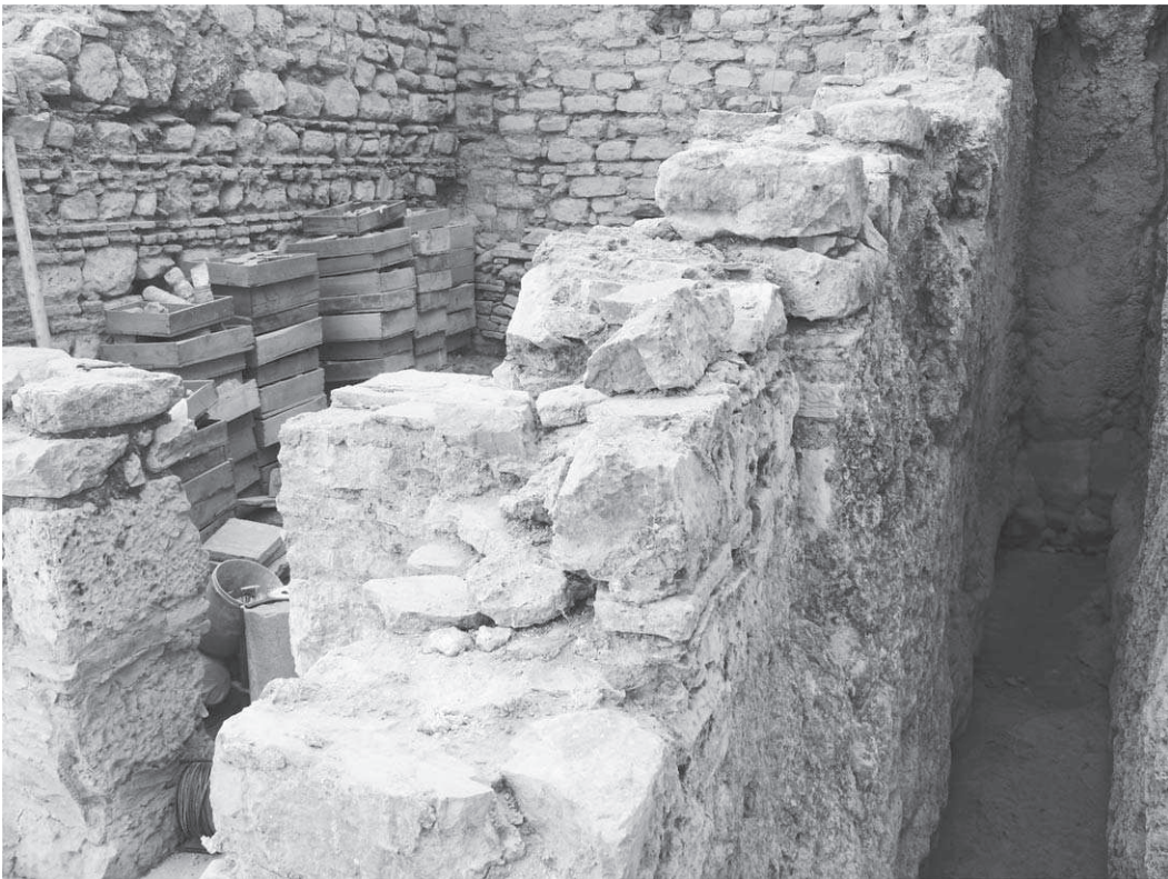
Abb. 44: 35, W-Mauer und Mühlenkanal
