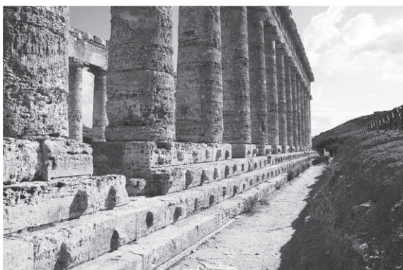
Abb. 16: Segesta, Hebebossen an den Blöcken der Krepis des Tempels
