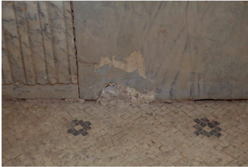
Abb. 9: Raum 38c, abgearbeiteter und verkehrt herum wiederversetzter Pilaster und zugeschmiertes Abflußloch in der W-Wand
