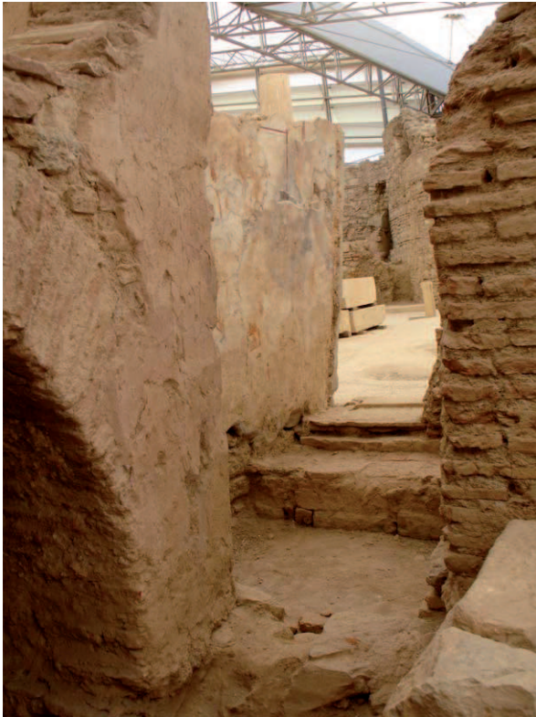
Abb. 22: 38g, Gewölbe, das außen eine rötliche Malschicht aufweist
