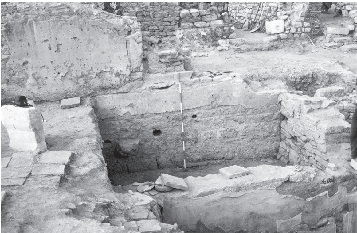
Abb. 2: Raum 32c, westliche Raumhälfte, Ansicht der Südwand mit Konsole und Balkenloch
