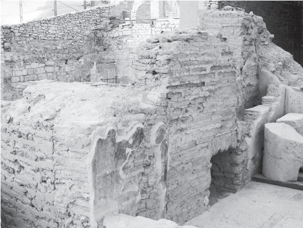
Abb. 1: 32c, O-Mauer mit an die Wandmalerei angeetzter N-Mauer
