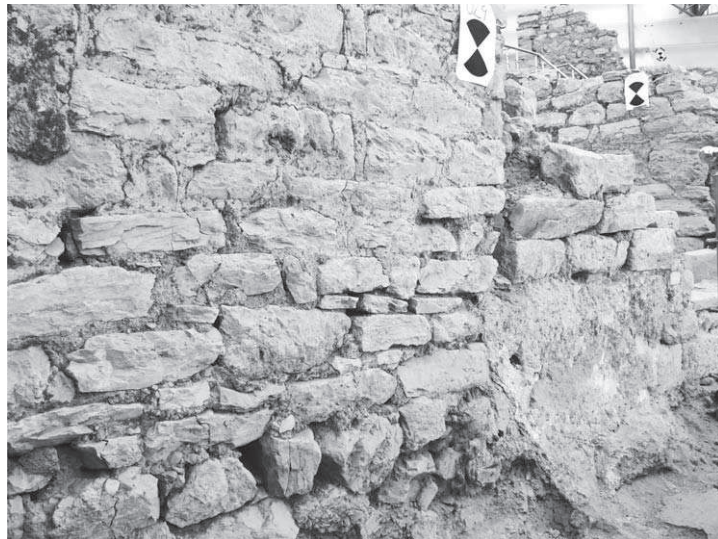
Abb. 53: 37, S-Mauer, Abschnitt 1, mit angesetztem Kalkbecken
