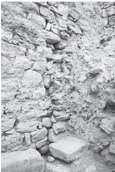
Abb. 9a: 45, O-Mauer, Trennmauer im südlichen Raumteil mit Anschluss zur O-Mauer
