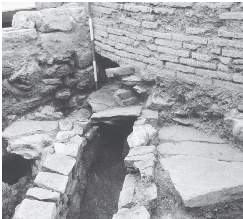
Abb. 31: Raum 34a, Kanal SE 1014 und Plattenboden SE 1017
