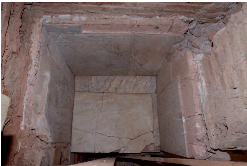
Abb. 11: Raum 38d, Marmorwandverkleidung in der südlichen Nische des östlichen Raumteiles
