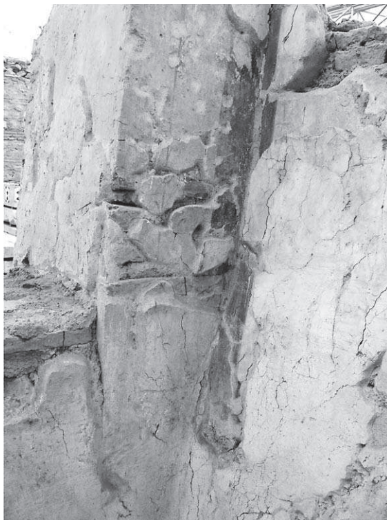
Abb. 15: 32e, NW-Ecke mit Baufuge
