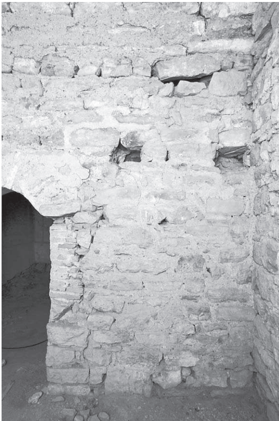
Abb. 52: T IV.UG, südlicher Raum, N-Mauer Ost
