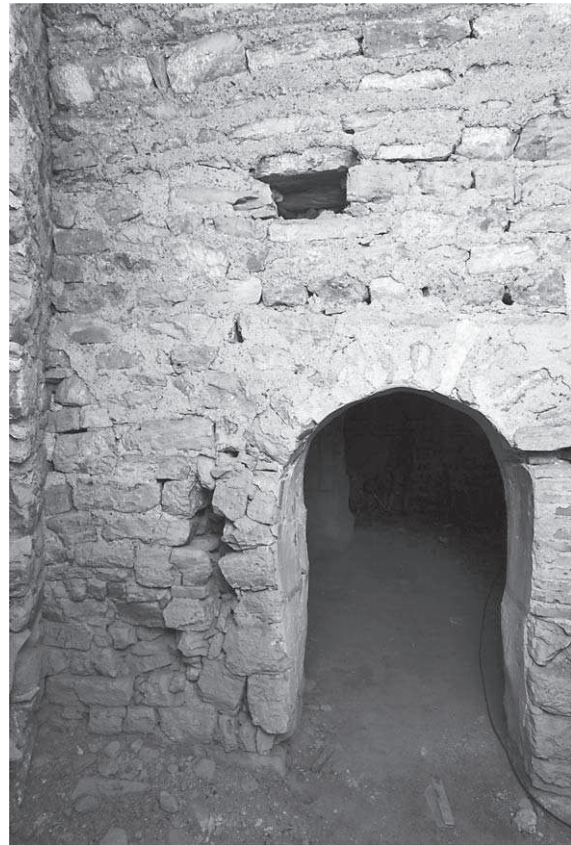
Abb. 53: T IV.UG, südlicher Raum, N-Mauer West
