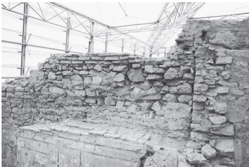
Abb. 5: 45b, O-Mauer, Abschnitt 1, frühbyzantinische Aufmauerung mit Ziegeln
