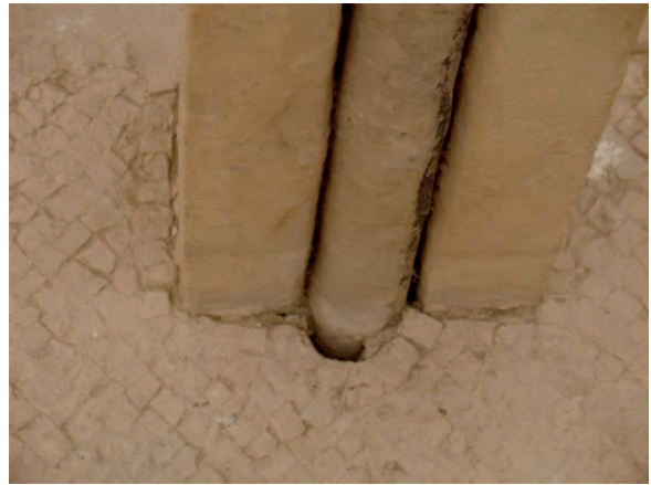
Abb. 4: 38b, N-Umgang, an Pfeiler angesetzter Mosaikboden
