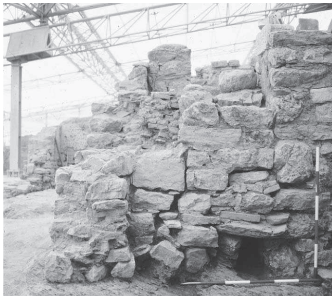
Abb. 22: Kanalöffnung in der W-Mauer von Raum 34
