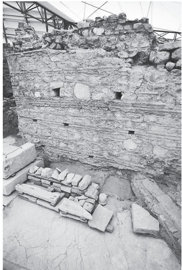
Abb. 99: 38b, Nordwest, spätantik-frühbyzantinische Mauer
