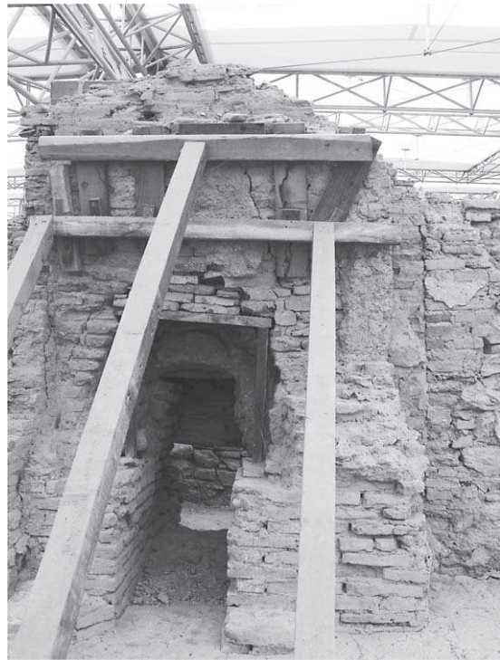
Abb. 158: 38h, Praefurnium in der S-Mauer
