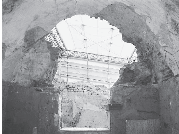
Abb. 121: 38c, Blick auf die W-Mauer mit der Wandnische und auf das Gewölbe
