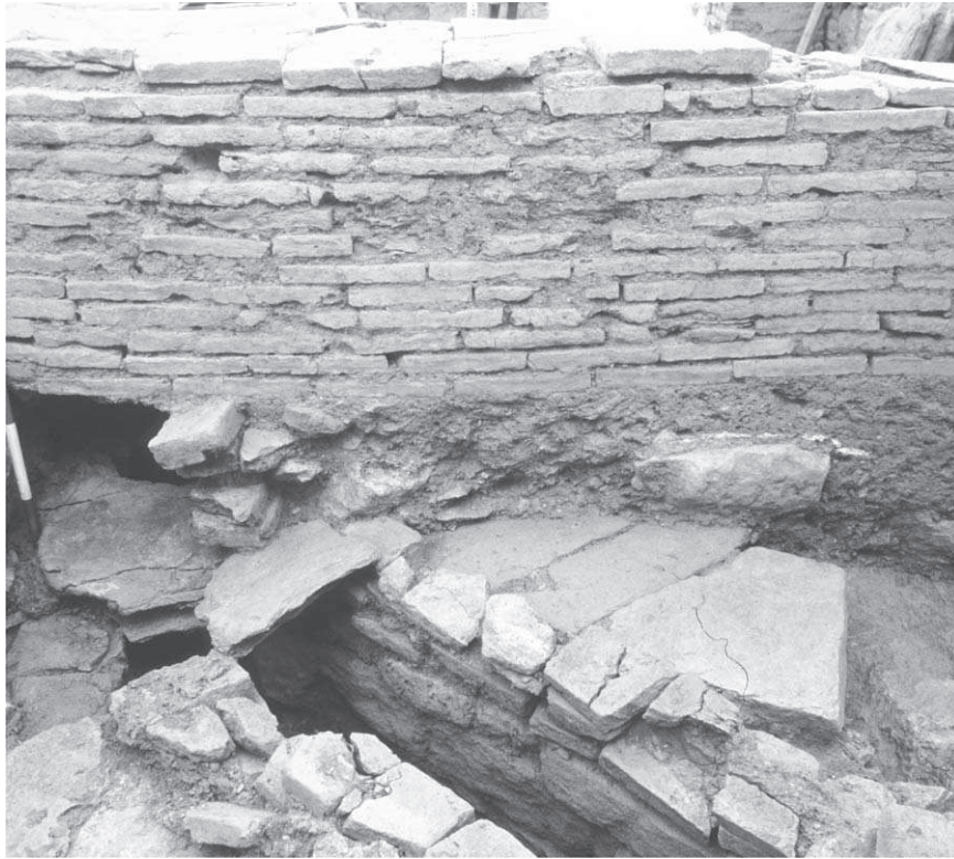
Abb. 43: Raum 34a, Trennmauer zum nördlich angrenzenden Raum 34
