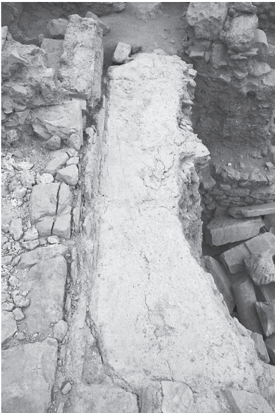
Abb. 137: 38e, Rest des Estrichs
