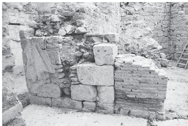
Abb. 44: 45c, Teil der S-Mauer zwischen den Türen nach 45 und 45b
