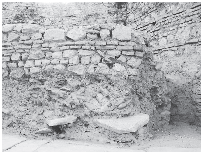
Abb. 103: 38b, W-Umgang, auf Zerstörungsschutt errichtete spätantike Mauer, Detail
