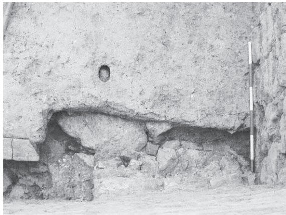
Abb. 45: Raum 34a, Fundamentgrube SE 1008
