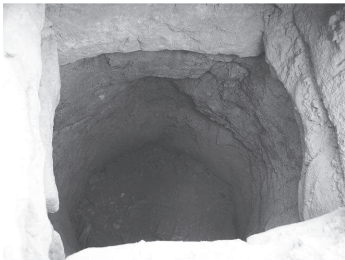
Abb. 40: 34, Blick in den Brunnenschacht
