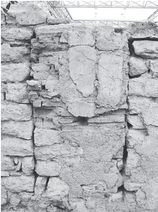
Abb. 157: 38h, S-Mauer mit Türabmauerung und den Abdrücken einer Tubulatur im Putz
