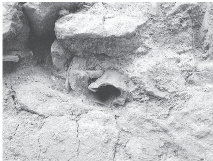
Abb. 25: Raum 34a, Bleirohr in der Ostmauer
