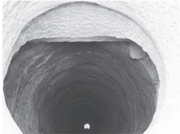
Abb. 64: 38, Blick in den Brunnenschacht
