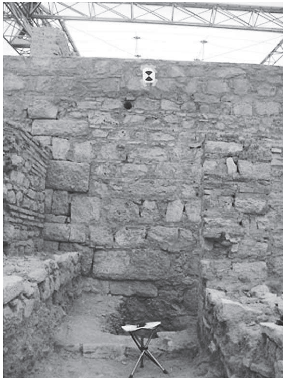
Abb. 27: 33, östlicher Teil der S-Mauer
