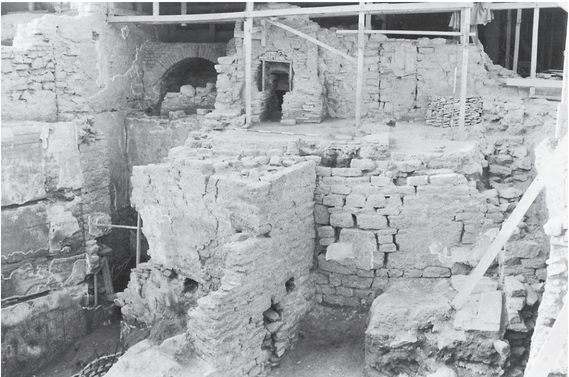
Abb. 147: 38g und 38h, Ansicht von Norden
