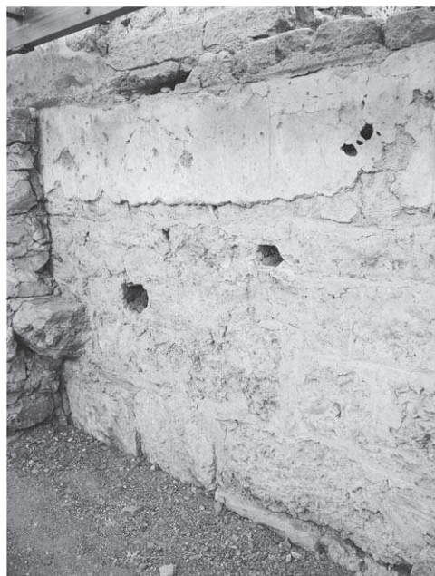
Abb. 81: 38aS, östlicher Teil der S-Mauer
