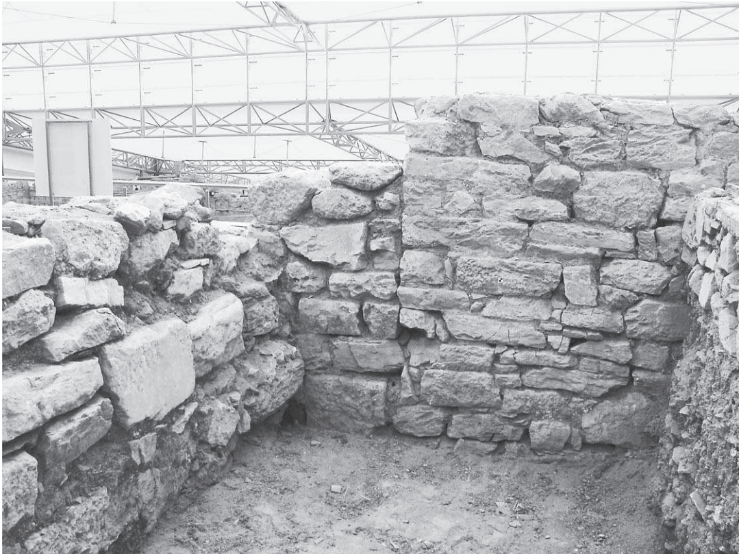
Abb. 22: 33, östlicher Teil der N-Mauer
