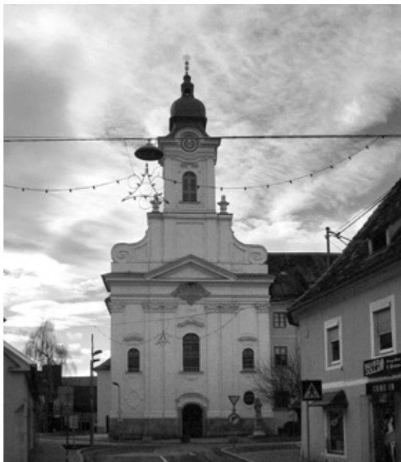
Abb. 90: Gleisdorf; Filialkirche Maria Reinigung (errichtet zwischen 1743 und 1747 durch Matthias Gerl als Klosterkirche für den von Kardinal Sigismund Graf von Kollonitsch eingesetzten Piaristenorden) neben dem Herrschaftspital, seit 1827 Filialkirche der Pfarre (Foto: Alfred Stefan Weiß, 2012).
