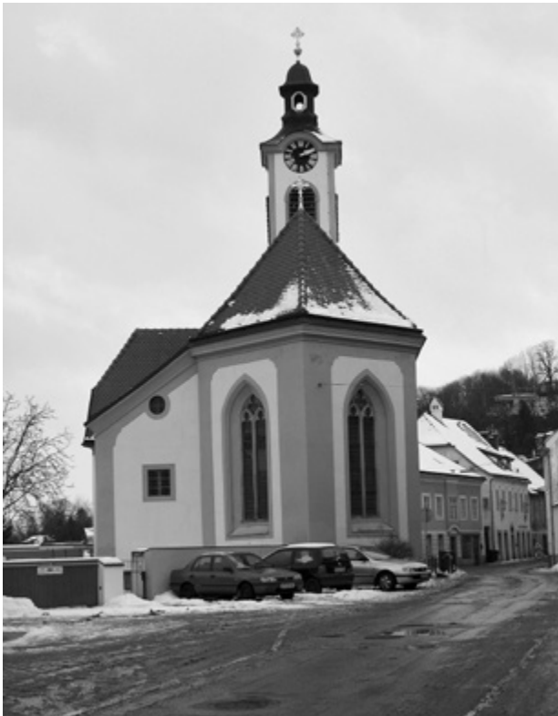
Abb. 122: Steyr; Bruderhaus (Sierninger Straße 55), 1380 erstmals genannt, 1511 Stiftung einer Kapelle mit Friedhof (1569 aufgelassen) (Foto: Martin Scheutz 2012).
