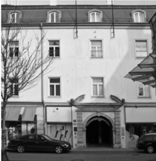
Abb. 61: Wels; Renaissance-Portal um 1600 (Pfarrgasse 15), Ort des zwischen 1626 und 1787 angesiedelten Hofspitals (Foto: Martin Scheutz, 2012).
