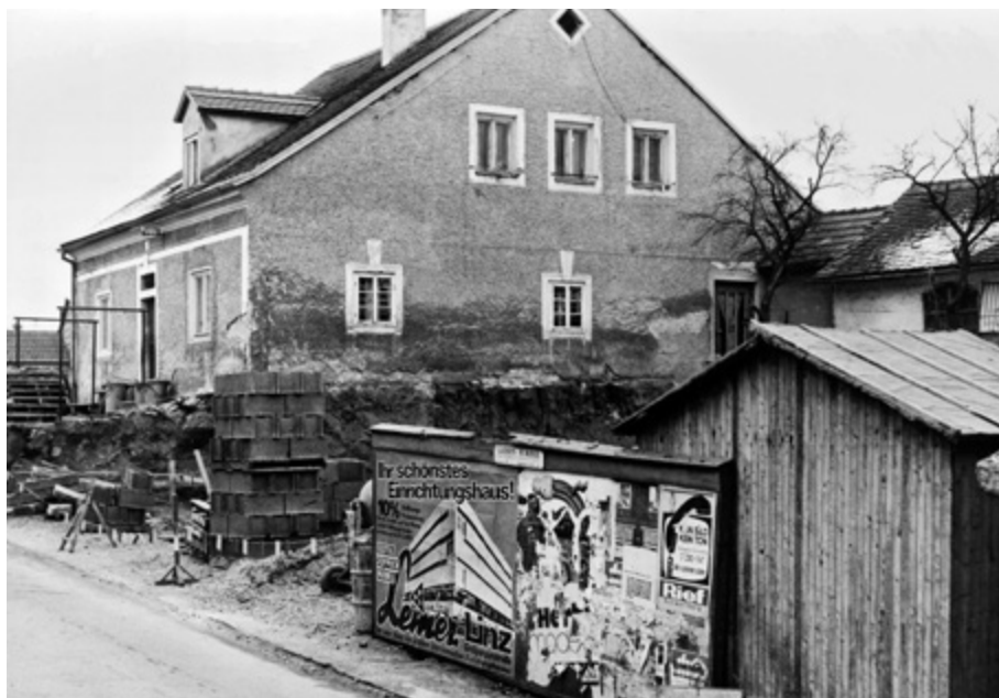
Abb. 106: Pregarten; altes Bürgerspital (Pregarten Nr. 77; EZ 71, KG Pregarten, später Bahnhofstraße 35) kurz vor dem Abriss 1975 (Foto: Leopold Höllwirth, Pregarten).
