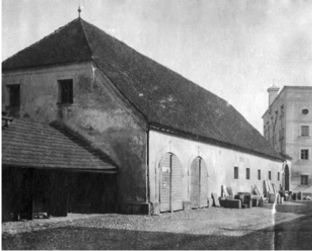
Abb. 75: Mühldorf am Inn; Bürgerspital und Spitalstadel (Spitalgasse 9; 1719) in der zweiten Hälfte des 19. Jahrhunderts (Quelle: StA Mühldorf, historisches Foto).
