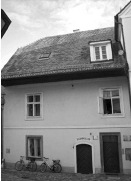
Abb. 62: Graz; das nördlich der Stadtpfarrkirche zum Heiligen Blut gelegene Hofspital (Mesnergasse 4) aus den 1560er Jahren (Aufhebung 1787) in Frontalansicht (Umbauten aus dem zweiten Viertel des 19. Jahrhunderts, Schopfwalmdach, Volutenprellstein aus dem 17. Jahrhundert) (Foto: Alfred Stefan Weiß, 2012).
