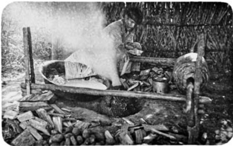
Figure 3.2 Tapper smoking rubber with palm nuts. Source: Departamento de Patrimônio Histórico e Cultural do Estado do Acre.
