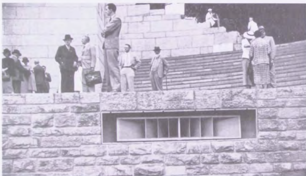
Abb. 4-21: Lautsprecheröffnung bei der Dietrich-Eckart-Bühne.
