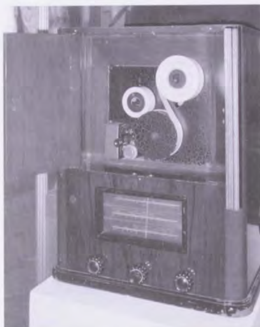
Abb. 2-22: Tonbandgerät mit „Photophonoband“ aus dem Polytechnischen Museum Moskau, das „ГОВОРЯЩАЯ БУМАГА“.
