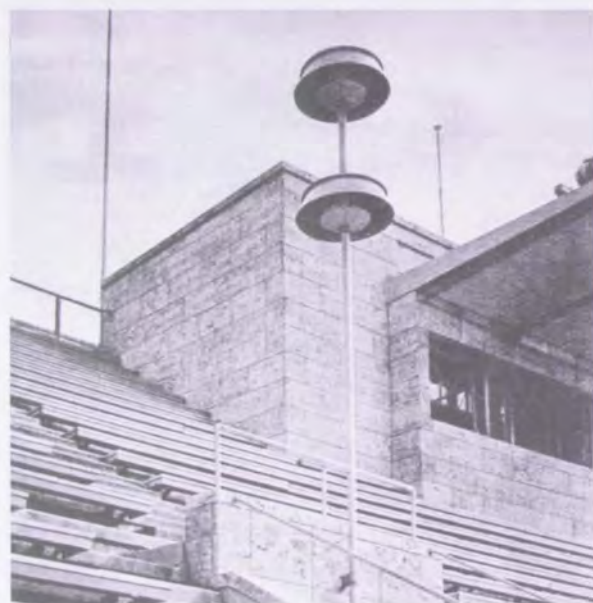
Abb. 4-23: Das Prinzip der LÖSCHSTRAHLER.
