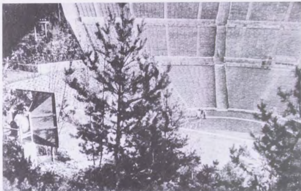
Abb. 4-22: Im Wald versteckte Lautsprecher zur Beschallung des Zuschauerraumes der Dietrich-Eckart-Bühne.
