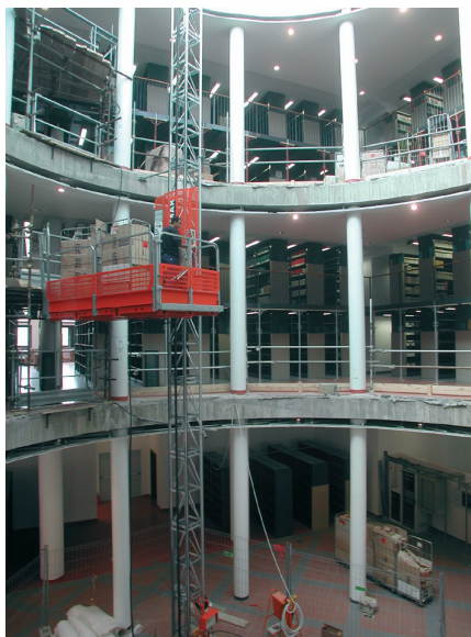
Il trasloco: montacarichi.
