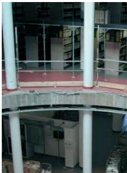
Il trasloco: veduta del piano terra e del primo piano.
