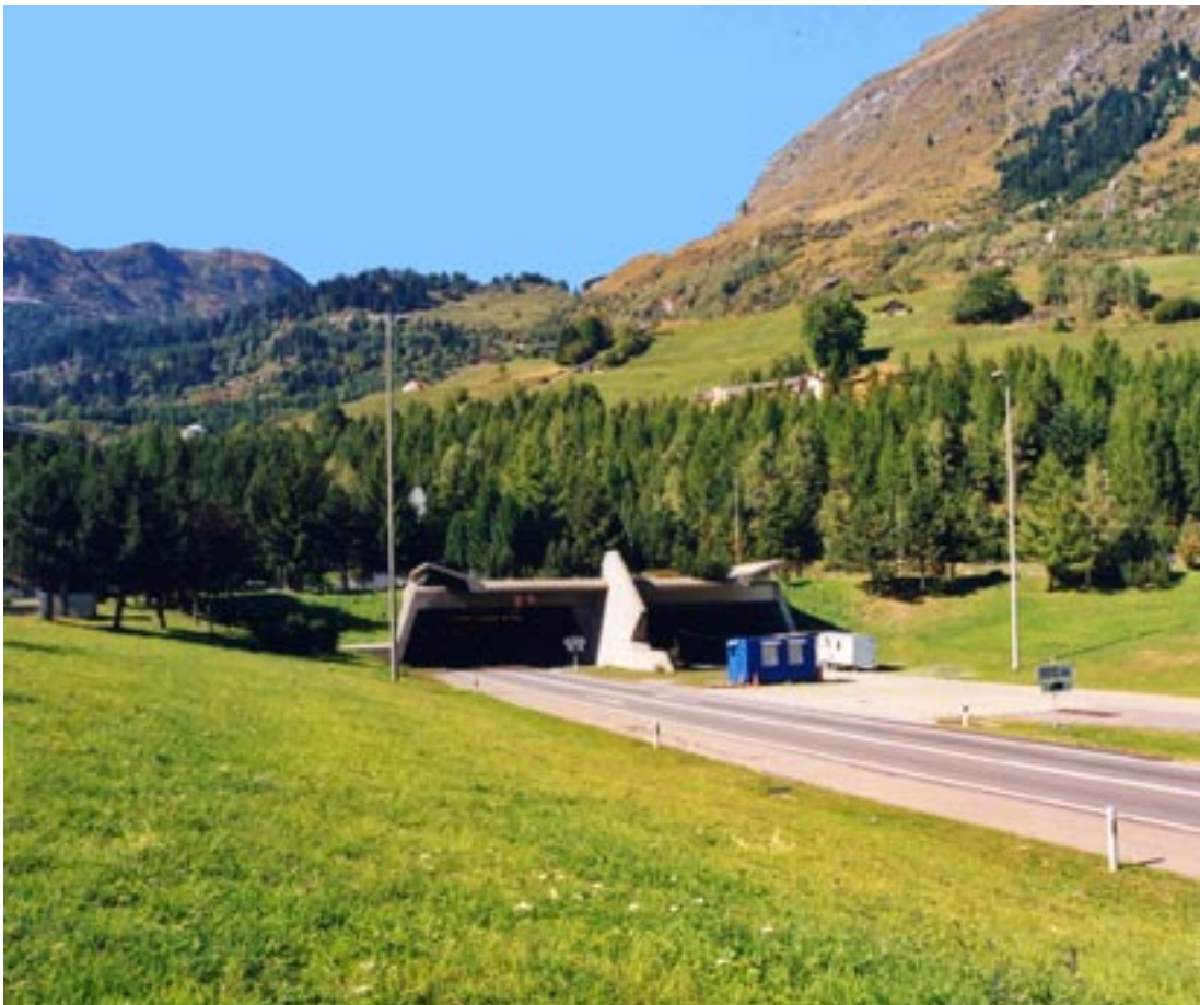
Figura 1. Autostrada N2. Il portale della galleria autostradale del San Gottardo.
