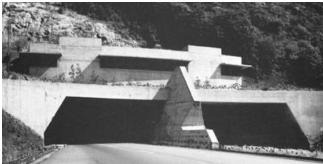
Figura 11. Portale nord della galleria Melide.
