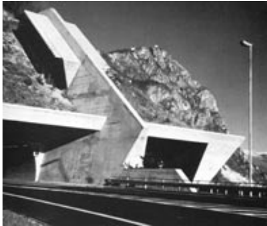
Figura 4. Portale sud della galleria Melide-Grancia.
