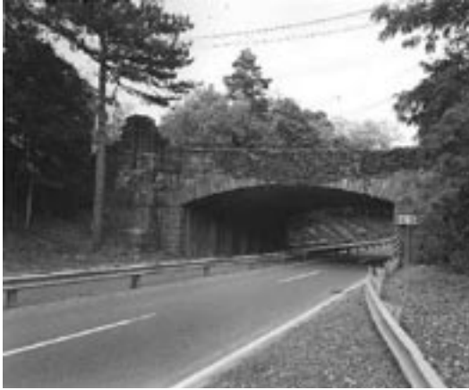
Figura 20. Pondfield Road bridge (ottobre 2001).
