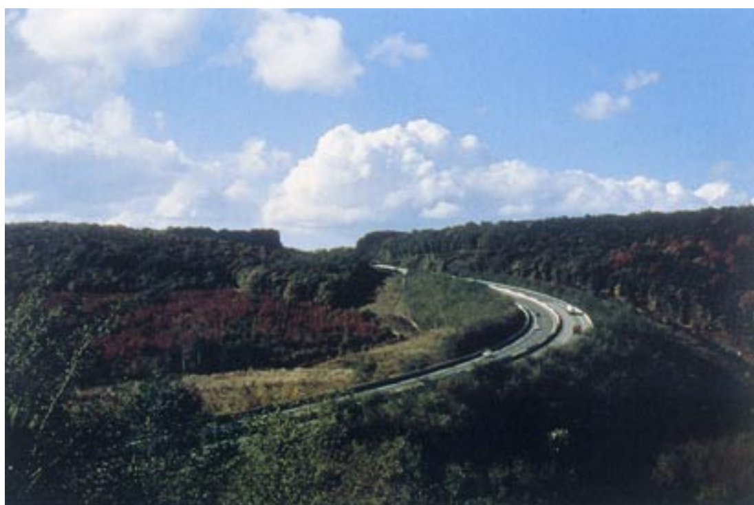
Figura 62. Immagine durante i lavori autostradali sull'A89.
