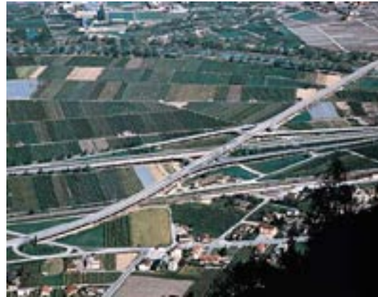
Figura 2. (sopra) La maglia regolare del paesaggio agricolo di pianura e il segno lineare dell'infrastruttura in prossimità della città di Sion.
