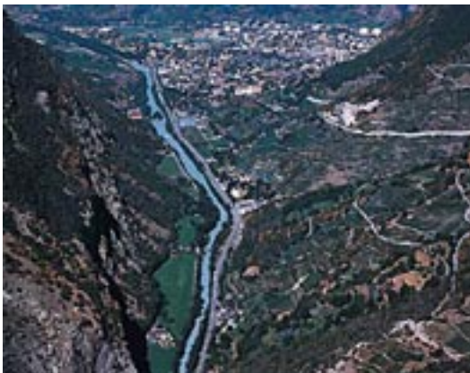
Figure 11 - 15. Vedute aeree dell'alta valle del Rodano e del tracciato autostradale.
