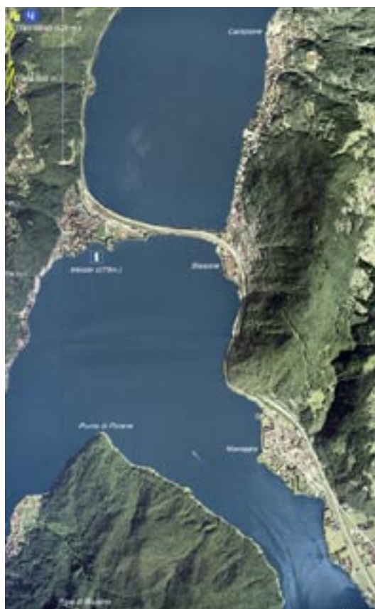
Figura 12. Foto aerea del lago di Lugano in cui si nota il tracciato autostradale che funziona da diga tra il centro urbano di Melide e Bissone.
