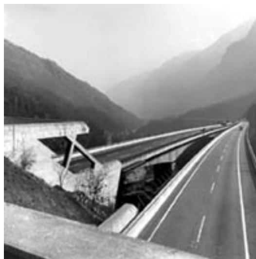
Figura 2. Tratto autostradale della N2 – viadotto del Monte.
