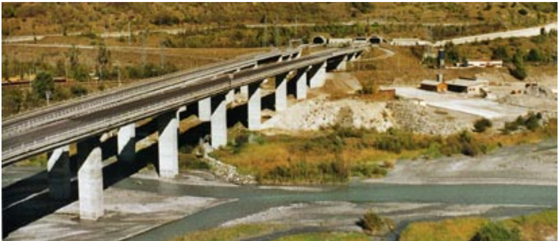
Figura 125. Autostrada della Val di Susa.
