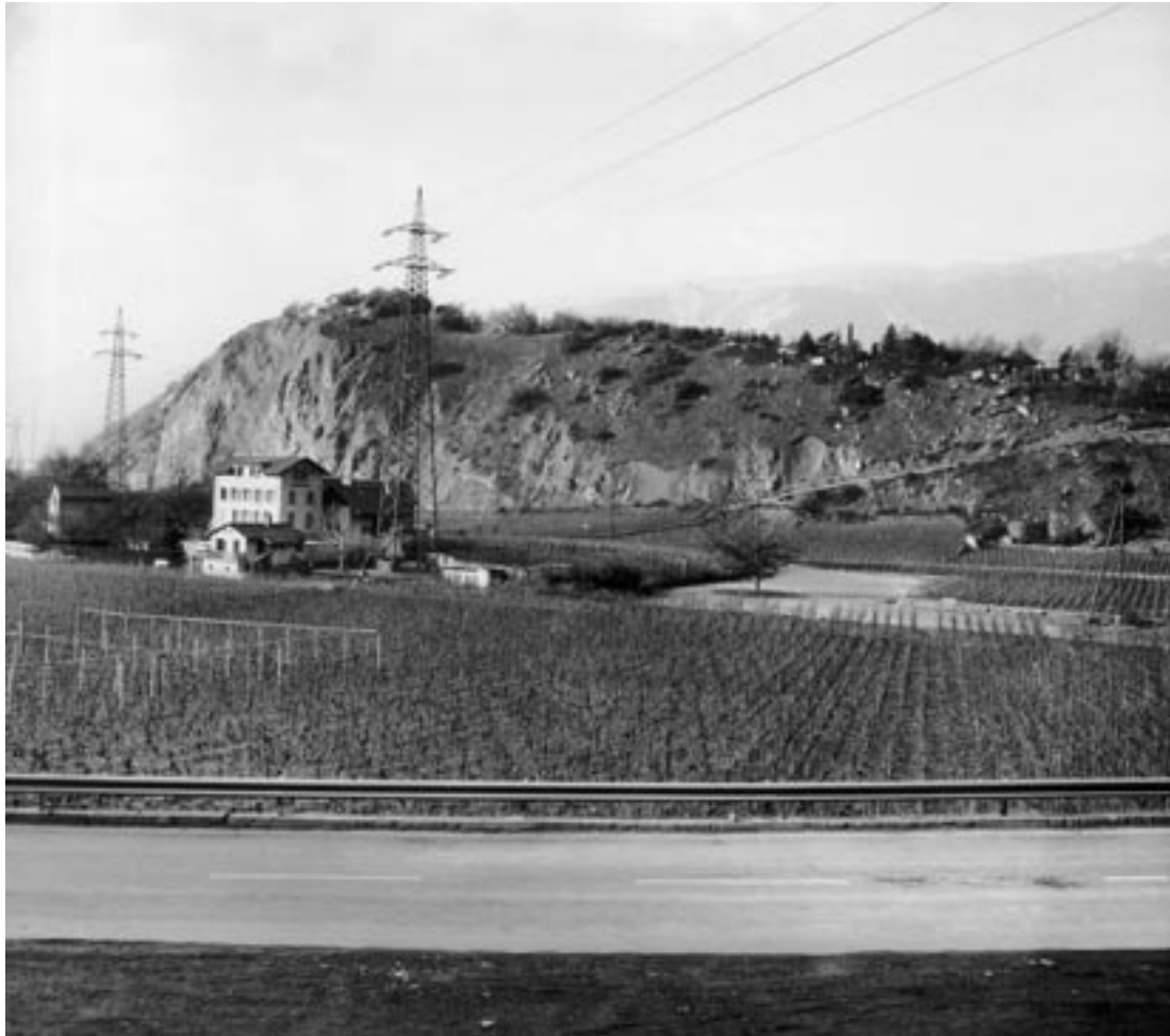
Figura 24. Veduta generale della periferia di Sierre prima del passaggio dell'autostrada e della realizzazione del parco (dicembre 1988).
