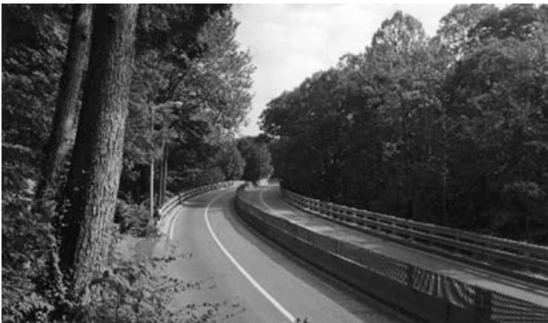
Figura 22. Craneroad Bridge. Si noti il disegno curvilineo del ponte (ottobre 2001).
