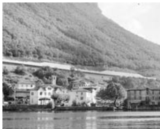
Figura 3. A Capolago il piano stradale viene eseguito su di uno sbalzo che crea una lunga linea di ombra che riduce visivamente l'incombenza del muro di sostegno.
