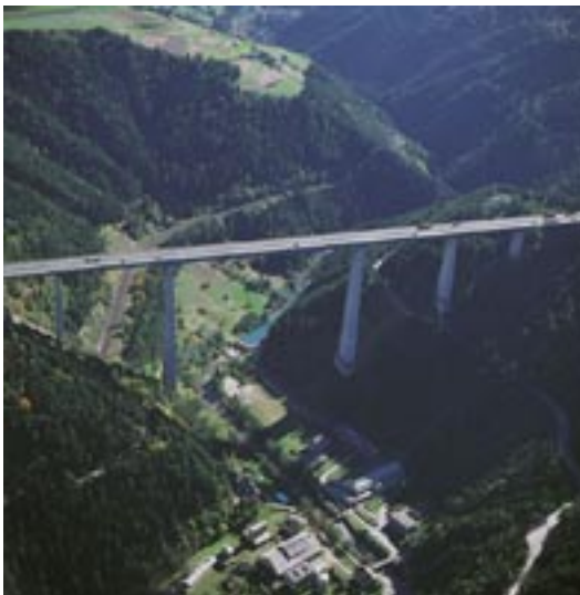
Figure 9-10. Vedute aeree dell'Europabrücke.
