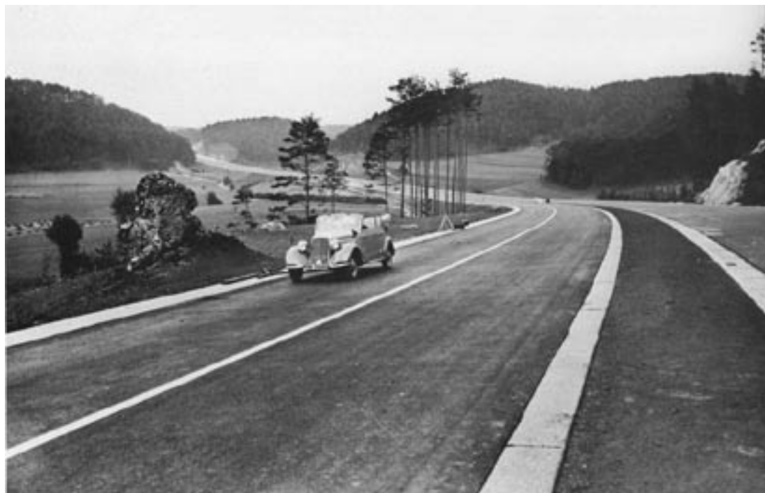
Figura 36. Sistemazione paesaggistica, comprensiva della fascia centrale libera e prato, lungo un autobahn tedesca.
