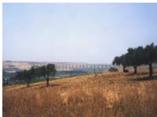
Figura 7. Viadotto della strada statale n. 115 nel paesaggio agricolo in prossimità della città di Sciacca.
