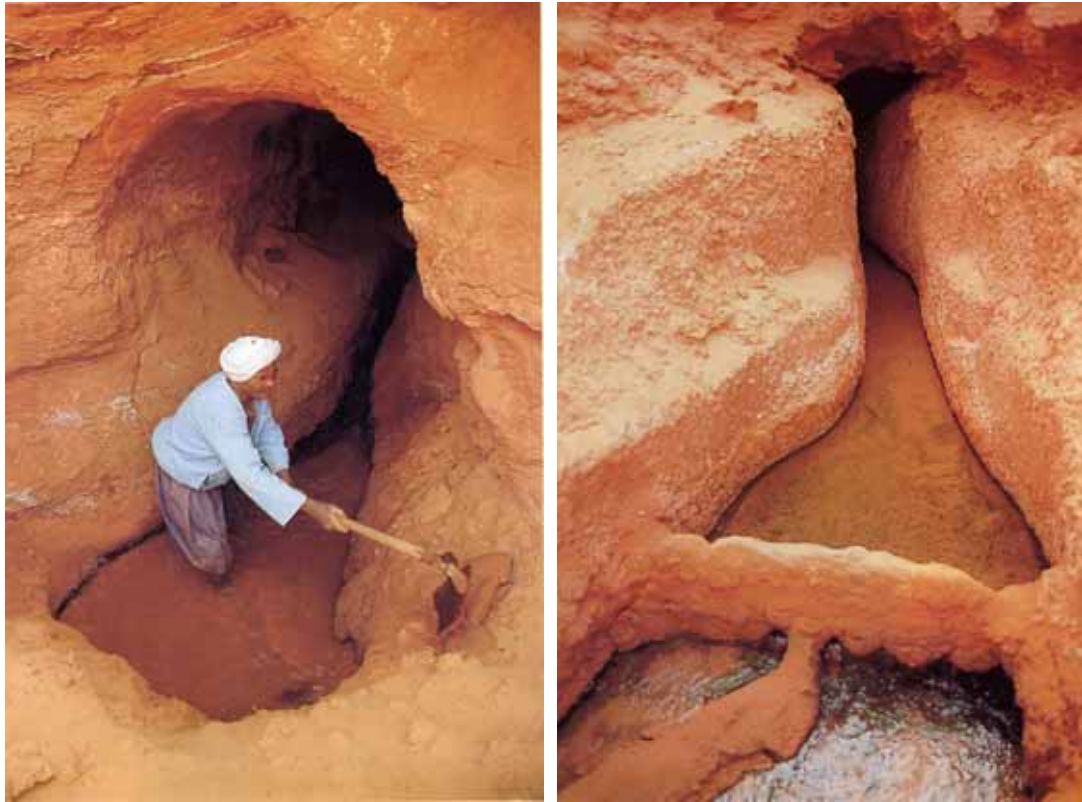
Figura 1. Dispositivi idraulici sotterranei chiamati foggara gestiscono oculatamente le acque; ogni minima occasione di umidità viene utilizzata amplificandone gli effetti. Fonte: PIETRO LAUREANO, La Piramide Rovesciata, il modello dell'oasi per il pianeta Terra , Bollati Boringhieri, Torino 1995, pag. 45.
