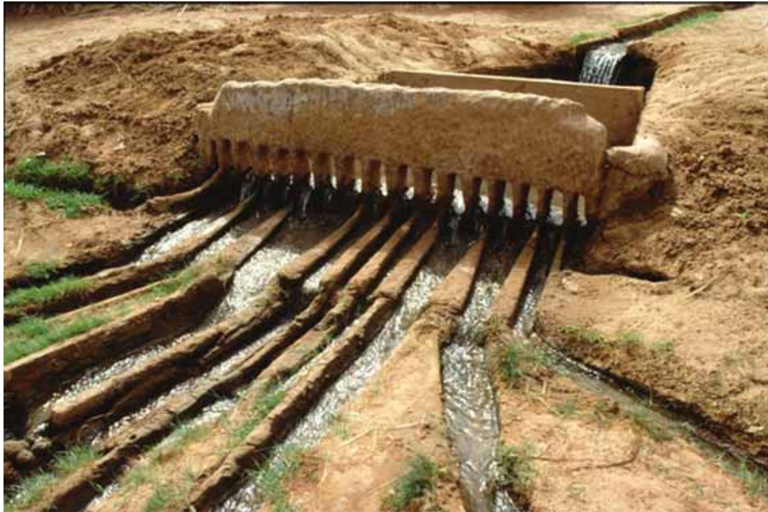
Figura 2. La kesria , particolare dispositivo in pietra a forma di pettine che, attraverso la dimensione degli spazi tra i “denti”, permette la ripartizione dell’acqua nelle canalizzazioni secondo le quote di proprietà.
