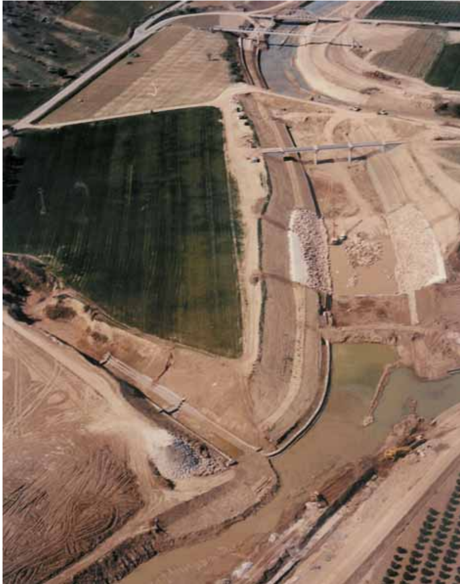
Figura 4. Fiume Basento: meandro in corso di rettificazione, nel 1990.
