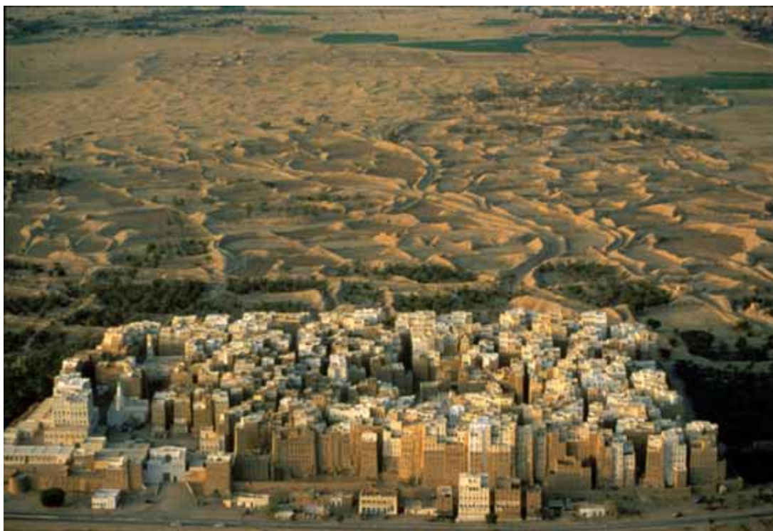
Figura 3. Shibam, nello Yemen, è interamente costruita con la terra cruda. È fatta di altissime torri di mattoni non cotti, ma solo lasciati seccare al sole.
