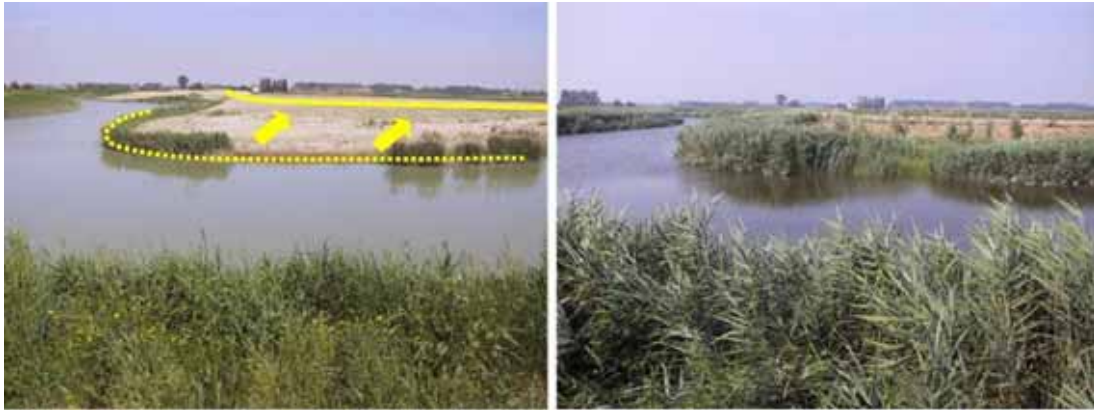
Figura 4. Golena di meandro realizzata sul fiume Zero: maggio 2003 (sinistra). Le frecce indicano l'arretramento del vecchio argine (linea tratteggiata) alla nuova posizione (linea continua). A destra, lo stato della vegetazione nel luglio 2004.
