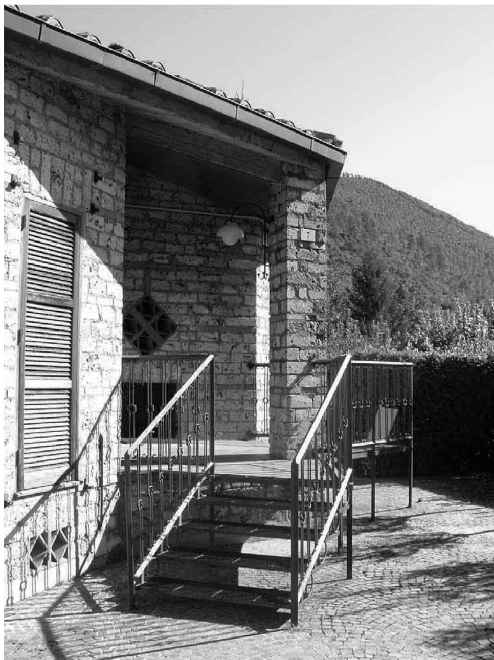
Figura 2.9 Casa Lina. La scaletta di accesso in ferro e pietra.
