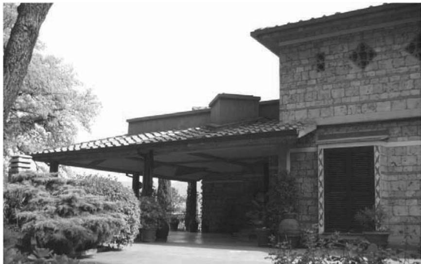
Figura 3.9. Casa De Bonis (I), Terni. Vista dell'ampio portico d'accesso, ottenuto mediante lo svuotamento volumetrico di uno dei campi a matrice quadrata.
