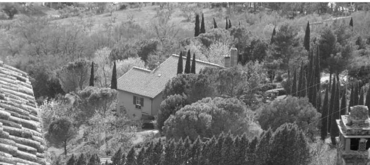
Figura 4.5. Casa Lana. Il tetto a coppi e tegole che racchiude il cuore di casa Lana visto dal paese di Cesi.
