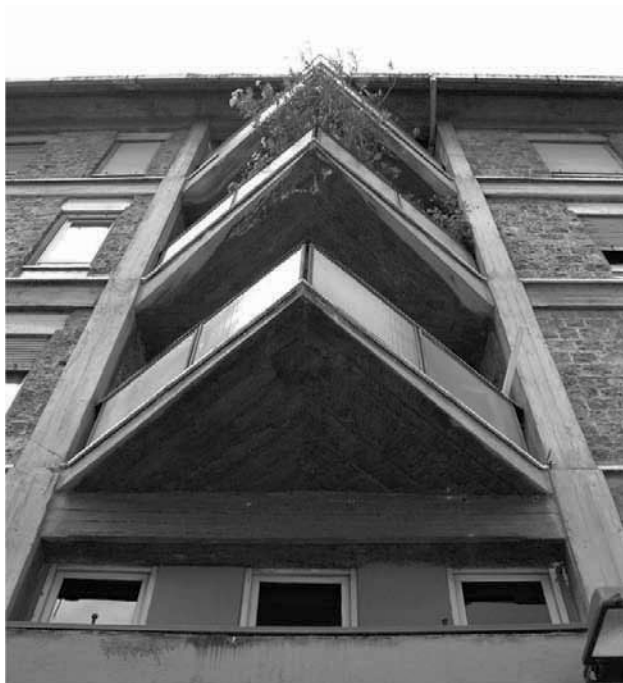
Figura 1.14. Casa Chitarrini, Largo Villa Glori, Terni. Dettaglio del terrazzino romboidale a sbalzo.
