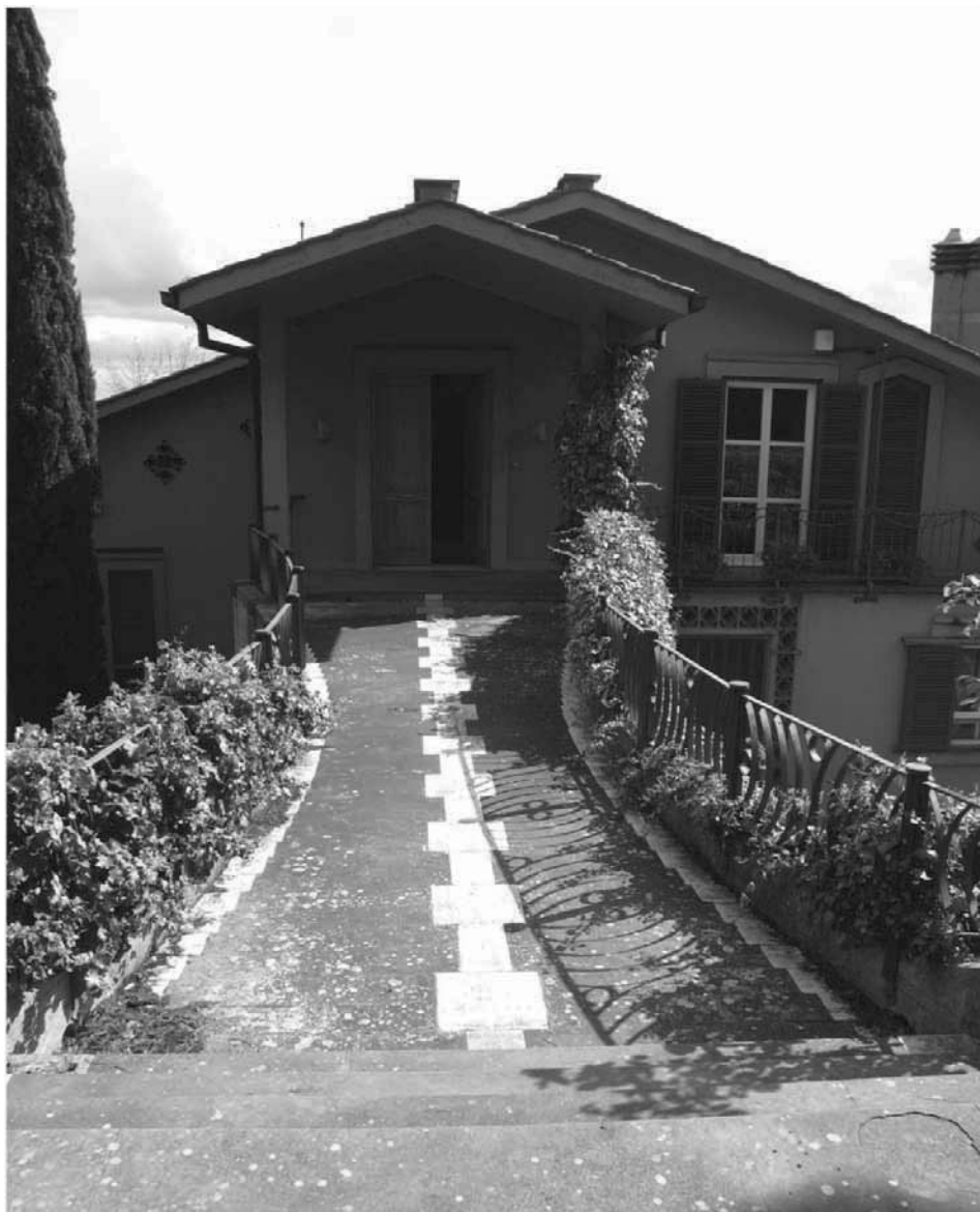
Figura 4.2. Casa Lana. La passerella di accesso che invita l'ospite ad entrare.
