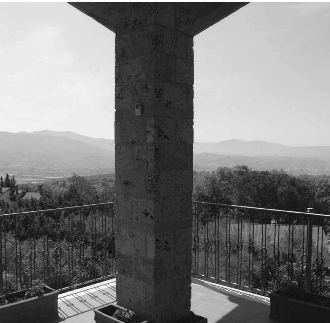
Figura 3.12. Casa Lupattelli, Vocabolo Piedimonte, Terni. Il loggiato verso il paesaggio del fiume Nera.
