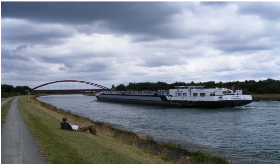
Abb. 1: Der Elbe-Seitenkanal auf der Höhe von Gifhorn. Foto: U. Anders (2009).
