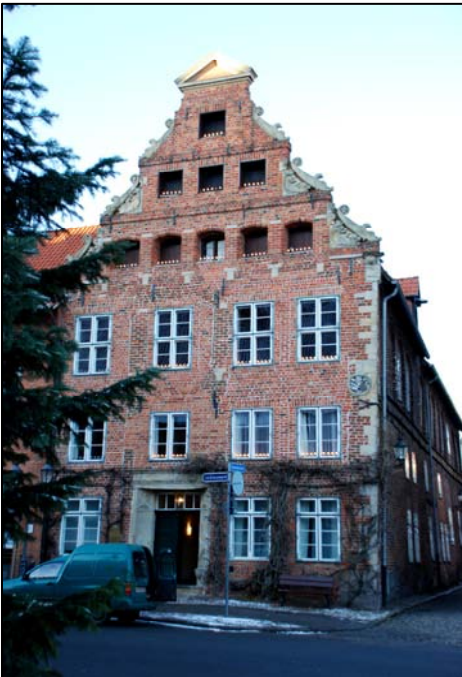
Abb. 5 An der Nordseite des Marktplatzes von Lüneburg befindet sich das „Heinrich-Heine-Haus“, in dem die Eltern des Dichters ab 1822 für mehrere Jahre gelebt haben.
