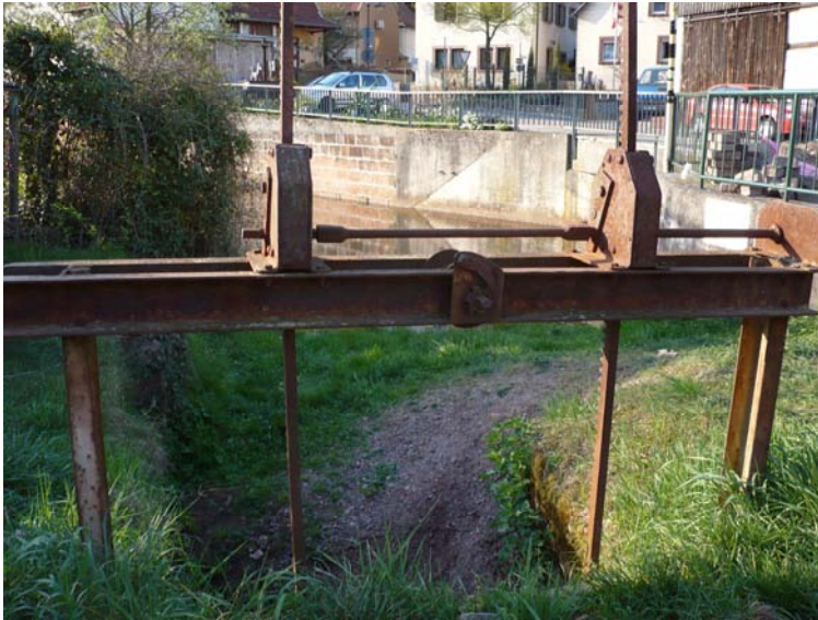
Abb. 3: Die heute verlandete Einlassschleuse des Kanals in Albersweiler. Foto: A. Bader.
