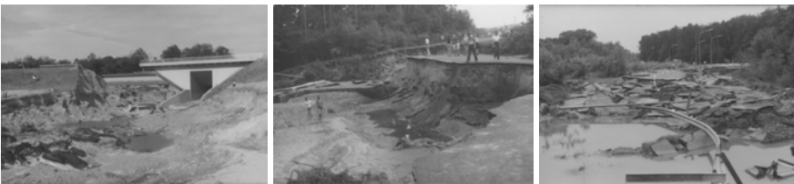
Abb. 2: In der Folge des Kanalbruchs am Elbe-Seitenkanal strömten Wassermassen in die Landschaft. Es wurden große Mengen an Material weggespült und Straßen und Bauwerke zerstört. Fotos: Archiv der Gemeinde Adendorf (1976).
