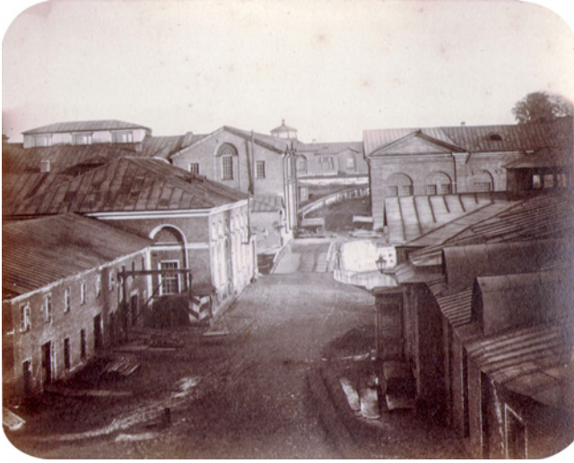
Abb. 12 o. A.: Magazin, Schlosserei, große Maschinen- und Walzstahlwerkstatt (Magazin, slesarnaja, bol'saja mašinnaja, železoprokatnaja), in: o. A.: Ansichten des Ižorsker Betriebs (kleines Album) (Vidy Ižorskago zavoda (malen'kij al'bom)), o. O. o. J., S. 6. MIZ
