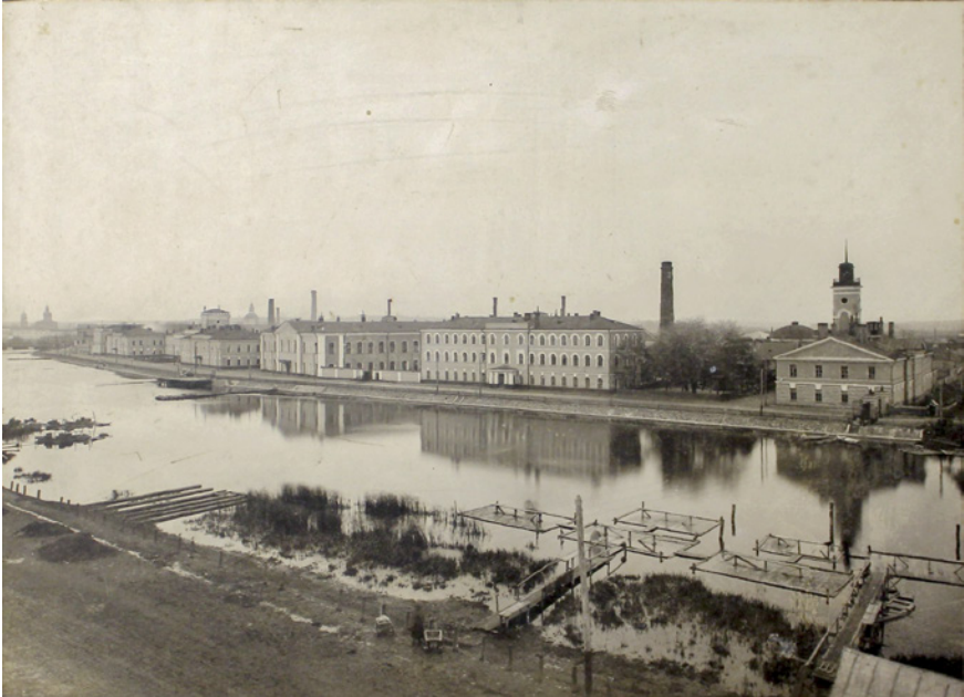
Abb. 43 Semën Osipovič Kanter: Tulaer Waffenfabrik. Außenansicht des Betriebs (Tul'skij oružejnyj zavod. Naružnyj vid zavoda), Tula um 1900. TGMO KP-2-21679
