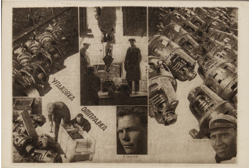
Abb. 91 Mecco-tinto Sokrajšefsoveta (Hrsg.): Der Rotbanner Elektromotorenbetrieb namens Lapse in Moskau erfüllte den Fünfjahresplan in zweieinhalb Jahren. 1. Fertige Produktion – Motoren, Verpackung und Verladung (Krasnoznamennyj élektromotorostroitel'nyj zavod im. Lapse v Moskve vypolnil pjatiletku v dva s polovinoj goda. 1. Gotovaja produkcija – motory, Upakovka i pogruzka), No 10, Moskva inventarisiert 1931. RGB Izo 8442–38
