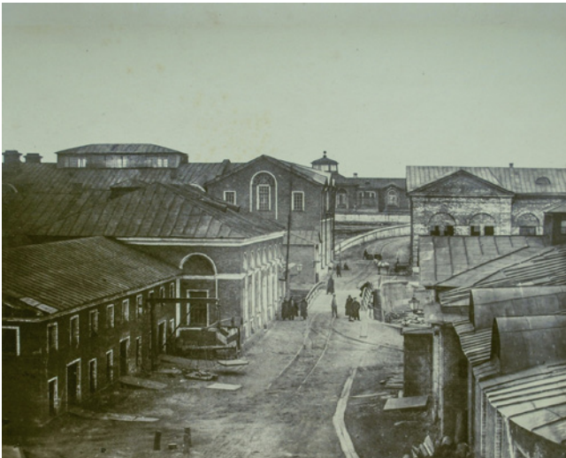
Abb. 13 o. A.: Magazin, Schlosserei, große Maschinen- und Walzstahlwerkstatt (Magazin, slesarnaja, bol'saja mašinnaja, magaziny železoprokatnaja), in: o. A.: Ansichten des Ižorsker Betriebs (großes Album) (Vidy Ižorskago zavoda (bol'soj al'bom)), o. O. 1866, S. 6. MIZ
