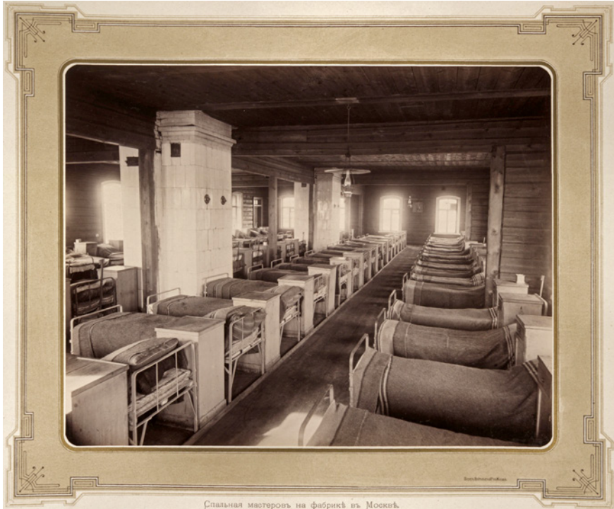
Abb. 34 Levickij: Schlafsaal der Meister in der Fabrik in Moskau (Spal'naja masterov na fabrike v Moskve), in: o. A.: Ansichten der Fabrik und Geschäfte der Gesellschaft A. I. Abrikosov und Söhne im Jahr 1888. Die Fabrik ist während der Produktion donnerstags von 2 bis 4 Uhr für die Öffentlichkeit geöffnet, Aufsicht habender Direktor V. A. Abrikosov (Vidy fabrik i magazinov tovariščestva A. I. Abrikosova synovej, v 1888g. Fabrika otkryta dlja publiky vo vremja proizvodstva po četvergam, ot 2 do 4 časov, Direktor Rasporjaditel' V. A. Abrikosov), Moskva 1888, S. 24. RGB Inv MK XII-1277
