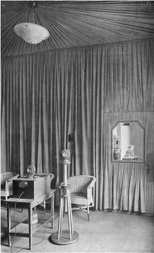
4.34 Das erste Radiostudio in Zürich war nach englischem Vorbild mit absorbierenden Vorhängen und Teppich ausgekleidet, bevor Franz Max Osswald das Problem der zu harten und zu kurzen Klänge durch teilweises Entfernen der Stoffe zu lösen versuchte. Abbildung aus der Zeitschrift *Radio-Programm* von 1926.
