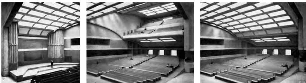
4.17 Osswalds Modell und seine Zeichnungen für einen Saal mit variablem Volumen, der durch Abschluss der Galerie von 8750 auf 6100 Kubikmeter verkleinert werden konnte: eine Massnahme, die er andernorts bereits an kleineren Sälen empfohlen und getestet hatte. Abbildung aus Osswalds hierzu im November 1930 in der *SBZ* publiziertem Beitrag.
