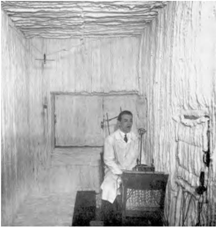
5.03 Ein Akustiker im Laborkittel bei Sprachaufnahmen in einem schallgedämpften Laboratorium, Ende der 1930er Jahre. Aufnahme aus Erwin Meyers *Electro-Acoustics* von 1939.
