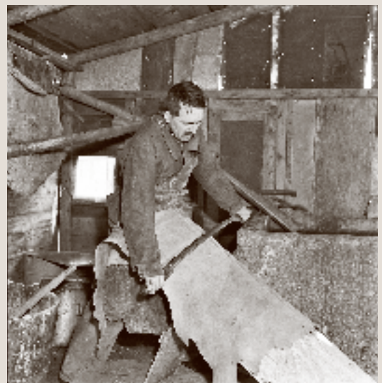
Abbildung 6 (unten) Dass Schuhmacher Häute eigenhändig mit dem Scherdeggen bearbeiteten, hatte Seltenheitswert. Die Fotografie entstammt einer didaktischen Bildfolge, die den Werdegang des Schuhs um 1950 dokumentiert. Die anspruchsvolle Lederherstellung besorgten üblicherweise Gerbereien.
