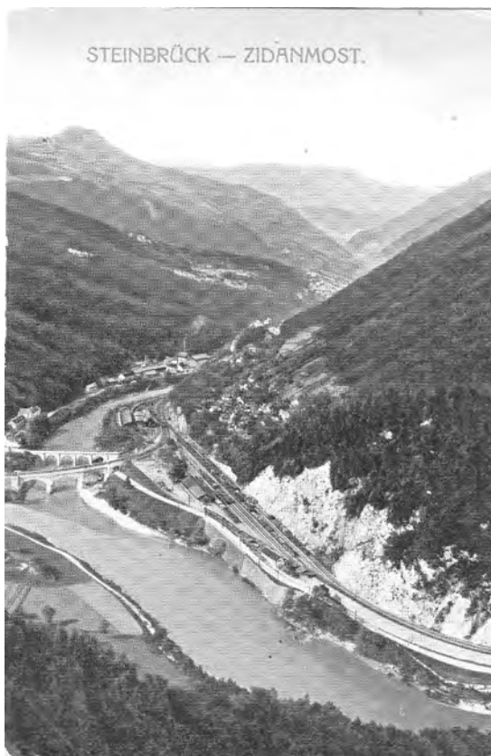
Abb. 1: STEINBRÜCK – ZIDANMOST, Verlag M. Petermann, Zidani Most gelaufen 1909
