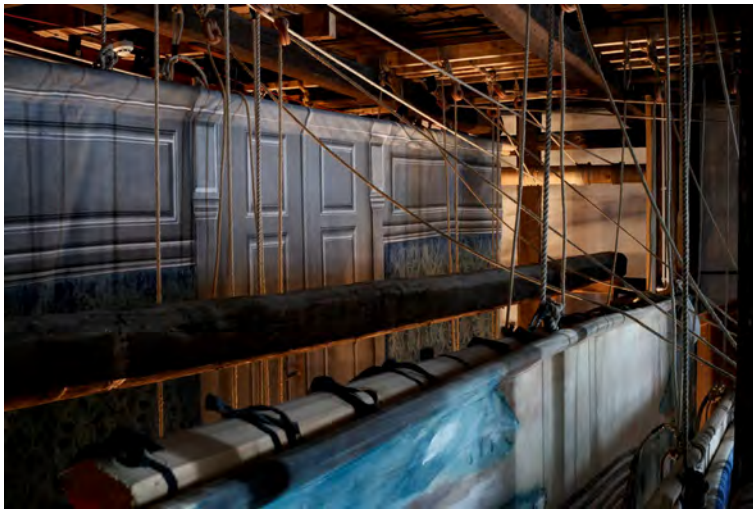
Abbildung 11. Blick in den Schnürboden der Oberbühne.
