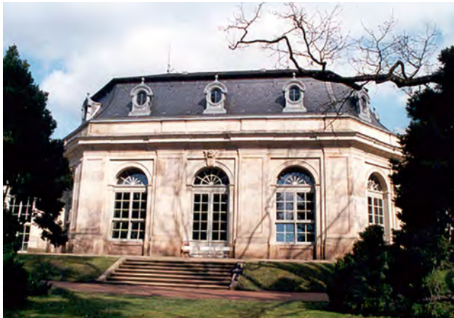
Abbildung 8. Mittelbau der Orangerie; ehem. Ringrennhaus (heutiger Zustand).
