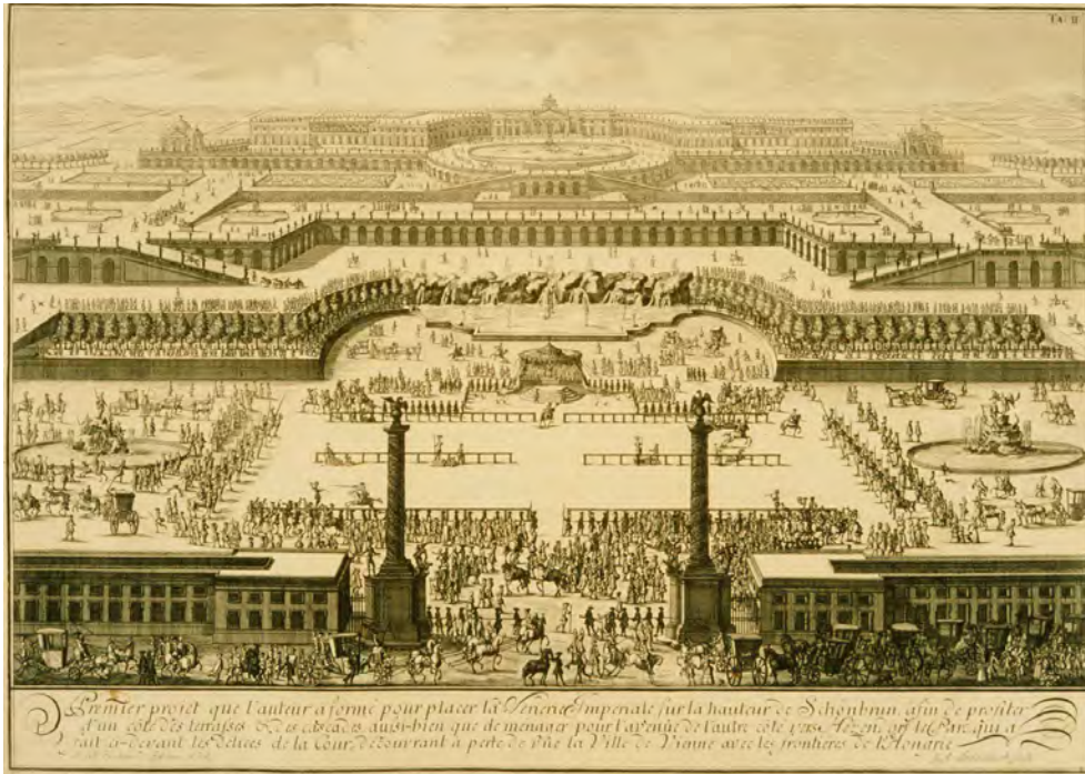
Abbildung 9. J. B. Fischer von Erlach: Erstes Projekt für Schloss Schönbrunn (1688) (aus: Historische Architektur , Buch IV, 17. II, 1721).
