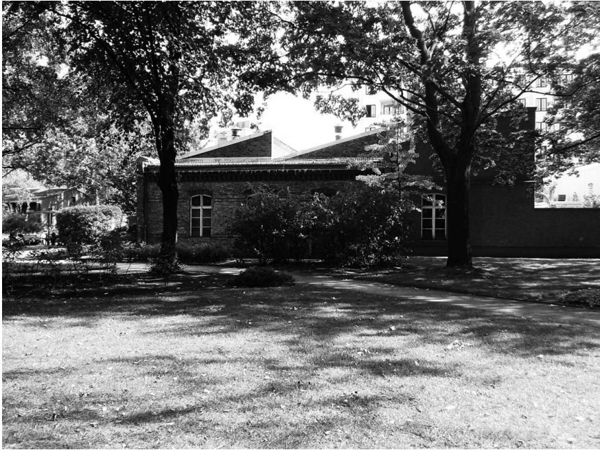
Abb. 17 Baracken mit verschlossenen Shed- bzw. Sägezahndächern der geschlossenen Venerologischen Station im Stadtkrankenhaus Prenzlauer Berg (2015)
