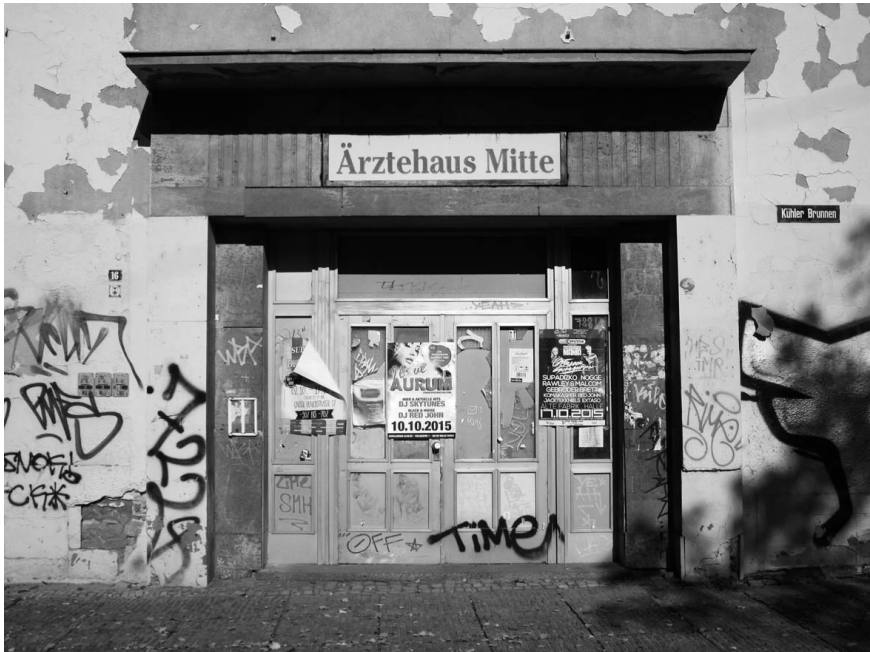
Abb. 10 Ärztehaus in der ehemaligen Poliklinik Mitte in Halle (Saale) (2015)
