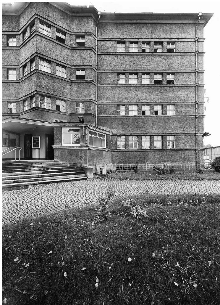
Abb. 21 Hilfskrankenhaus Bodelschwingstraße in Dresden (um 1947)
