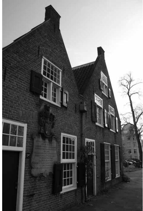
Afbeelding 5. De Breyerskamers werden in 1749 bij uiterste wilsbeschikking bestemd tot vrijwoningen voor armlastige leden van de hervormde kerk (foto: J. de Jong).
