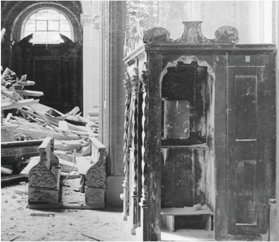
123 Aufnahme nach dem 16.10.1944, Schutt der eingestürzten Kuppel. Kirchenbänke und Beichtstuhl mit vermutlich nachträglich angefügtem Schrank. Salzburg, um 1700
