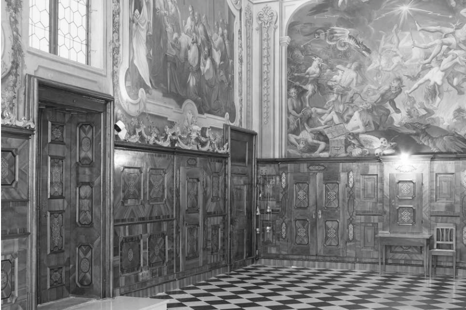
273 Sakristei, Ansicht von Süd- und Westwand mit Türen, Schränken und Wandvertäfelung. Vorau, 1716
