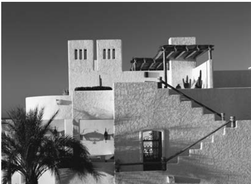
Las Ventanas al Paraiso, A Rosewood Resort, Los Cabos, Baja California, Mexico, 2005. Permission courtesy Rosewood Hotels and Resorts.
