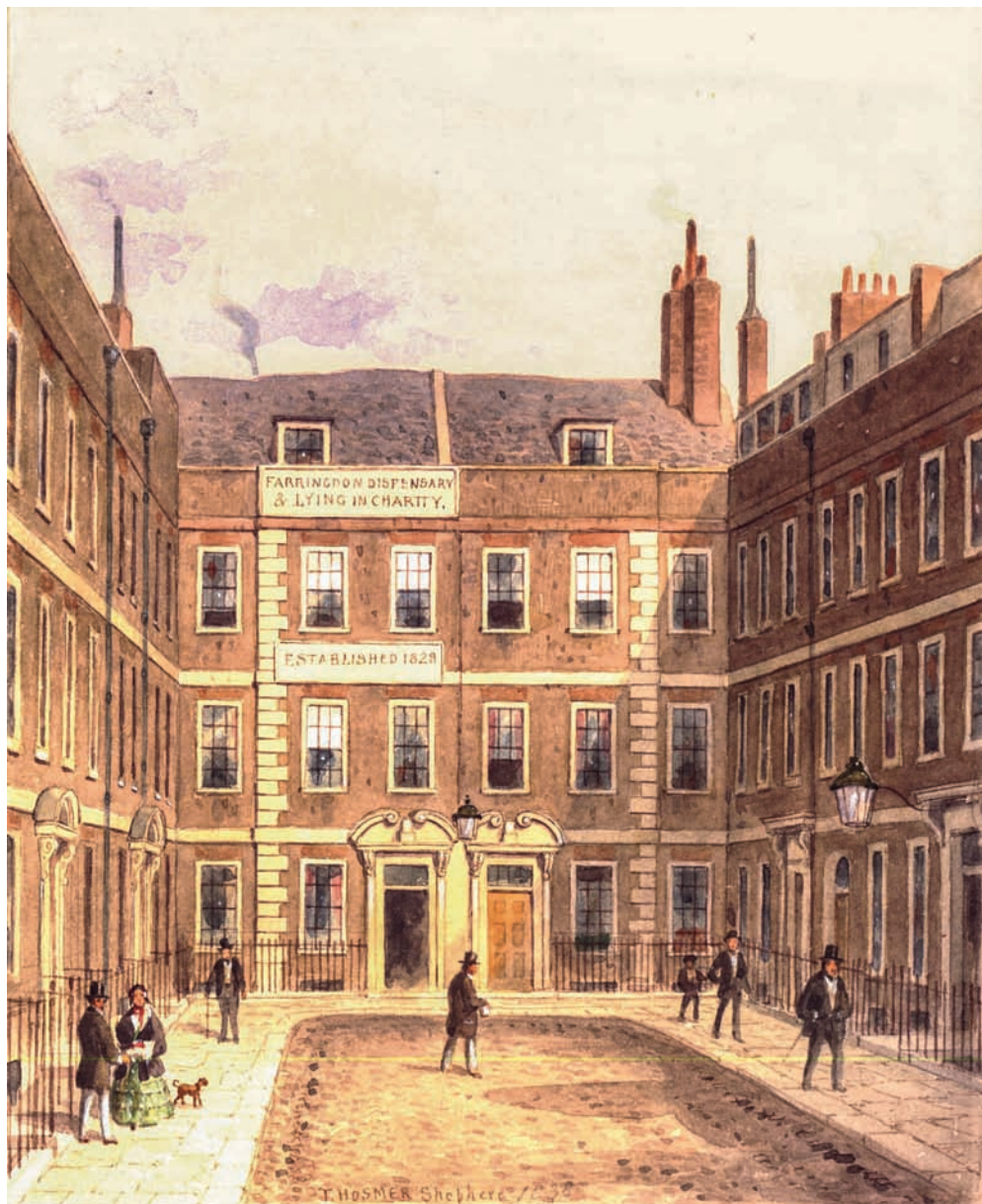
Figure 20. L'atelier de Londres : Bartlett's Buildings
