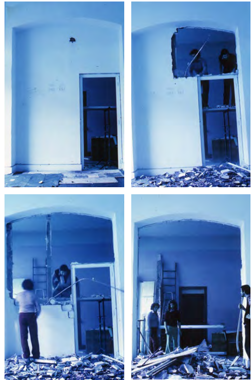
DESTRUCTION D'UN MUR DE LA GALERIE ECART À LA RUE PLANTAMOUR, ÉTÉ 1973 [© ARCHIVES ECART, MAMCO, GENÈVE].
