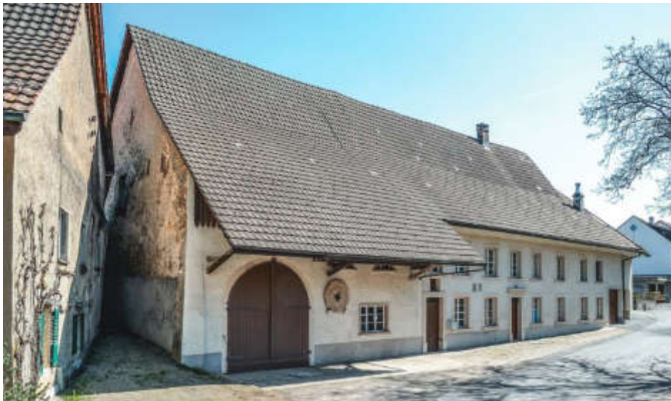
ABB. 321 Gipf-Oberfrick. Müliggass 11. Untere Mühle. Der langgezogene Mauerbau unter geknicktem Satteldach erstreckt sich parallel zum Bachufer und gliedert sich in ein zweigeschossiges Wohnhaus mit integriertem Mahlraum sowie einen Ökonomieteil mit Stall und Tenn. Die Einfassungen der in acht Achsen angeordneten Fenster und die Türrahmungen sind aus Muschelkalkstein gearbeitet. Zwei zwischen dem Mühlen- und dem Hauseingang eingemauerte Wappensteine mit einem Mühlrad und dem Schönauerwappen erinnern an die adlige Besitzerfamilie. Foto DPAG, Christine Seiler, 2017.
