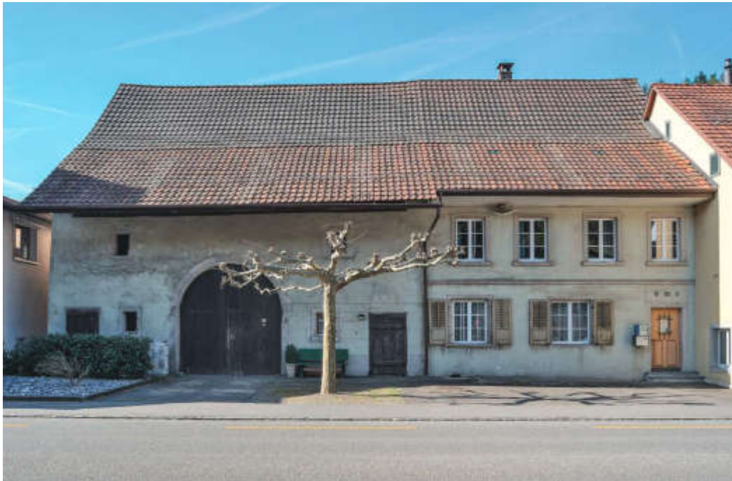
ABB. 388 Hornussen. Hauptstrasse 131 A/B. Spätgotisches Vielzweckgebäude, um 1600 erbaut in Gestalt eines Doppelbauernhauses mit intakt erhaltenem Wirtschaftstrakt, dessen Mitte ein Tenn mit Rundbogentor einnimmt. Foto DPAG, Christine Seiler, 2014.
