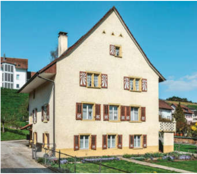
ABB. 359 Herznach. Unterdorfstrasse 7. Wohnhaus. In der Giebelfassade hebt sich die originale spätgotische Fensteranordnung im 3. Obergeschoss deutlich ab von den dreiachsig gestalteten unteren Geschossen mit ihren jüngeren Fensteröffnungen. Foto DPAG, Christine Seiler, 2016.
