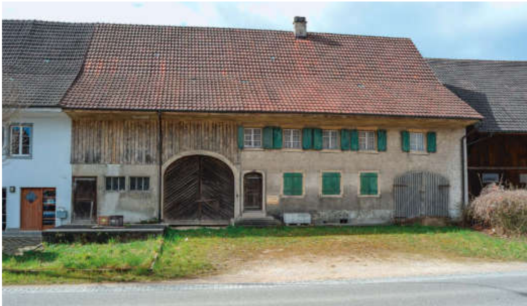
ABB. 247 Eiken. Hauptstrasse 24. Bauernhaus aus dem Jahr 1798. Der grosszügig bemessene Wohnteil enthält zwei Geschosswohnungen. Von der unteren Wohnung geht rechts aussen der Platz für eine Remise ab. In dieser befindet sich der Zugang zu einem querliegenden, zweige teilten Gewölbekeller. Dieser reicht strassenseitig etwas über die heutige Fassadenflucht hinaus, scheint also vom 1796 abgebrannten Vorgängerbau übernommen worden zu sein. Foto DPAG, Christine Seiler, 2016.
