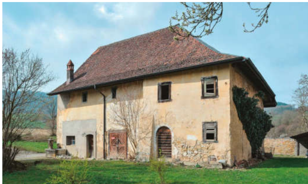
ABB. 511 Wölflinswil. Stöckli 30. Pfarrscheune. Ansicht von Nordosten. Der Nordteil des Gebäudes, Überrest einer mehrheitlich abgebroche- nen älteren Pfarrscheune, zeigt in der gegen das Pfarrhaus leicht vorsprin- genden, mit einem Eckstrebepefeiler verstärkten Fassade einen Zugang mit steinernem Rundbogengewände, der zum ältesten Baubestand gehört. Die holzgerahmten Rechteck- fenster in beiden Geschossen gehen auf den Umbau von 1845 zurück. Foto DPAG, Christine Seiler, 2016.
