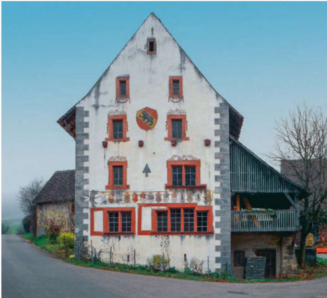
ABB. 444 Hottwil. Leumenstrasse 41a. «Untervogtshaus». Der stattliche spätgotische Steinbau mit steilem Satteldach steht unmittelbar an der Strasse nach Remigen. Die im 18. Jh. angebrachte Bemalung an der Ostfassade ist für einen ländlichen Bau ausserordentlich reich. Hinter dem vierteiligen Staffelfenster und dem angrenzenden Zwillingsfenster im Erdgeschoss liegen Stube und Nebenstube. Die oberen Geschosse bergen Schlafkammern und ehemalige Vorratsräume. Foto Schweiz. Bauernhausforschung, Brigitte Lattmann, 2001.
