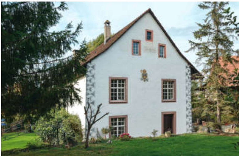
ABB. 411 Kaisten. Mühlweg 10. Ehemalige Stiftsmühle aus dem Jahr 1568. Das Äussere mit der auffallenden Eckbemalung und dem farbigen Wappen konnte 1976–1978 aufgrund von Befunden in seiner spätbarocken Form von 1789 wiederhergestellt werden. Foto DPAG, Christine Seiler, 2017.
