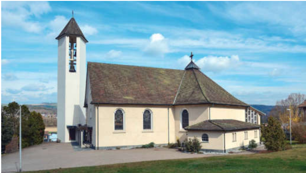
ABB. 469 Schwaderloch. Kirchweg. Katholische Pfarrkirche St. Antonius von Padua. Das zweiachsige Schiff der 1928 erbauten ehemaligen Kapelle unter einem Satteldach weitet sich an der Ostseite in den sechseckigen, mit einem Zeltdach und bekrönender Glaslaterne abschliessenden Zentralbau von 1955–56. Foto DPAG, Christine Seiler, 2019.
