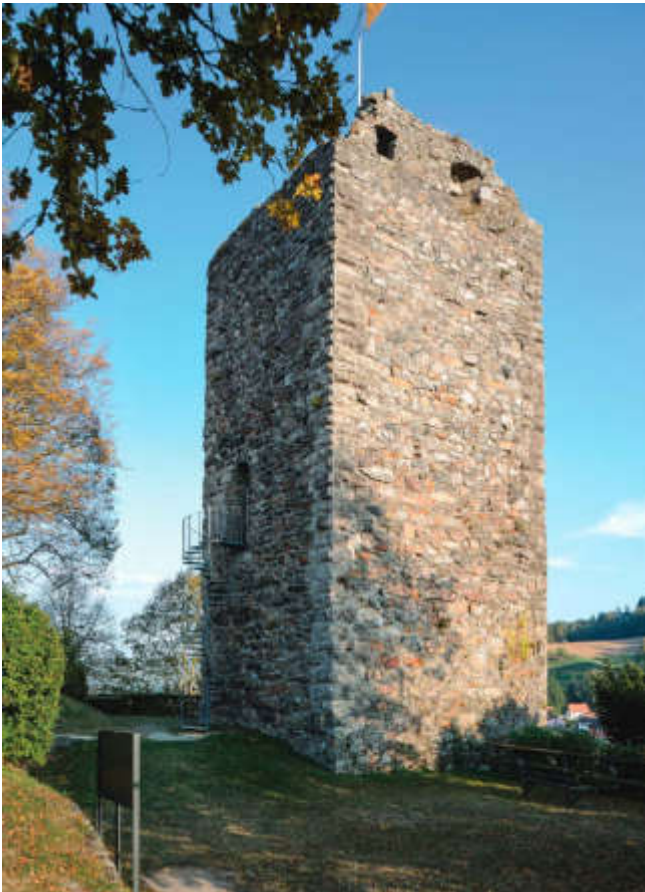
ABB. 46 Laufenburg. Schlossberg. Am Bergfried (Hauptturm) aus dem frühen 13. Jh. bilden Dolomitquader mit Bosse und Kantenschlag den Eckverband. An der Nordseite des Turms führt heute eine Stahlterrasse zum Hocheingang. Foto DPAG, Christine Seiler, 2016.
