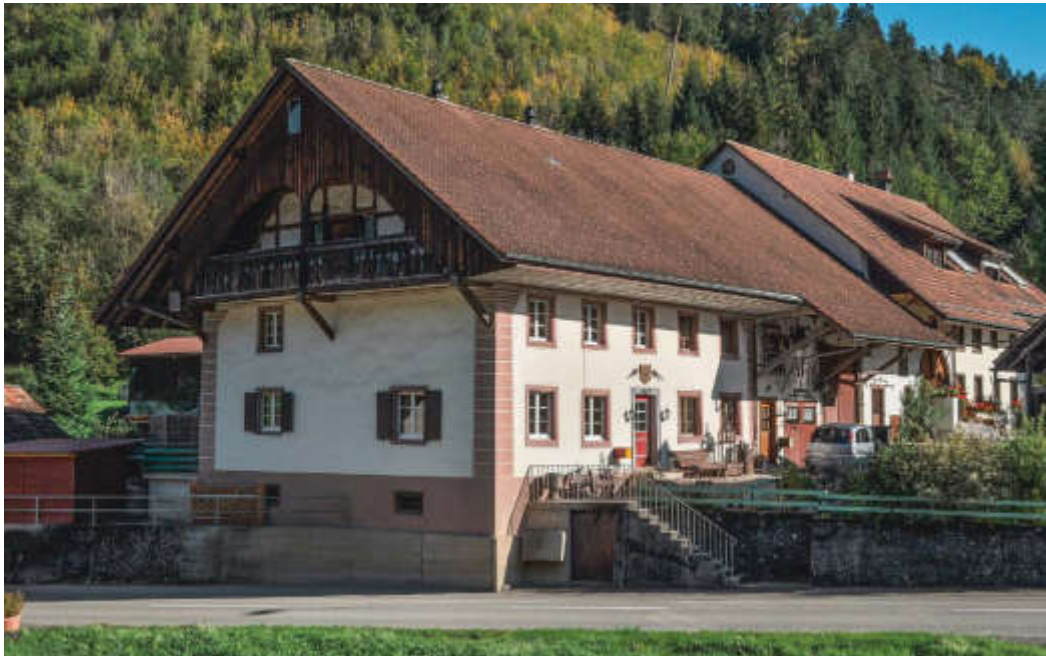
ABB. 227 Laufenburg, Sulz, Leidikon. Hauptstrasse 17. Bauernhaus. Den Wohnteil aus dem frühen 18. Jh. zeichnet eine nach Befund wiederhergestellte Eckquadrierung aus. Foto DPAG, Christine Seiler, 2012.
