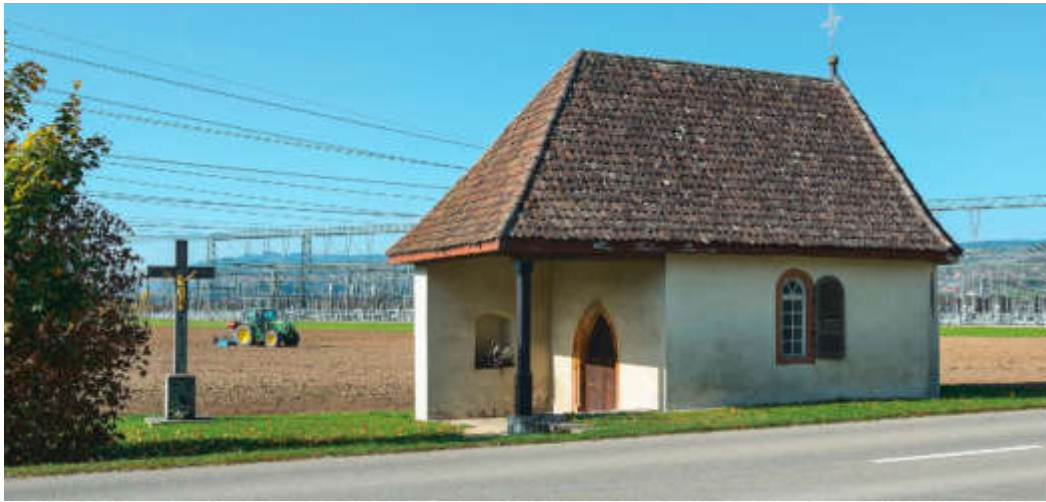
ABB. 410 Kaisten. Kaisterstrasse. Kapelle St. Wendelin. Die Kapelle, an der alten Landstrasse von Kaisten nach Laufenburg gelegen, wird heute bedrängt von der grossen Schaltanlage im Kaisterfeld und der stark befahrenen Verbindungsstrasse Kaisten–Laufenburg. Foto DPAG, Christine Seiler, 2017.
