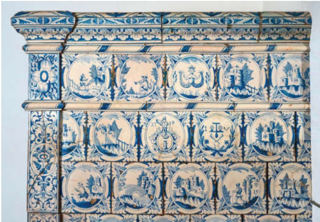
ABB. 156 Laufenburg. Fischergasse 151/152. Ehemaliges Gasthaus zum Meerfräulein. Eine doppel-schwänzige Meerjungfrau auf einer Frieskachel am 1735 datierten Kachelofen legt nahe, dass dieser eigens für das Gasthaus angefertigt wurde. Neben einer Füllkachel mit Jahreszahl und Besitzerwappen zeigt eine weitere Kachel wohl Handwerkerzeichen und die Initialen «IV» oder «IU» des Hafners. Foto DPAG, Christine Seiler, 2018.
