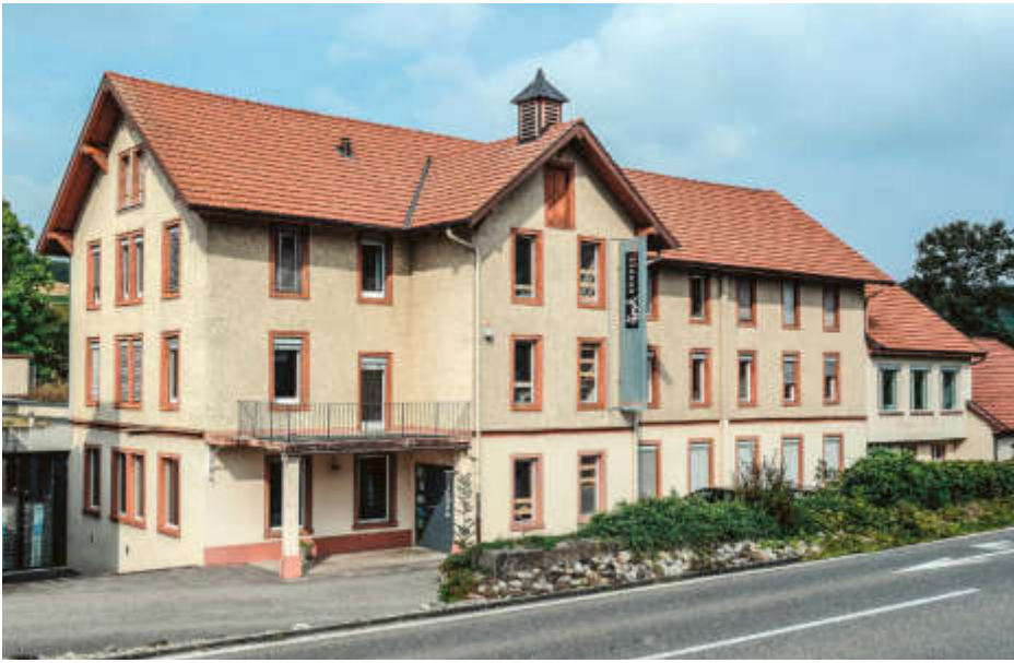
ABB. 360 Herznach. Hauptstrasse 2. Bandfabrik Van Spyk, erbaut 1872 und seither mehrfach erweitert. Im Bild das alte Hauptgebäude, das im August 2018 ausbrannte. Foto DPAG Christine Seiler, 2016.
