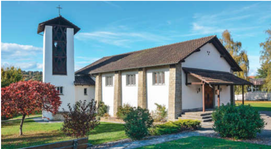
ABB. 432 Etzgen. Kapellenweg. Kapelle St. Nikolaus von Flüe. Mit der integralen Erhaltung von Form, Materialisierung und Ausstattung ist die 1949 vollendete Kapelle ein bedeutender Bauzeuge der unmittelbaren Nachkriegszeit. Foto DPAG, Christine Seiler, 2017.
