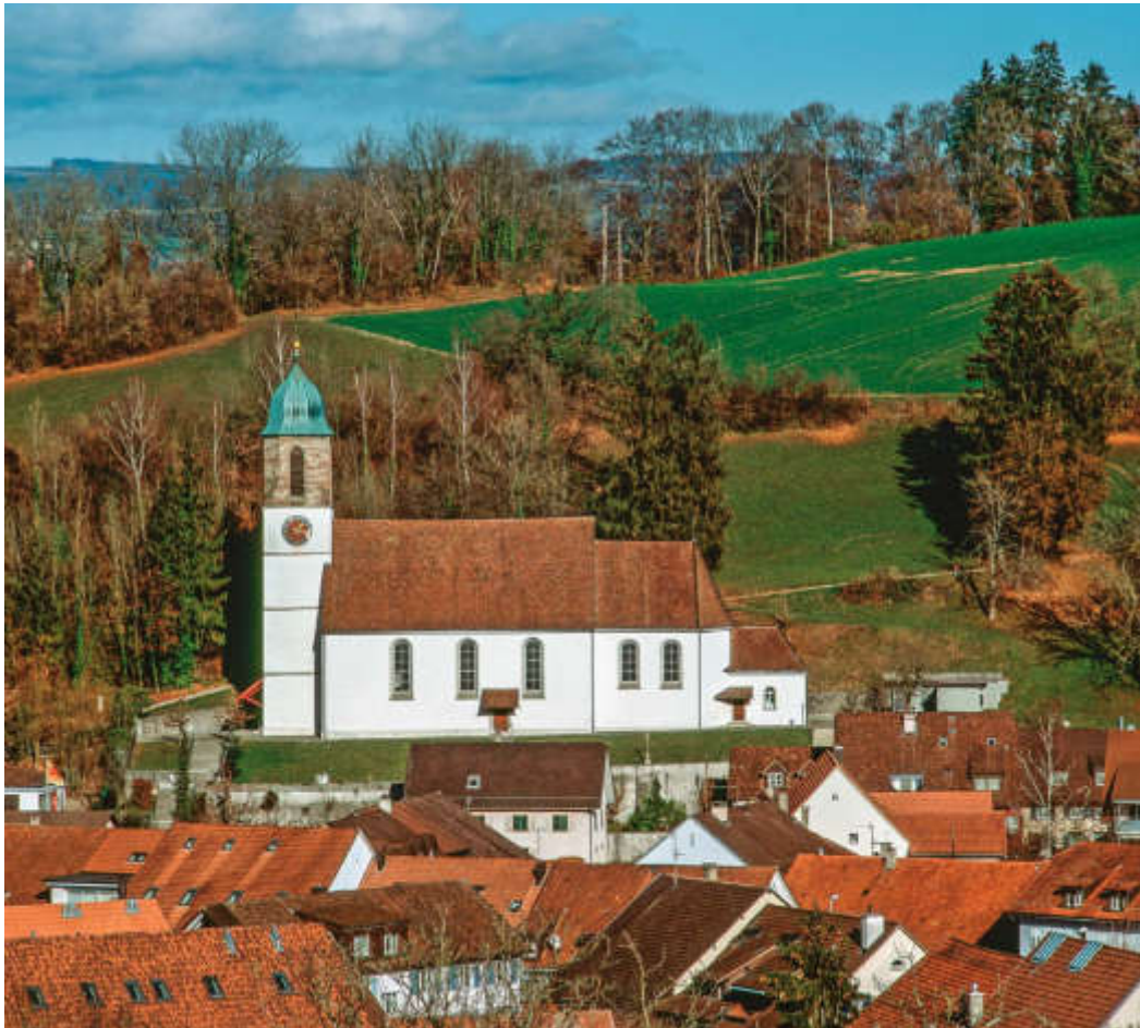
ABB. 404 Kaisten. Kirchrain. Katholische Pfarrkirche St. Michael. Ansicht von Südosten. Der in der Firsthöhe abgestufte Baukörper mit den hell verputzten Mauerflächen und dem Turmoktogonal aus oberrheinischem Buntsandstein mit der kupferverkleideten, geschweiften Haube überragt die Dachlandschaft der Wohnhäuser und hebt sich vor dem bewaldeten Abhang des Fasnachtbergs kontrastreich ab. Foto DPAG, Christine Seiler, 2015.
