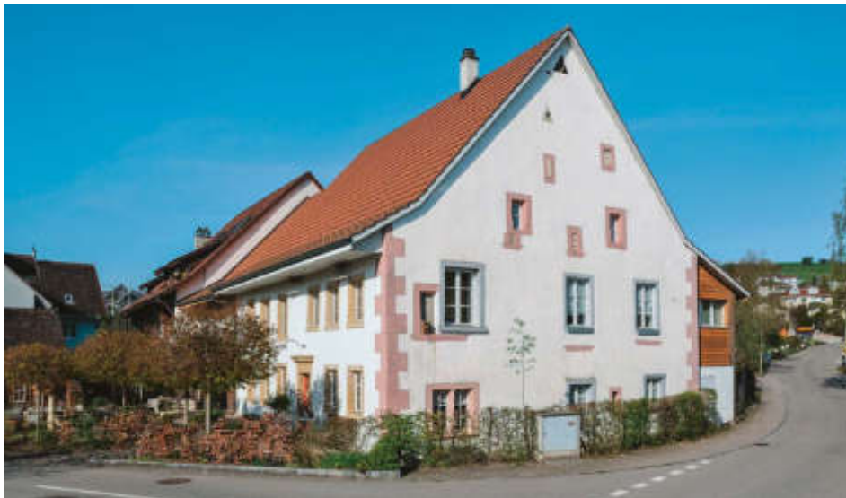
ABB. 320 Gipf-Oberfrick. Unterdorf 19. Die renovierte Fassade des ehemaligen Bauernhauses mit freigelegten älteren Fenstern zeigt anschaulich verschiedene Bau- und Benutzungsphasen vom Spätmittelalter bis heute. Foto DPAG, Christine Seiler, 2017.
