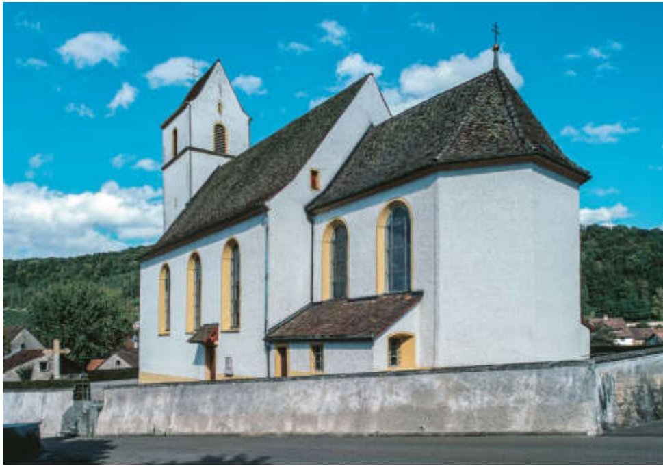
ABB. 378 Hornussen. Kirchgasse. Katholische Pfarrkirche St. Mauritius. Ansicht von Süden. Im Vordergrund der Chor mit den flankierenden schmalen Sakristeien, die eine Eigenheit der Hornusser Kirche darstellen. Foto DPAG, Christine Seiler, 2012.
