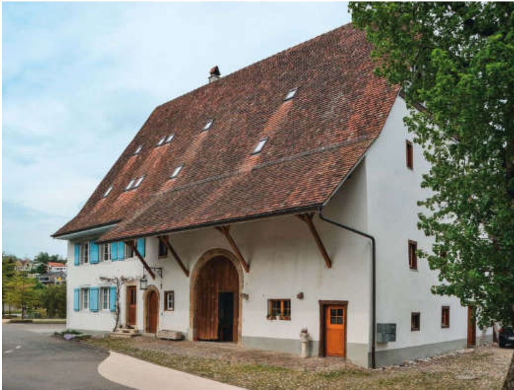
ABB. 466 Oeschgen. Hohlenweg 41. Schwedenhaus, erbaut um 1600. Das 1726 in den Umfassungsmauern erneuerte und mit einem Steildach versehene Gebäude erhielt 1747/48 durch eine giebelseitige Erweiterung der Scheune seine heutige Gestalt. Foto DPAG, Christine Seiler, 2013.
