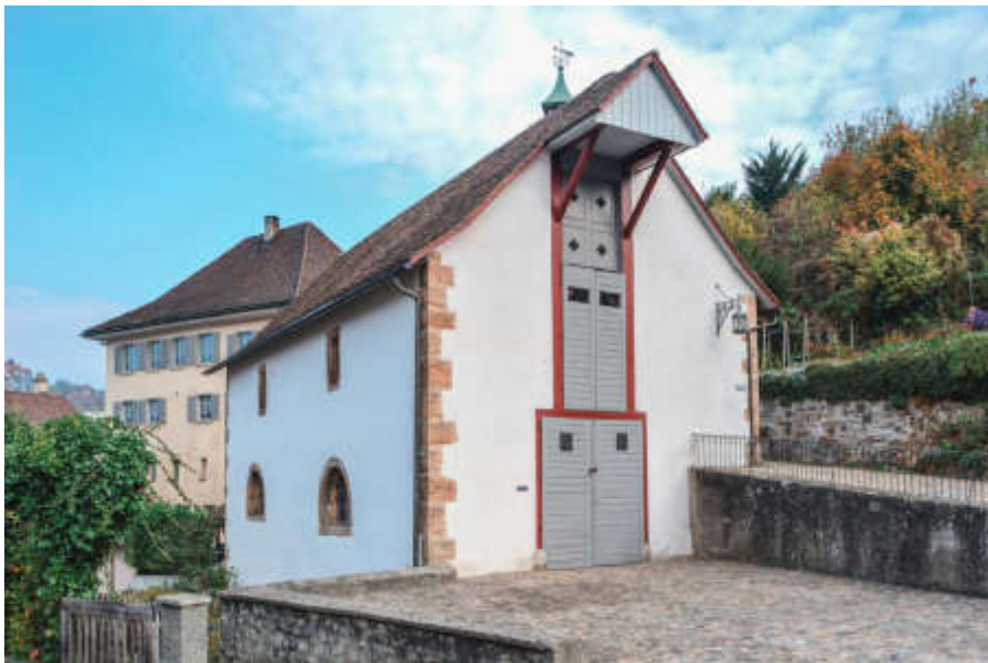
ABB. 191 Laufenburg. Gerichtsgasse. Altes Zeughaus. Der rechteckige, wenig befensterte Steinbau mit nicht unterteilten Geschossen zeigt eine für spätmittelalterliche Lagerhäuser typische Bauform. Foto DPAG, Christine Seiler, 2016.
