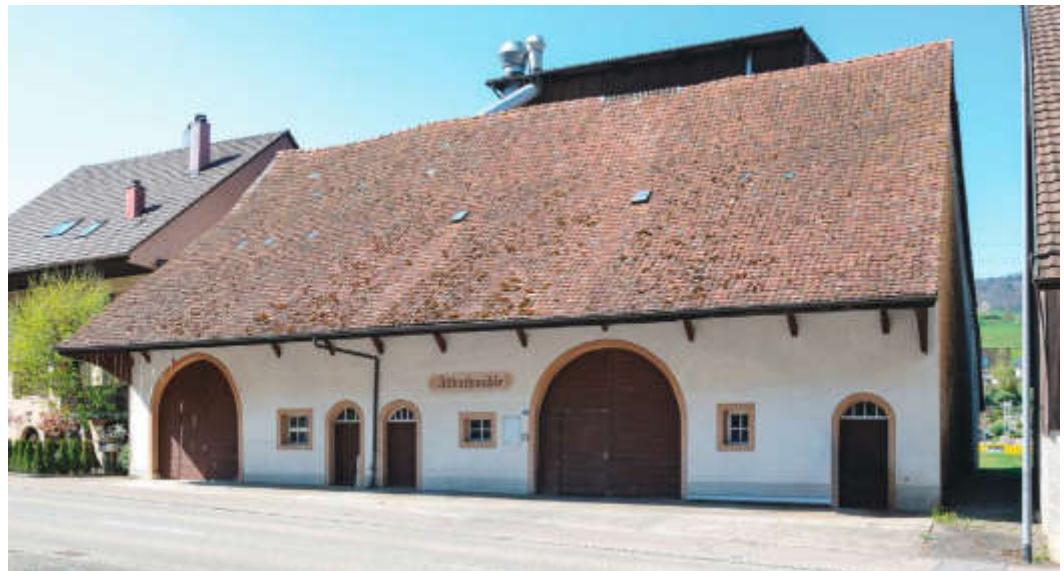
ABB. 488 Wittnau. Hauptstrasse 78. Mühlenscheune von Südosten. Der stattliche Baukörper der Stallscheu- ne ist ein prägendes Element der traufständigen Zeilenbebauung gegenüber der Altbach- mühle. Foto DPAG, Christine Seiler, 2017.
