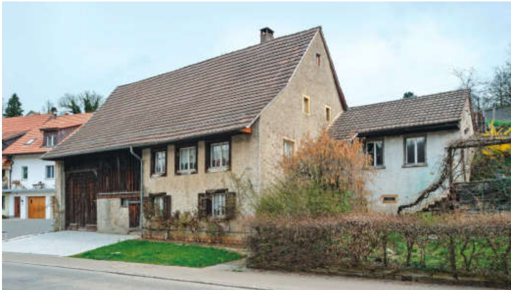
ABB. 514 Wölflinswil. Unterdorf 66. Bauernhaus. Am Wohnteil sind die vom Dach geschützten traufseitigen Fenster mit Holzrahmen ausgestattet. Für die ungeschützten Öffnungen in der Giebelfassade verwendete man hingegen Steingewände. Foto DPAG, Christine Seiler, 2016.
