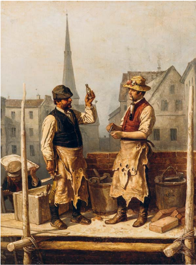
Abb. 3.2: Theodor Hosemann: Maurer beim Bau des Roten Rathauses (1860).
