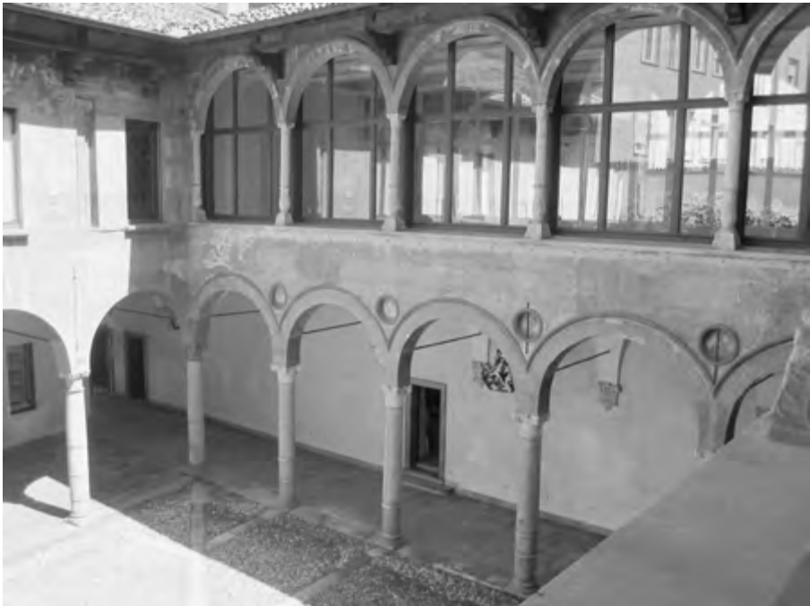
256 Palazzo Fontana Silvestri, Milano. Veduta del cortile dall'ingresso.
