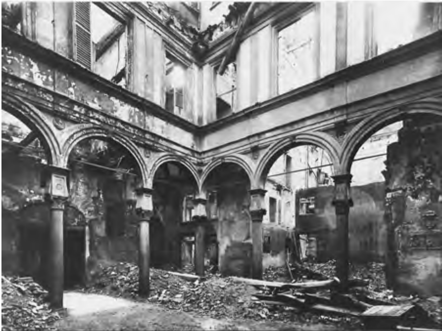
41 Palazzo Botta, Milano. Veduta del cortile.
