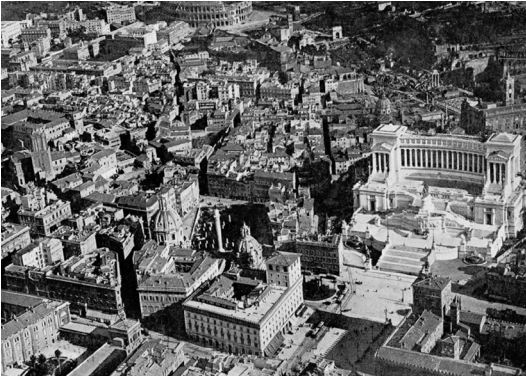
Abb.101 Gebiet um das Denkmal für Vittorio Emanuele II., Blick Richtung Kolosseum, vor dem Beginn der Abbrucharbeiten, Luftbild, vermutlich vor 1930
