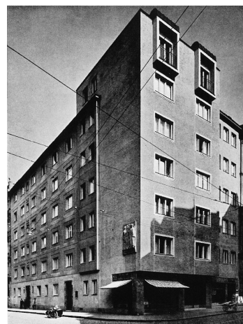
Abb. 18 Hermann Stiegholzer, Assanierungsbau Ecke Beatrixgasse und Ungargasse (Beatrixgasse 5-7), Aufnahme vermutlich 1937
