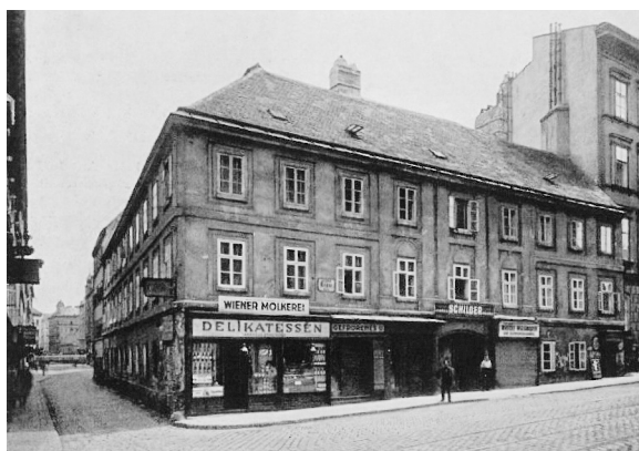
Abb. 19 In den 1930er-Jahren abgebrochenes Altgebäude Beatrixgasse 5-7, Aufnahme vermutlich 1937
