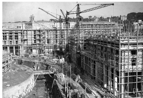
Abb. 107 Piazza Augusto Imperatore, Baustelle der angrenzenden Neubauten, November 1938
