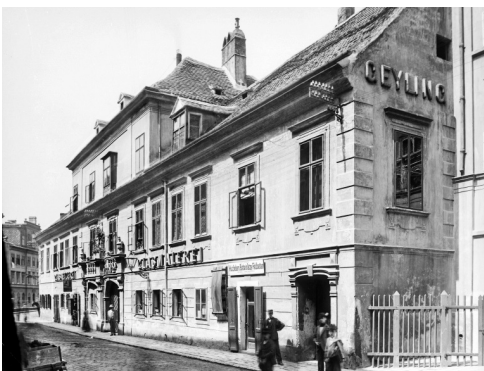
Abb. 62 August Stauda, Ansicht des „Geylinghauses“, Windmühlgasse 28, 1899
