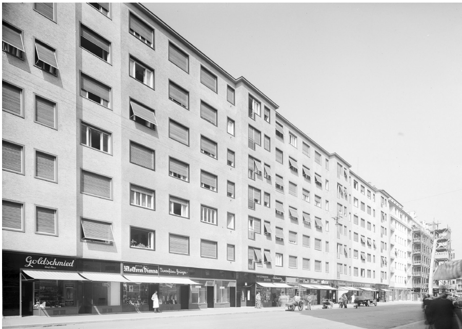
Abb. 68 Fronten der fertiggestellten bzw. in Bau befindlichen Neubauten auf dem Gelände des Freihauses, Operngasse 30–34, 1937
