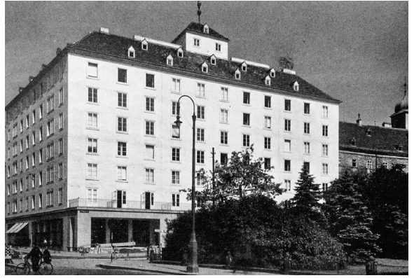
Abb. 88 Kurt Klaudy, Georg Lippert und Anton Liebe, Ansicht des gerade fertiggestellten Dominikaner-Neubaus, 1938
