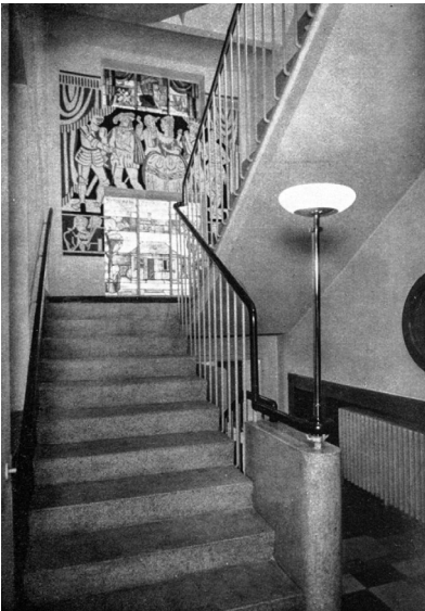
Abb. 41 Alfred Adler und Martin Schmid, Rosso Fiorito in der Eingangshalle und im Stiegenhaus des Assanierungsbaus Operngasse 28, nach der Fertigstellung, Aufnahme vermutlich 1938
