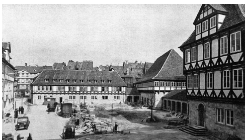
Abb. 125 Altstadtsanierung in Hannover, Freilegung des Ballhofes und Errichtung des HJ-Heimes, Aufnahme 1939
