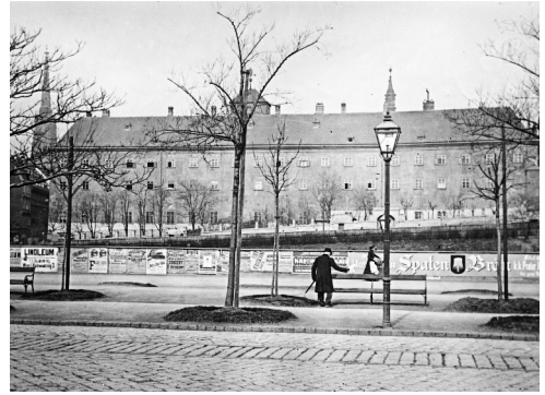
Abb. 86 Dominikanerkloster mit Schlosserturm (mittig im Bild), Blick vom Stubenring, 1896
