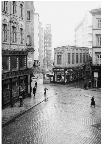
Abb. 70 Stockwerkaufnahme auf die Kreuzung Schleifmühlgasse und Operngasse, im Hintergrund die neu angelegte Operngasse, Ausschnitt, um 1935
