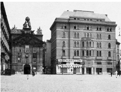
Abb. 134 Das „Kugelhaus“, Am Hof 11, nach der „Entstuckung“ der neobarocken Fassade, 1934
