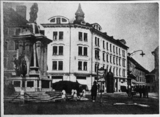
Gegenbeispiel: Illgliche Dach- und Bekleidung, hässliche und unzweckmäßige Fensterverteilung.
