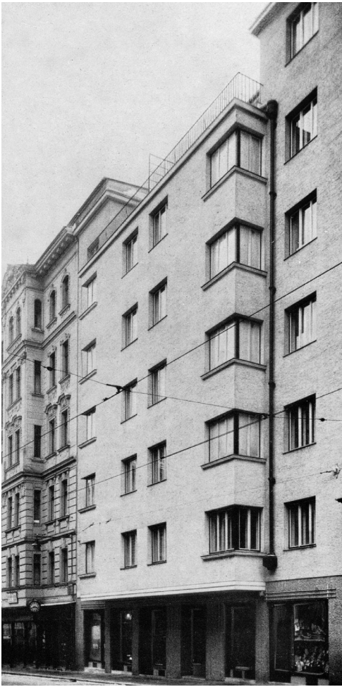
Abb. 42 August Strang, Assanierungsbau mit Staffeltgeschoss an der Josefstädter Straße 3, Aufnahme vermutlich 1938
