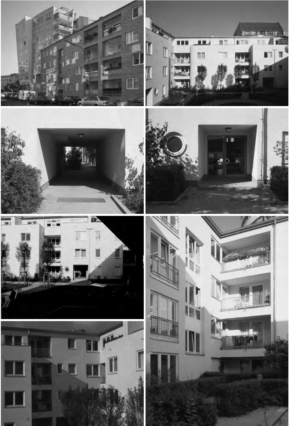
30 a-g Straßen- und Hofansichten nach Fertigstellung des Mietwohnhauses an der Dessauer Straße 38-40, Myra Warhaftigs Dokumentation des Außenbaus, um 1993
