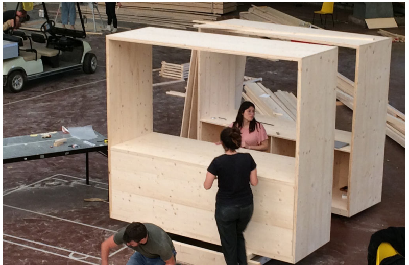
ABB. 2 EINBAU DER INFRASTRUKTUR
