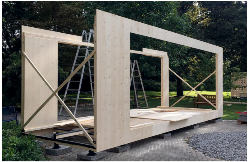
MONTAGE DER SEITENELEMENTE
