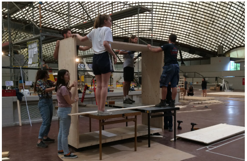
ABB. 1 BAU DES RAHMENS
