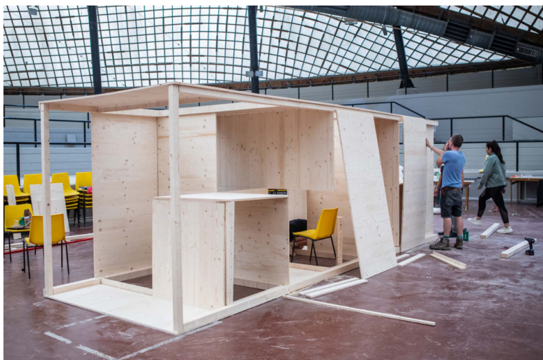
ABB. 2 VERBINDEN DER VER- SCHIEDENEN SEITENTEILE
