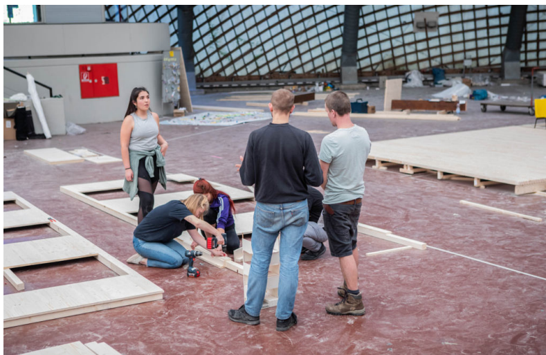
ABB. 1 FERTIGUNG DER SEITENFASSADEN
