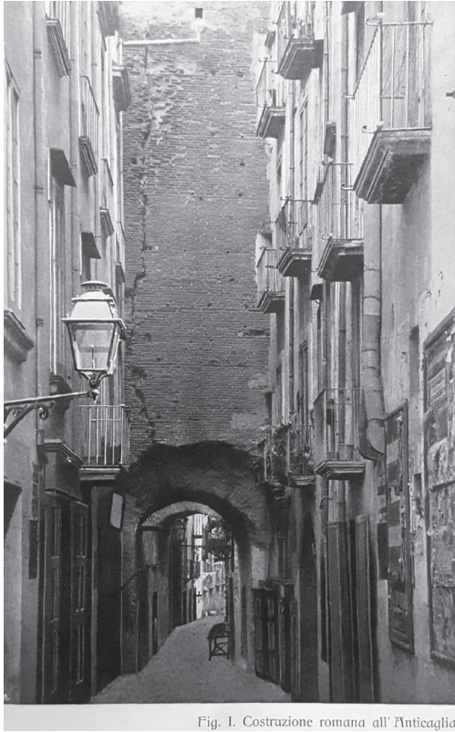
Fig. 1. Costruzione romana all' Anticaglia
