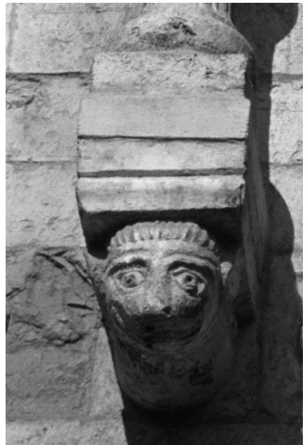
Abb. 84 Todi S. Maria Ann. Apsis Untergeschoss Blindbogenfries Konsolle Tierkopf mit Bleieinlage
