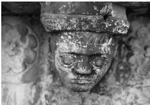
Abb. 83 Assisi S. Rufino Fassade Konsolgesims Konsolkopf mit Bleieinlage (vor der Rest., 1998)
