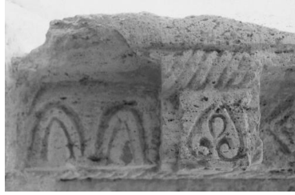
Abb. 150 Assisi S. Rufino Apsis Untergeschoss Gesims Dekor
