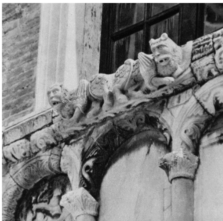
Abb. 129 Ancona S. Maria dP Fassade Obergeschoss Gesims Detail
