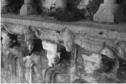
Abb. 125 Assisi S. Rufino Fassade Konsolgesims Detail (vor der Rest., 1998)
