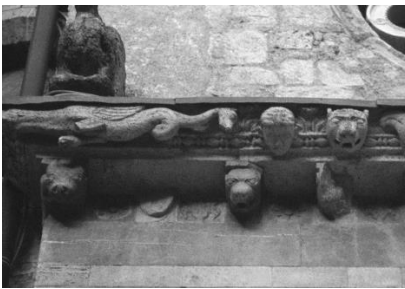
Abb. 135 Foligno S. Feliciano südl. Querhaus Fassade Gesims Detail
