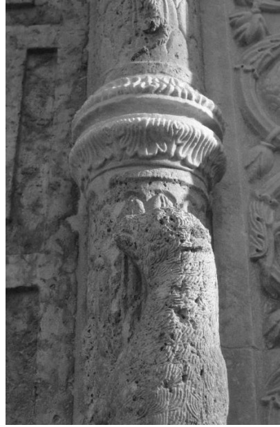
Abb. 98 Assisi S. Rufino Fassade Mittelportal rechter Halbrundstab Detail
