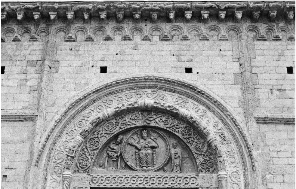
Abb. 91 Assisi S. Rufino Fassade Mittelportal Archivoltenzone u. Konsolgesims
