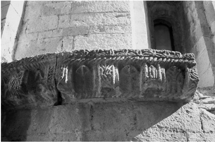
Abb. 151 Assisi S. Pietro Apsis Untergeschoss Gesims Abschnitt
