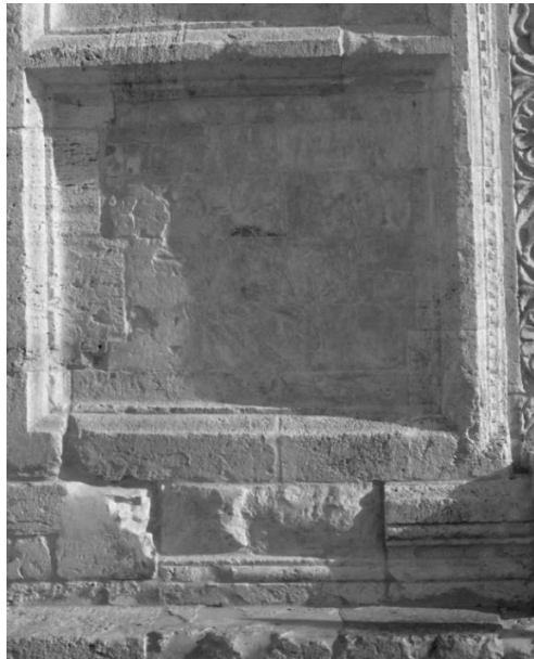
Abb. 15 Assisi S. Rufino Fassade Sockel links
