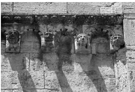
Abb. 103 Bevagna S. Michele Arc. Fassade Blendbogenfries Abschnitt
