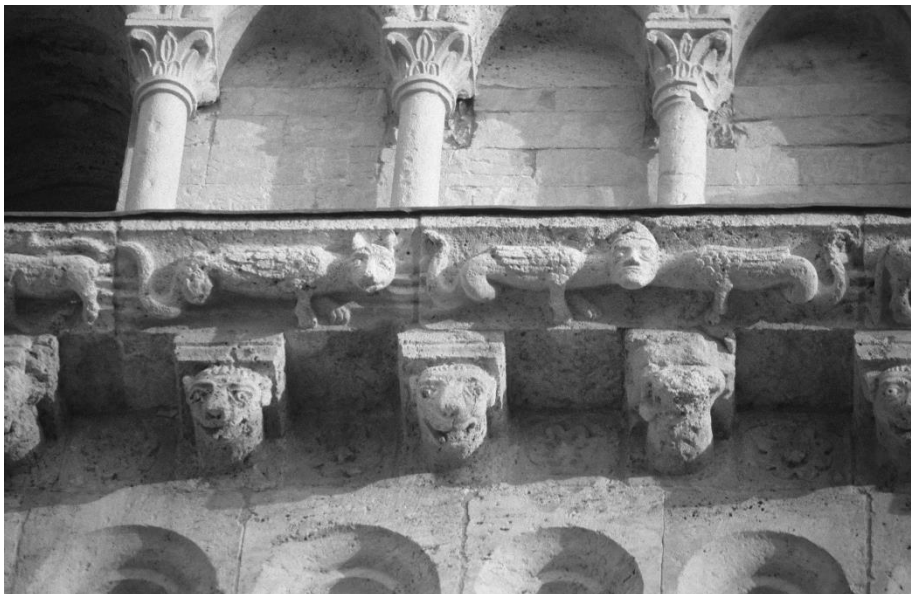
Abb. 124 Assisi S. Rufino Fassade Konsolgesims Abschnitt
