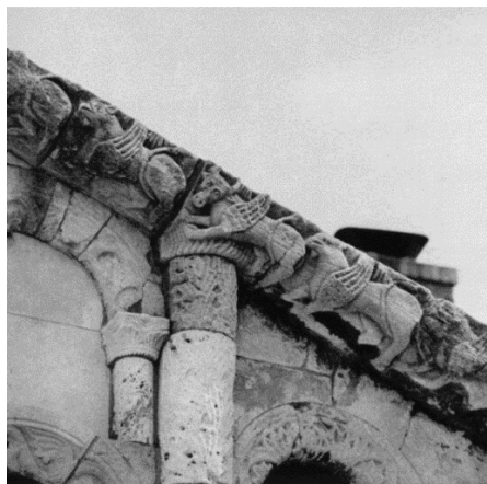
Abb. 130 Ancona S. Maria dP Fassade Obergeschoss Gesims Detail
