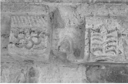
Abb. 149 Assisi S. Rufino Apsis Untergeschoss Gesims Dekor
