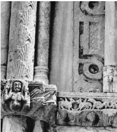
Abb. 127 Ancona S. Maria dP Fassade Untergeschoss Gesims Detail
