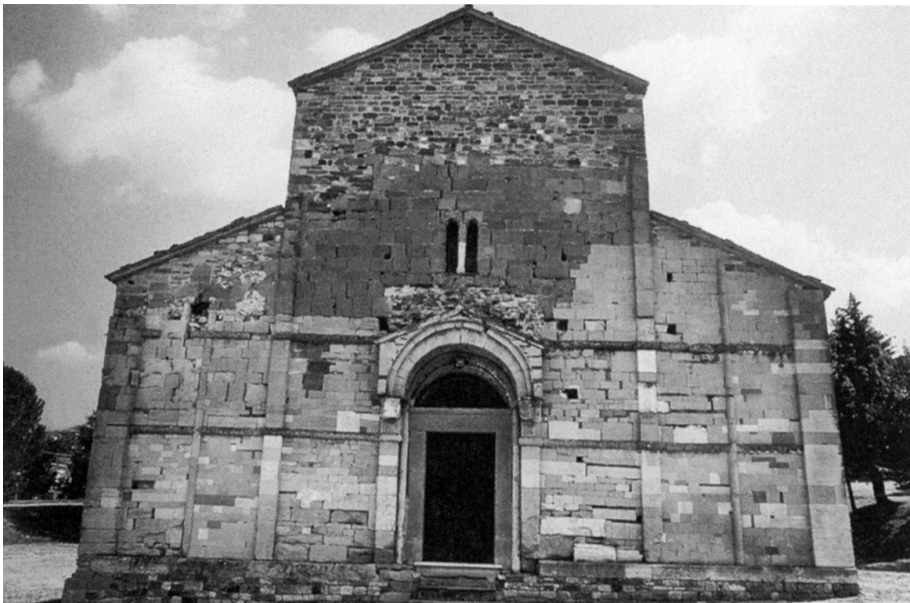
Abb. 55 Pennabilli S. Pietro a Ponte Messa Fassade
