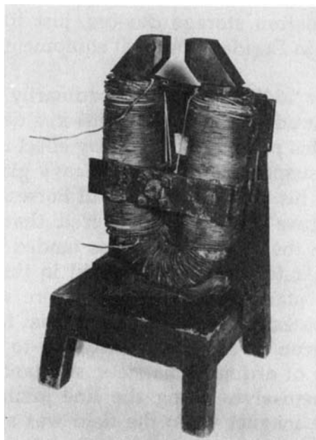
FIGURA 32 – Il grande elettromagnete costruito ed usato da Faraday.
