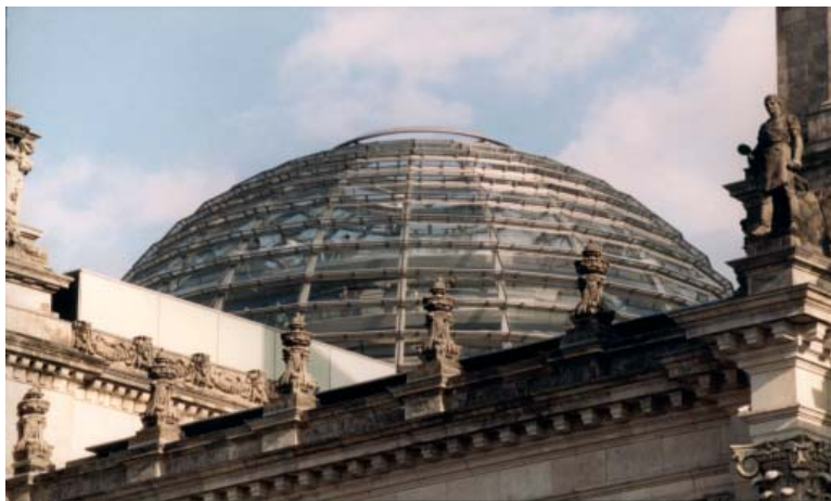
Figura 1 – Reichstag, Berlino, progetto di Norman Foster, 1993. La nuova cupola ha una struttura d'acciaio ed è rivestita da due strati di vetro interposti da uno strato intermedio di vinile di stagno. Al centro della cupola vi è il "light sculptor", un tronco di cono che è rivestito di 360 specchi di vetro altamente riflettenti ed è munito di uno schermo mobile "sun-following" automatizzato, alimentato da celle fotovoltaiche. Foto G. Mussi, 2004.
