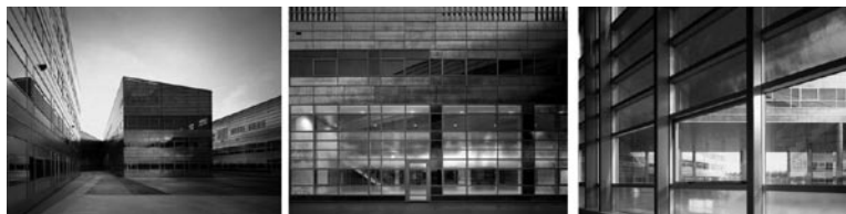
Figura 1 – UN Studio, Edificio La Defense, Almere, 2004. Il film dicroico Multilayer Optical Films di 3M™ divide la luce in colori spettrali: in base all'angolo di incidenza, genera colorazioni diverse nella trasmissione e nella riflessione.
