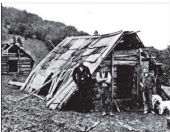
Fig. 59. Rifugio di pastori nei Beskidi; sullo sfondo, capanna con pareti a tronchi d'albero non incastrati (da Kubijowicz).
