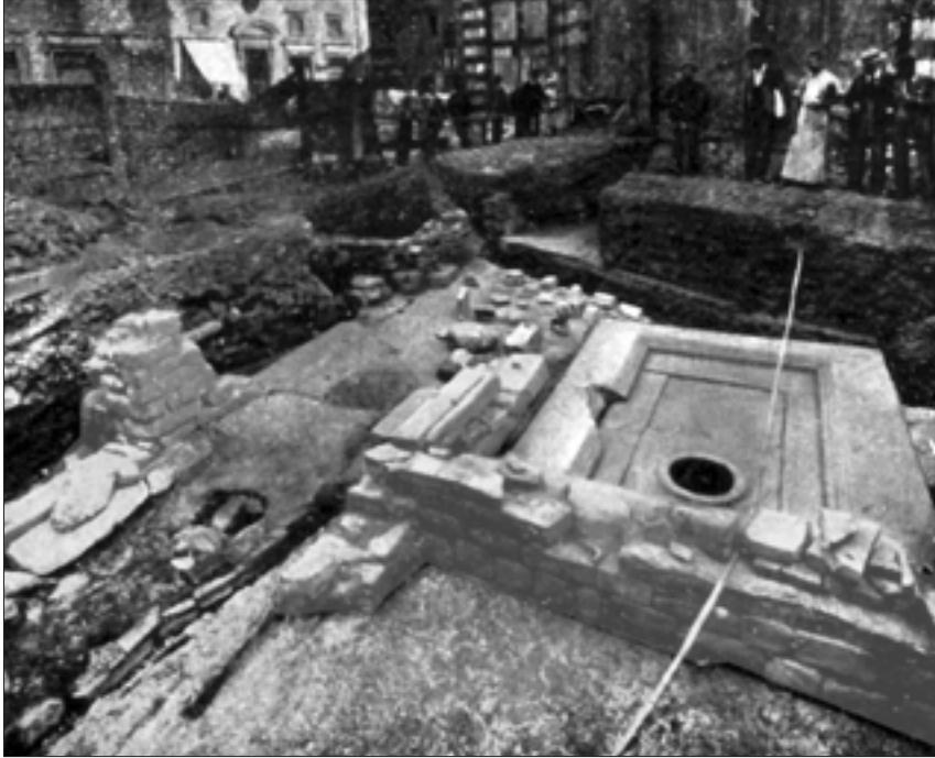
Figura 51. Strutture impostate sopra l'impluvio della domus rinvenuta a sud del battistero. Foto da AFSBAT
