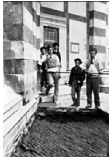
Figura 87. Fotografia della pavimentazione in laterizi di piazza S.Giovanni (1895, foto AFSBAT)
