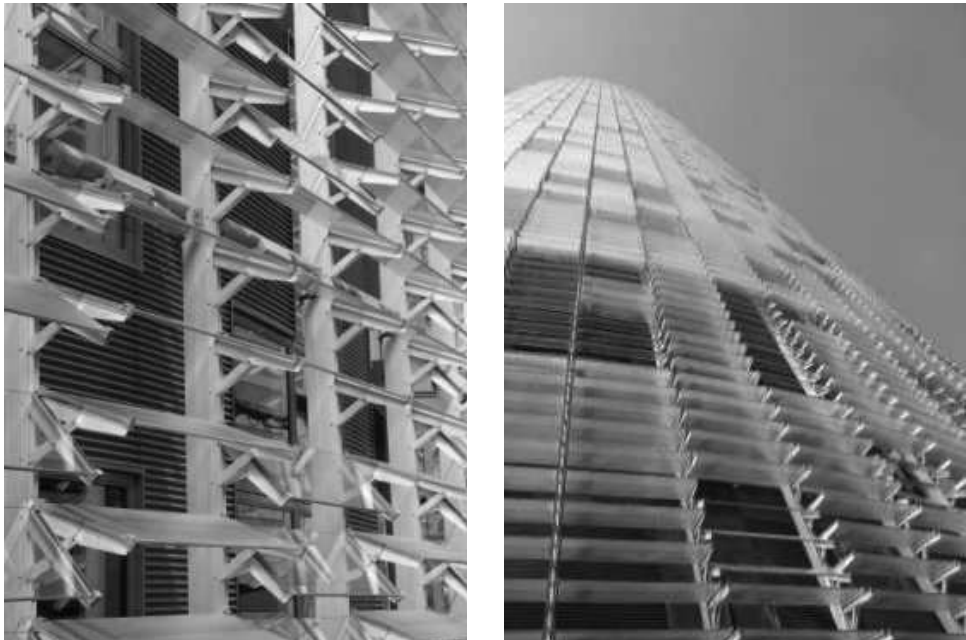
Fig. 3.15: Torre Agbar, Jean Nouvell, Barcellona, 2007. L'edificio è caratterizzato da un sistema di facciata doppia pelle in cui il layer esterno è stato realizzato come un brise-soleil in vetro con vari gradi di trasparenza. Il sistema a lamelle esterne regolabili garantisce la ventilazione naturale nell'intercapedine soprattutto nei mesi estivi quando la temperatura esterna è molto elevata.
