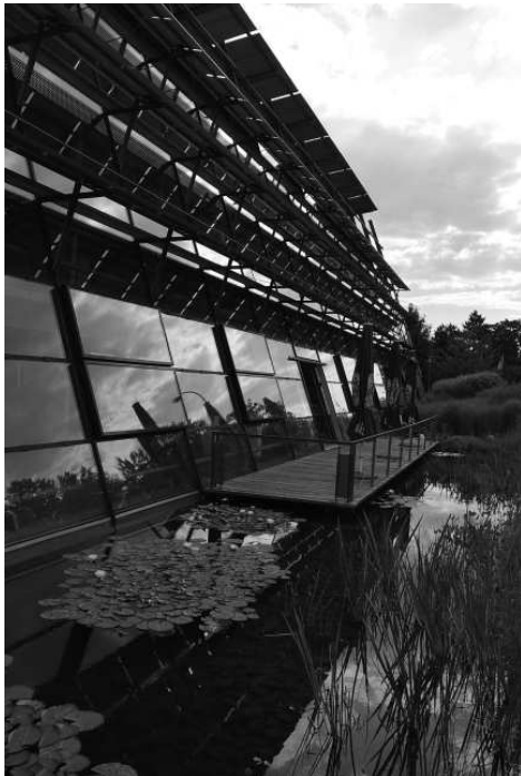
Fig. 2.16: Solar Fabrik, Rolf + Hotz freie Architekten BDA, Friburgo, 1999. Più volte premiato: è un edificio a zero emissioni. Un sistema energetico intelligente copre l'intero fabbisogno di calore ed elettricità tramite energie rinnovabili. La facciata a Sud è totalmente trasparente e schermata da dei brise soleil fotovoltaici.
