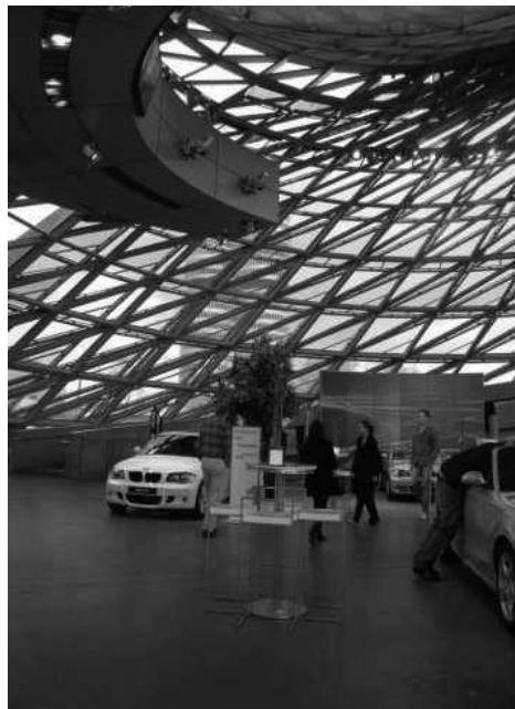
Fig. 2.11: BMW Welt, COOP HIMMELB(L)AU, Monaco, Germania, 2007. Nella doppia pelle dell'edificio è integrato un sistema di tubi radianti che provvedono al suo riscaldamento e raffreddamento. La copertura è completamente rivestita da pannelli fotovoltaici che producono parte dell'energia elettrica di cui ha bisogno l'edificio.
