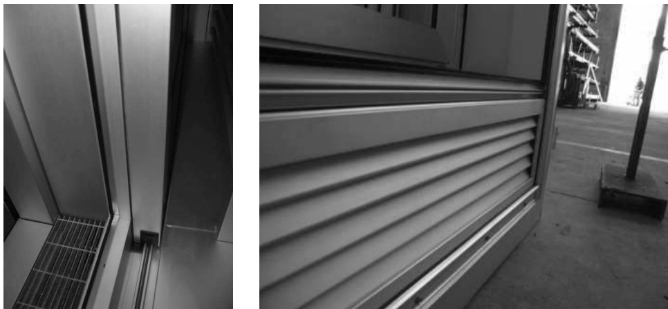
Fig. 5.18: Particolari griglia di ventilazione
