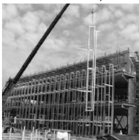
Messa in opera della struttura di supporto
