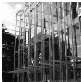
Montanti e traversi della pelle esterna
