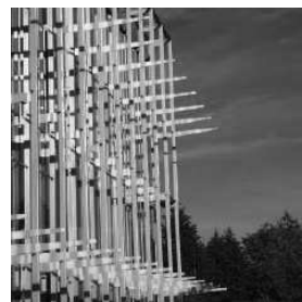
Montanti e traversi della pelle esterna
