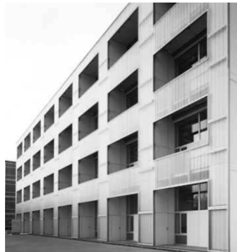
Fig. 2.6: Istituto Universitario, Pfeifer Kuhn Arkitekten, Friburgo, 2006. L'involucro architettonico è caratterizzato da una doppia pelle con una superficie trasparente in vetro sovrapposta ad un muro rivestito di legno. L'aria tra i due layer incrementa l'inerzia termica degli elementi di chiusura verticale opaca: Nei mesi invernali è utilizzata per il riscaldamento degli uffici, d'estate ne limita il surriscaldamento.
