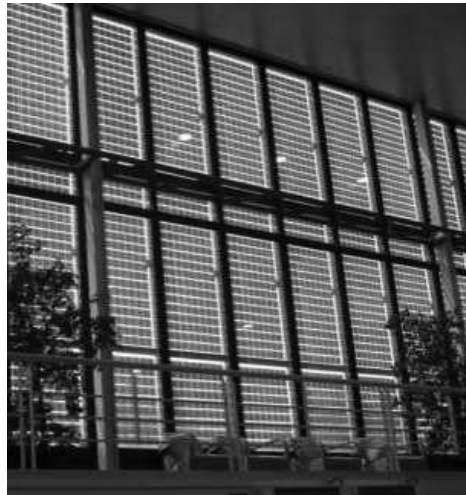
Fig. 2.10: Biblioteca Pública Pompeu Fabra, Miquel Brullet Matarò, Barcellona, Spagna, 1998. Si tratta di uno dei primi edifici d'Europa in cui è realizzata una facciata fotovoltaica in pannelli di silicio policristallino semitrasparente. Il fotovoltaico contribuisce alla produzione di energia elettrica per l'edificio e funziona come sistema di ombreggiatura per la sala lettura.
