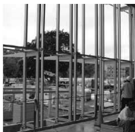
Struttura di supporto alla facciata vista interna
