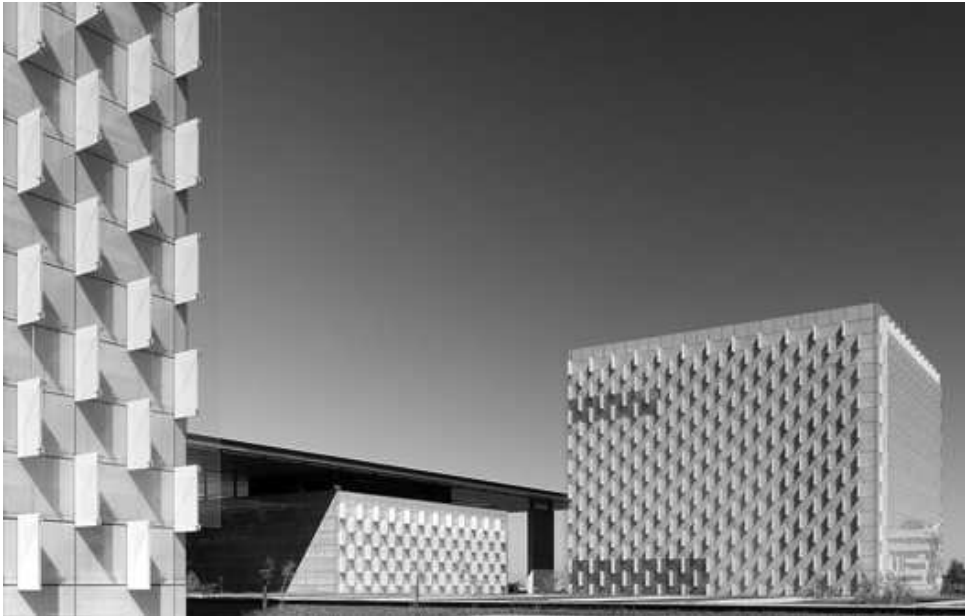
Fig. 2.17 e Fig. 2.18: Distrito C, Telefónica's Headquarters, Rafael de la-Hoz Architects, Madrid, 2008. Il progetto è sviluppato con la volontà di ridurre l'impatto ambientale del nuovo insediamento e si caratterizza per l'uso di sistemi tecnologici prefabbricati e di tecnologie per la produzione di energia da fonti rinnovabili: la copertura ospita il più grande impianto fotovoltaico esistente in Spagna, che produce il 40 dell'energia elettrica necessaria all'edificio. La facciata evanescente, scandita per tutta la superficie da un sistema di schermature a lamelle verticali, è caratterizzata dalla presenza di un doppia pelle realizzata con un nuovo tipo di vetro sviluppato proprio per questo edificio: si tratta di una superficie che risulta trasparente dall'interno e opaca dall'esterno.
