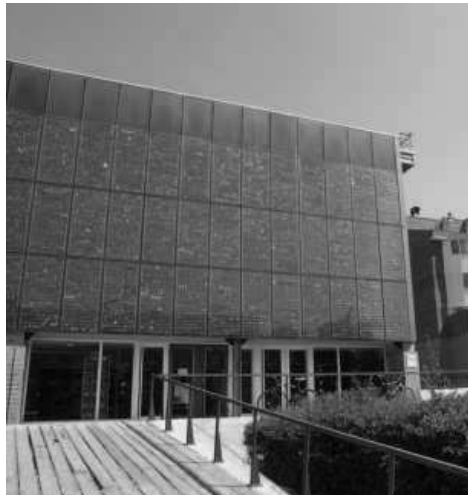
Fig. 2.10: Biblioteca Pública Pompeu Fabra, Miquel Brullet Matarò, Barcellona, Spagna, 1998. Si tratta di uno dei primi edifici d'Europa in cui è realizzata una facciata fotovoltaica in pannelli di silicio policristallino semitrasparente. Il fotovoltaico contribuisce alla produzione di energia elettrica per l'edificio e funziona come sistema di ombreggiatura per la sala lettura.
