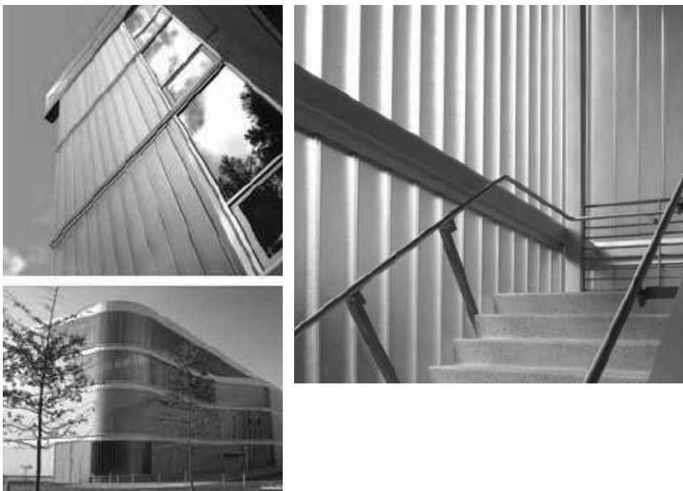
Fig. 4.25: Esempi di applicazione del Nanogel in una struttura Uglass messa a punto dalla Pilkington (Pilkington Profilfit)
