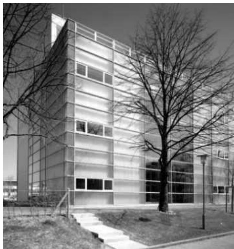
Fig. 2.6: Istituto Universitario, Pfeifer Kuhn Arkitekten, Friburgo, 2006. L'involucro architettonico è caratterizzato da una doppia pelle con una superficie trasparente in vetro sovrapposta ad un muro rivestito di legno. L'aria tra i due layer incrementa l'inerzia termica degli elementi di chiusura verticale opaca: Nei mesi invernali è utilizzata per il riscaldamento degli uffici, d'estate ne limita il surriscaldamento.
