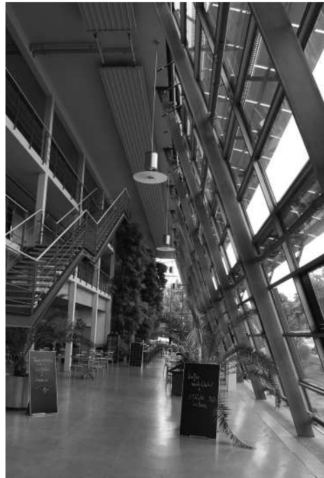
Fig. 2.16: Solar Fabrik, Rolf + Hotz freie Architekten BDA, Friburgo, 1999. Più volte premiato: è un edificio a zero emissioni. Un sistema energetico intelligente copre l'intero fabbisogno di calore ed elettricità tramite energie rinnovabili. La facciata a Sud è totalmente trasparente e schermata da dei brise soleil fotovoltaici.
