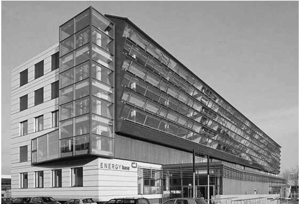
Fig. 2.9: Energy Base Building, POS Arkitekten Vienna, 2008. Questo edificio per uffici è caratterizzato dalla grande facciata orientata a SUD che, attraverso l'interazione con uno scambiatore di calore posto sulla copertura, funziona come un enorme collettore solare. L'edificio ha un fabbisogno globale di energia di 25 kWh/mq anno, con una riduzione dei consumi dell'80% rispetto ad un edificio per uffici costruito in modo tradizionale. Con una riduzione delle emissioni di CO 2 di 200 tonnellate l'anno.
