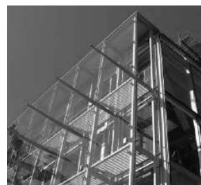
Messa in opera della seconda pelle
