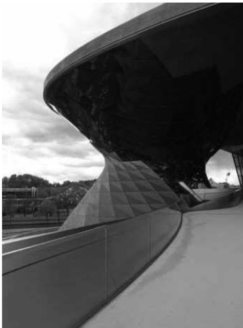
Fig. 2.11: BMW Welt, COOP HIMMELB(L)AU, Monaco, Germania, 2007. Nella doppia pelle dell'edificio è integrato un sistema di tubi radianti che provvedono al suo riscaldamento e raffreddamento. La copertura è completamente rivestita da pannelli fotovoltaici che producono parte dell'energia elettrica di cui ha bisogno l'edificio.
