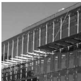
Installazione della pelle interna
