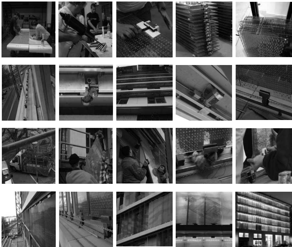
Fig. 3.13: Homo Lumens, Lánchíd 19 hotel, Budapest. László Benczúr, Péter Sugár, László Kara. Si tratta di un progetto di ristrutturazione architettonica di questo vecchio edificio in cui i progettisti hanno scelto di realizzare questo sistema di facciata doppia pelle costituito da 150 lamelle verticali di vetro serigrafato, che attraverso un sistema di controllo garantiscono diverse conformazioni geometriche in relazione alle stagioni dell'anno, creando una buffer zone davanti alla facciata esistente della struttura alberghiera. La scelta tecnologica ha permesso di ridurre i tempi della messa in opera del nuovo sistema d'involucro e dell'intero cantiere di riqualificazione, concluso in sei mesi.
