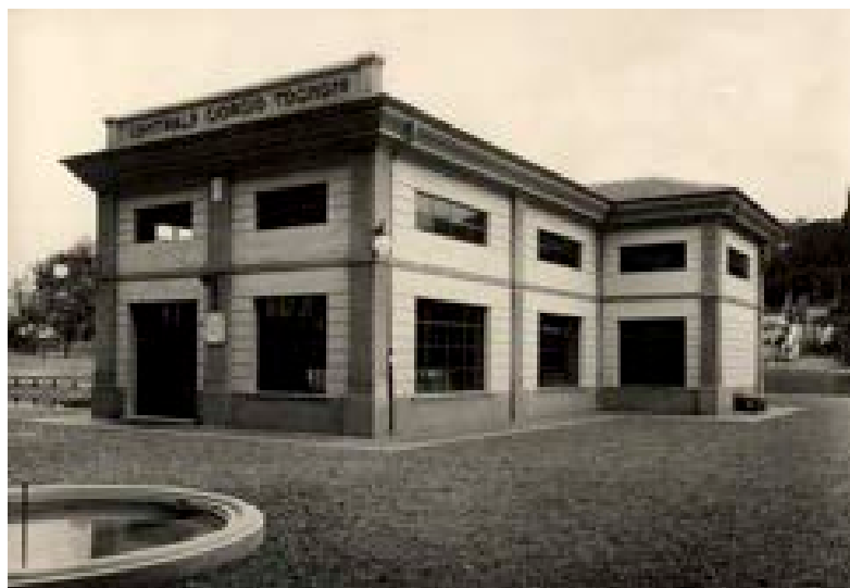
2. Sarzana (Sp), Centrale Generale Tognoni nel 1930 (foto Archivio Consorzio Canale Lunense)
