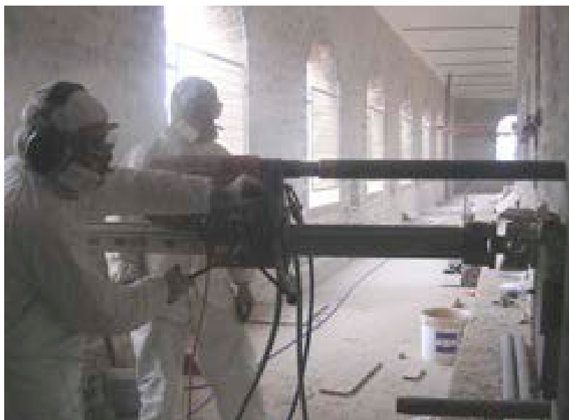
5. Firenze, Palazzo Vecchio, La perforazione dei muri nel camminamento coperto 5. Florence, Palazzo Vecchio, Perforation of the walls in the covered parapet walk
