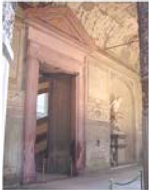
3. Firenze, Palazzo Vecchio, Ricerca della scala del Cronaca 3. Florence, Palazzo Vecchio, Research on Cronaca's staircase
