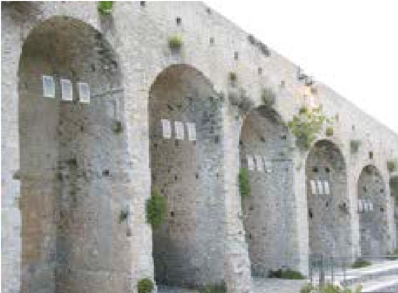
3. Portovenere (Sp), Castello Doria, esempi di "solar flags" 3. Portovenere (Sp), Castello Doria, example of "solar flags"
