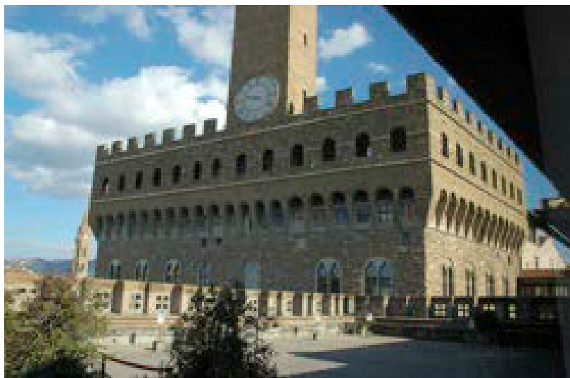
2. Firenze, Palazzo Vecchio, Camminamenti di ronda 2. Florence, Palazzo Vecchio, Parapet walk
