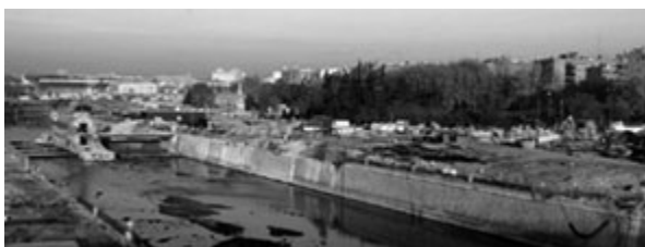
AREA PRIMA DEL PROGETTO: SPAZI DEGRADATI E IN STATO DI ABBANDONO LUNGO IL FIUME MANZANARES
