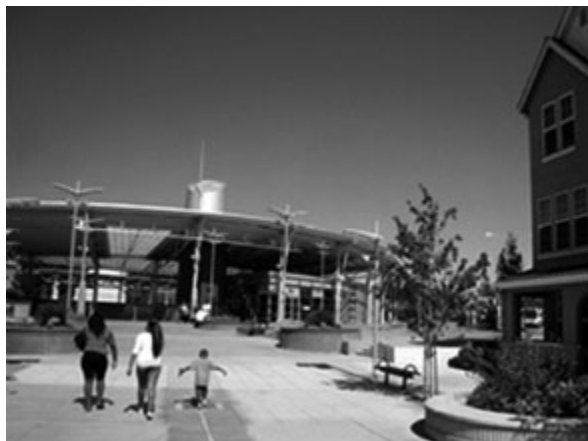
INGRESSO DELLA STAZIONE
