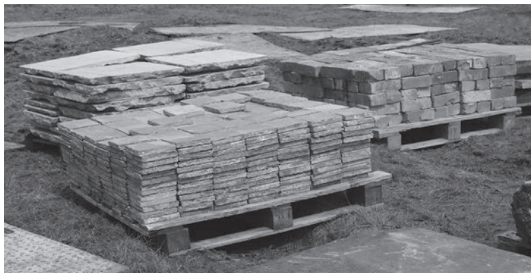
Stoccaggio di materiale recuperato da edifici soggetti a parziale o totale demolizione con tecniche di rimozione manuale. I componenti si prestano perfettamente al riuso, avendo conservato intatti i propri requisiti, e vengono venduti da commercianti specializzati che aderiscono alla rete internazionale SALVO. / Storage of salvaged materials from buildings subject to partial or total demolition and manual removal techniques, sold by dealers who adhere to the British/international network SALVO (Source: original photograph by the author, Maidenhead (UK), June 2012).
