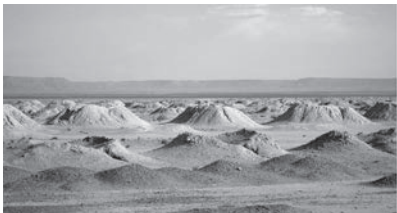
Foum Zguid, Marocco. Esempio di riproposizione del sistema qanat persiano con i pozzi di aerazione caratteristici, ampliamento del qanat esistente. Operazioni di scavo e consolidamento dei canali grazie a pietre e calcestruzzo messi in opera a umido. / Foum Zguid, Morocco. Example of a Persian qanat system with the characteristic ventilation shafts. Enlargement of existing qanat. Excavation and consolidation of channels with stones and concrete (Source: flickr).
