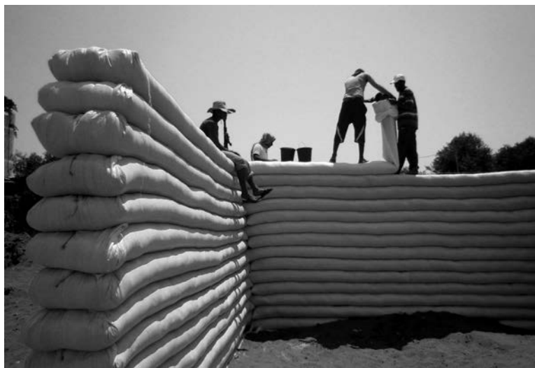
Costruzione della scuola a Um al Nasser, Striscia di Gaza, 2011. Tecnica Earthbags. / Construction of the School in Um al Nasser, Gaza Strip, 2011. Earthbags Technique.
