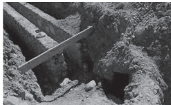
Foum Zguid, Marocco. Esempio di riproposizione del sistema qanat persiano con i pozzi di aerazione caratteristici, ampliamento del qanat esistente. Operazioni di scavo e consolidamento dei canali grazie a pietre e calcestruzzo messi in opera a umido. / Foum Zguid, Morocco. Example of a Persian qanat system with the characteristic ventilation shafts. Enlargement of existing qanat. Excavation and consolidation of channels with stones and concrete (Source: flickr).
