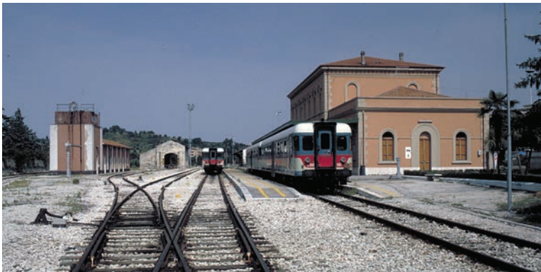
Viste dell'aerea dell'area di progetto. / Views of the project area. Image: Ramiero Carloni.
