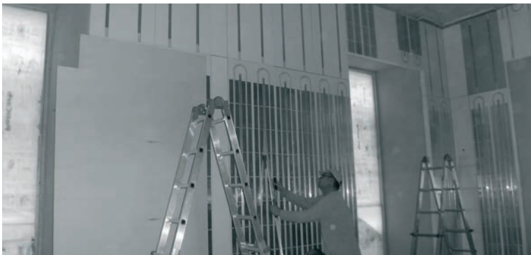
Installazione dei componenti del sistema isolante e radiante nella stanza campione. / Anchoring of the components of the insulating and radiant system in the experimental room.
