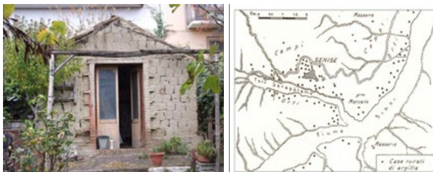
Fig. 1. Fabbricati in “ciucioli” di Senise. In a): manufatto in argilla cruda a un piano. In b): distribuzione case rurali in ciucioli situate in Contrada Pantanello, in agro del Comune di Senise (De Grazia, 1942).
