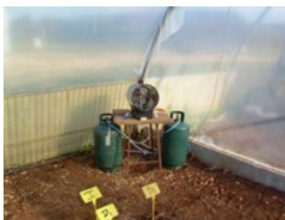
Fig. 3. Generatore di aria calda alimentato a GPL
