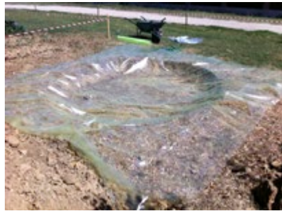
2 - Impermeabilizzazione della vasca
