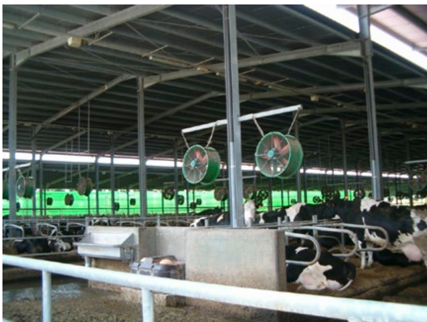
Fig. 11. Accorgimenti strutturali ed impiantistici per la difesa dal caldo.
