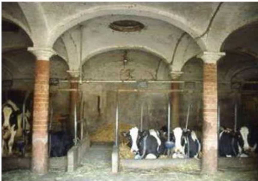
Fig. 3. Stalla ottocentesca con solaio a volta
