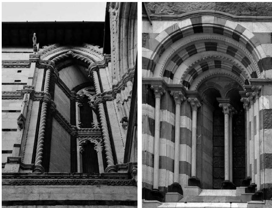
Figure 38. e 39. Due esempi di finestre oblique nella tradizione gotica italiana. Da sinistra: Duomo di Siena, braccio nuovo; finestra obliqua della campata di ampliamento (1339/1357). (Foto D.Arnone). Duomo di San Lorenzo, Genova, finestra obliqua situata sul fronte Sud. (Foto S.Iurilli)
