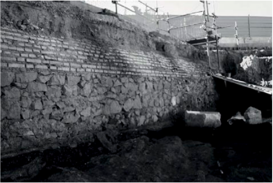
Fig. 38. La galería de servicios que atraviesa el Aula C.
