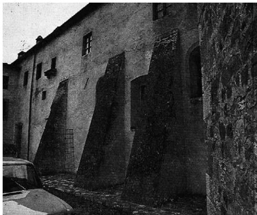
Fig. 36 – Nell'immagine vengono mostrati alcuni pilastri presenti all'interno della Pieve di San Lorenzo a Borgo San Lorenzo (Fi) costruiti inglobando precedenti colonne in riferimento ai danni patiti dalla chiesa dopo il sisma del 1542. Durante i lavori di restauro operati a seguito del terremoto del 1919 furono eliminati i pilastri riportando alla luce le colonne sottostanti.
