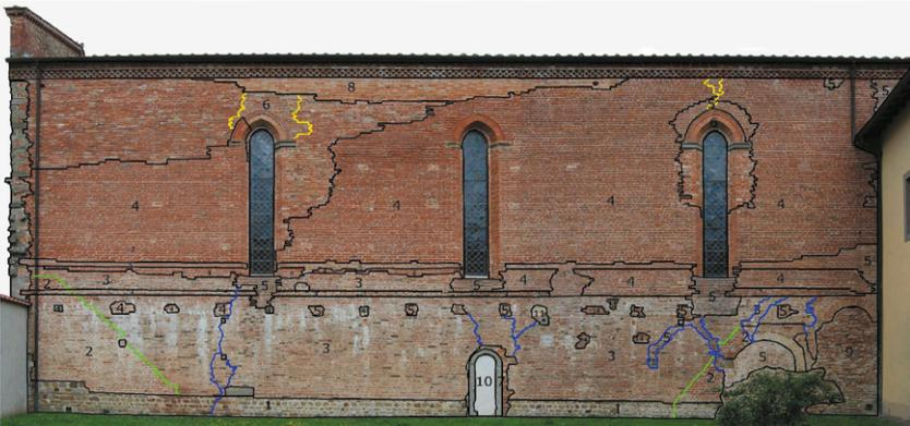
**Lettura stratigrafica e caratterizzazione periodizzata del quadro fessurativo del prospetto sud della chiesa di San Francesco a Borgo San Lorenzo (FI). Le lesioni ai margini del prospetto di colore verde sono riferibili ad un periodo anteriore al 1542; quelle verticali nel centro del paramento di colore blu si riferiscono al terremoto del 1542; quelle nei pressi del tetto di colore giallo appartengono al terremoto del 1919.**
