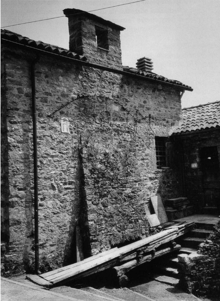
*Fig. 29 – Esempio di arco di scarico. (Fonte: Pierotti 2003, pagg. 50-51)*
