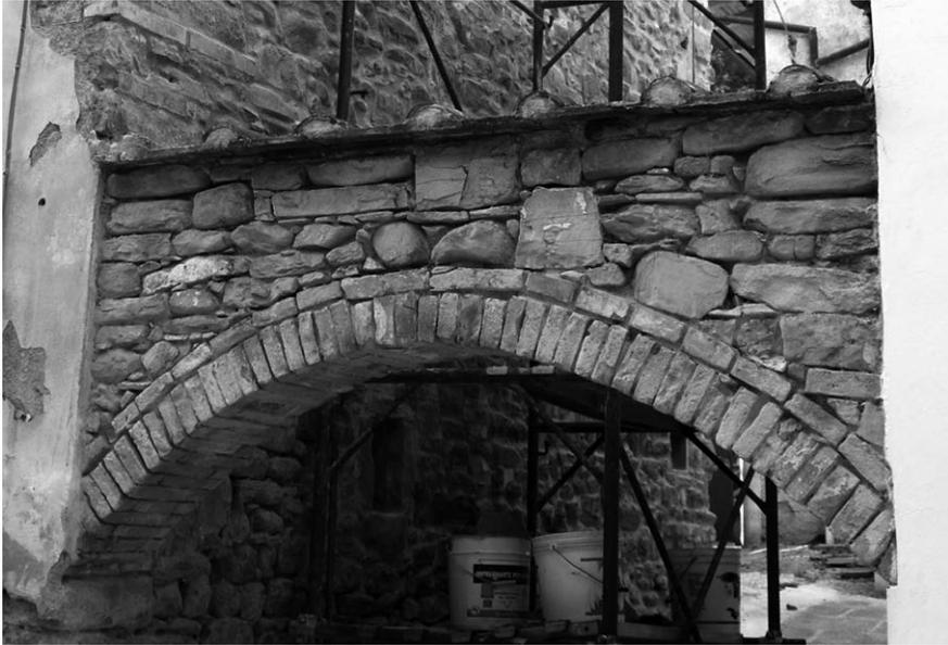
*Fig. 13 – Arco di scarico in laterizi costruito sopra l'architrave della porta di ingresso alla Pieve di San Gavino Adimari (FI).*
