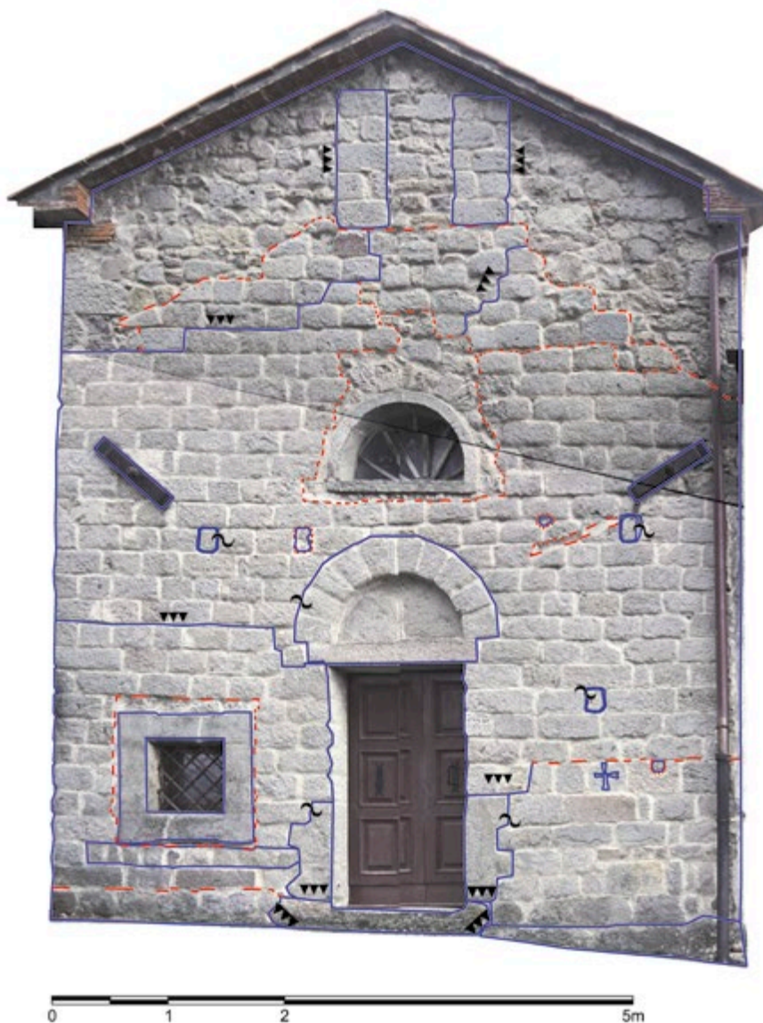
Figura 3 – Pieve di Santa Mustiola. Lettura stratigrafica su rilievo ortofotogrammetrico della facciata.
