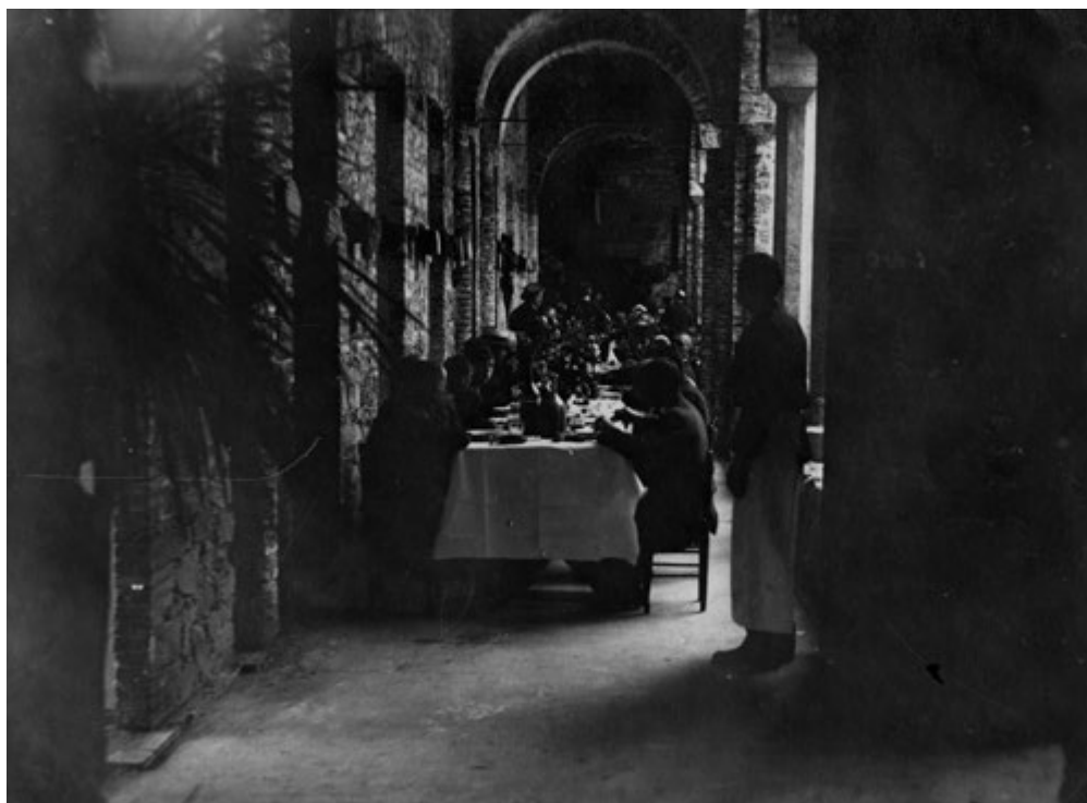
Fig. 14 – Cerimonia per la copertura dell'edificio di Fisica in Arcetri, 24 giugno 1916. Pranzo sociale nel chiostro interno, offerto dal Sen. Torrigiani e dall'impresa costruttrice Giovanni Lazzeri. [Archivio Storico Garbasso]
