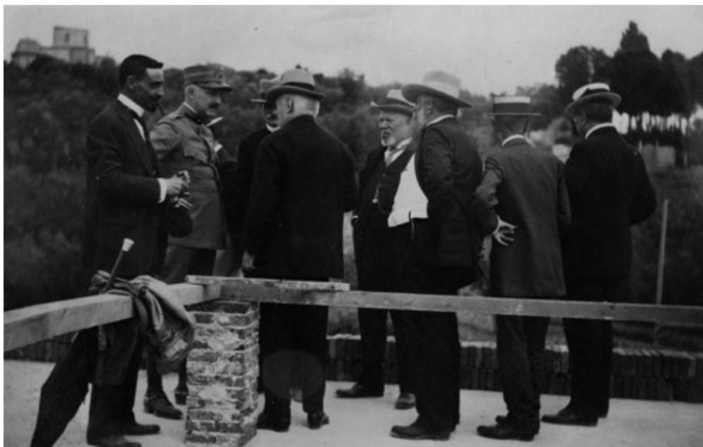
Fig. 12 – Cerimonia per la copertura del tetto dell'edificio di Fisica in Arcetri, 24 giugno 1916. Antonio Garbasso, Direttore dell'Istituto, con colleghi ed autorità. [Archivio Storico Garbasso]
