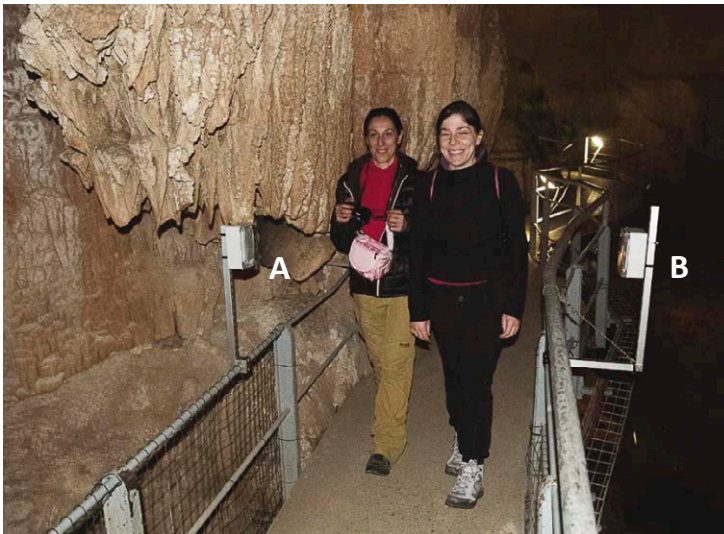
Figura 5 – Trasmettitore ed Emittitore (AB) del contapersone a barriera infrarossa ai lati del punto più stretto del camminamento (foto G. Fasano).
