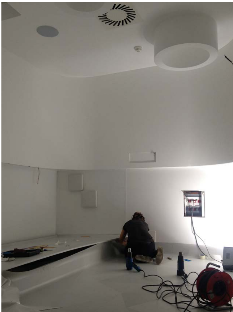
Figura 15. Il rivestimento a pavimento in pellicola vinilica.
