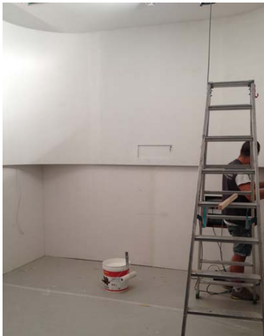
Figura 11. Il sistema di contropareti curvilinee in legno.
