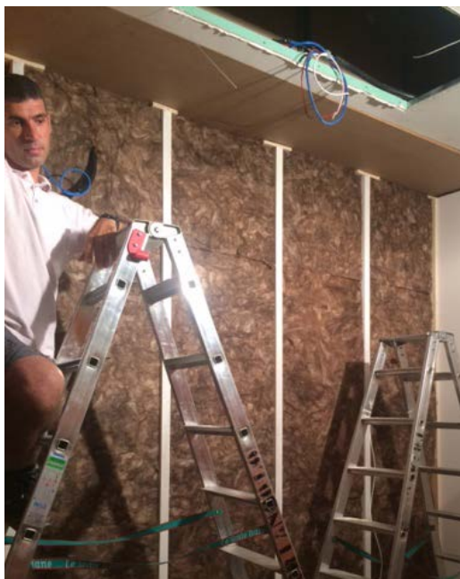
Figura 12. Il sistema di isolamento acustico in controparete.
