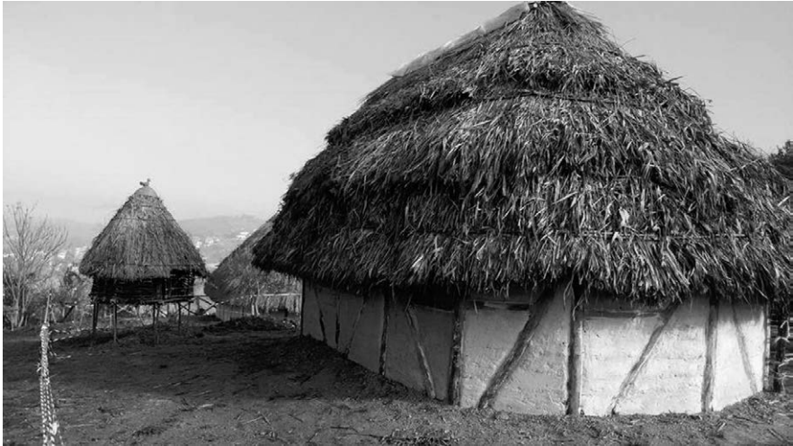
Figura 7 – Le nuove strutture in corso di conclusione.
