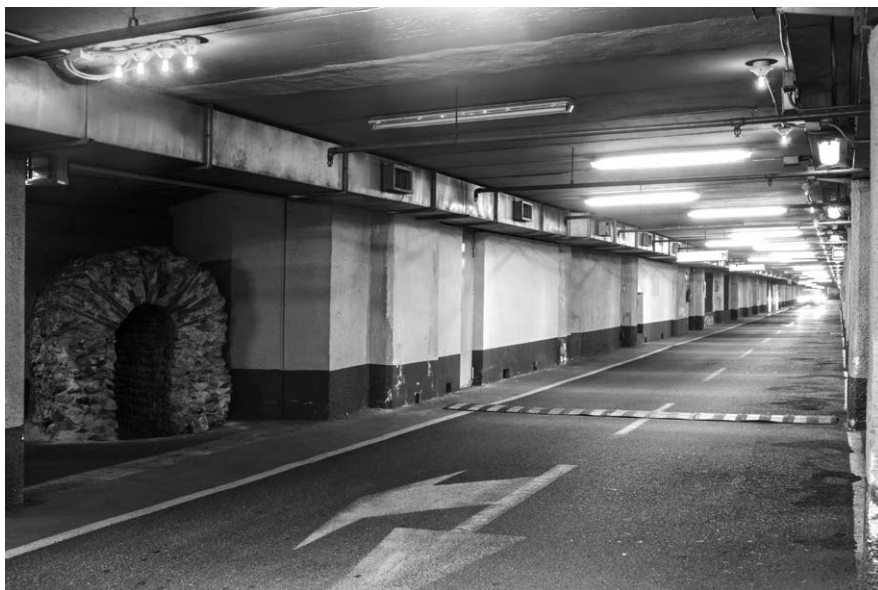
Figura 1 – Andrea Madaro, Una costruzione romana scoperta durante la costruzione di un parcheggio sotterraneo a Torino.
