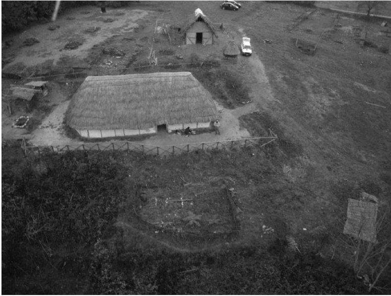
Figura 4 – Archeodromo; lavori in corso dicembre 2015.
