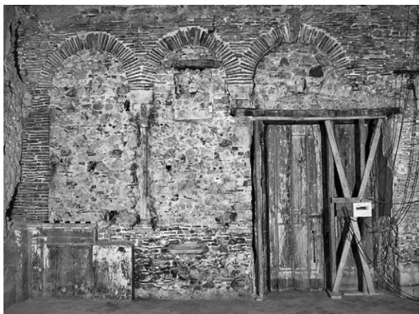
Figura 1 – Salerno: un paramento della cappella palatina di Arechi II all'epoca delle indagini archeologiche. [Peduto 2013]
