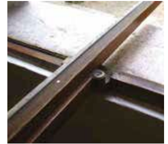
Fig. 41 Dettaglio del bilico di un serramento (AUTIuav)
