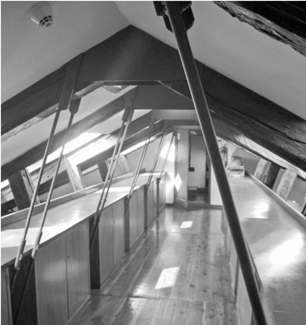
Fig. 38 Passerella tra le capriate dell'ultimo piano nel lato est (AUTIuav)
