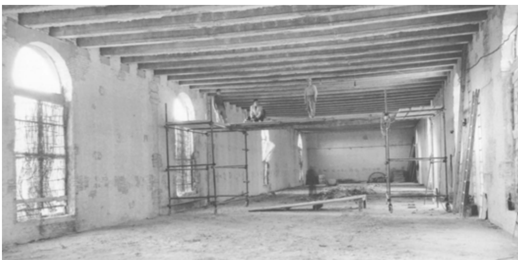
◀ Fig. 29 Cantiere del solaio nella manica sud con i travetti opera, 15 novembre 1962 (AUTIuav)
