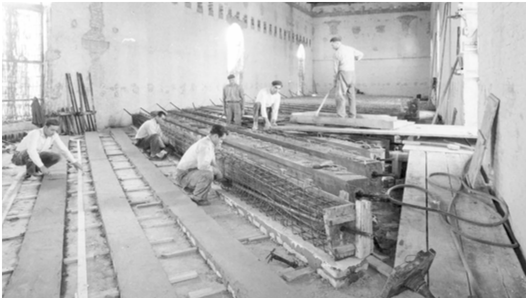
◀ Fig. 26 Cantiere del solaio nella manica sud: confezionamento dei travetti in c.a.p., 9 ottobre 1962 (AUTIuav)
