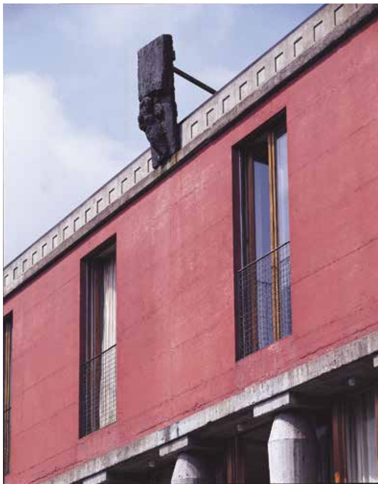
Case a Trübbach , Trübbach-Azmoos 1982, dettaglio della facciata: attacco tra capitello e “trabeazione” (si veda Villa Saraceno ), la tensione della composizione del profilo viene catalizzata dalla scultura di Hans Jasephson, © Studio Märkli.
