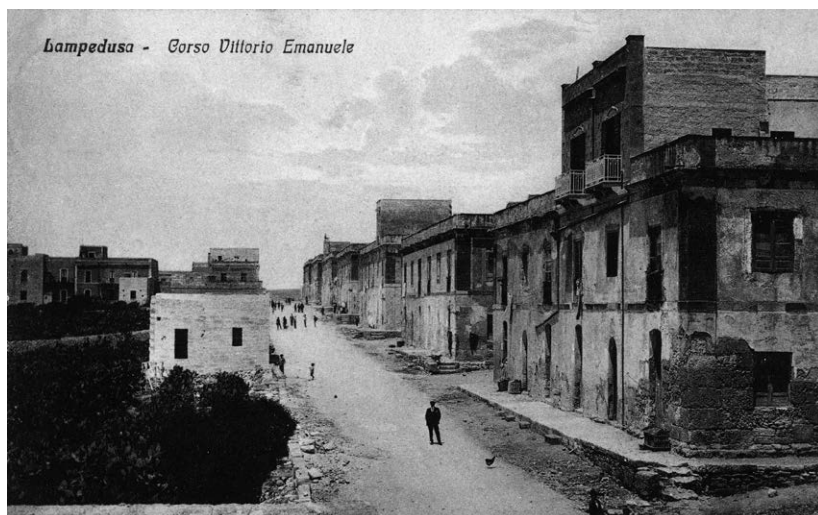
Figura 3 – Lampedusa, primi anni Cinquanta. Via Vittorio Emanuele, la via principale del paese ancora non asfaltata, piena di detriti, le facciate di alcuni dei 7 Palazzi molto degradate. In primo piano il primo dei 7 Palazzi, tra via Anfossi e via Doria; sulla sinistra una piccola costruzione che sorgeva dove ora si trova il resort “il Moresco”. [Fonte: Archivio Storico Lampedusa]
