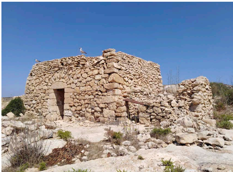
Figura 5 – Un dammuso monolocale nella zona di Imbriacole. [Fonte: G. Surico]
